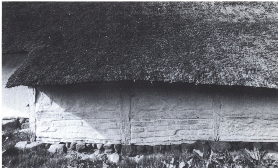
I Pebringe gårdens ladeudskud er der både lerklining for oven samt udmuring med kridtstensblokke og med kalkstensbrud – ballinger – i de nedre tavler.
