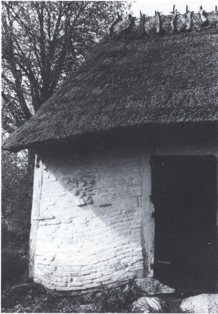
Der er mange prøver på udfyldning af tavl i Pebringe gårdens bindingsværk, – hér både marksten og tegl, og man ser, i hvor høj grad, faget har måttet lempes efter terrænet.
