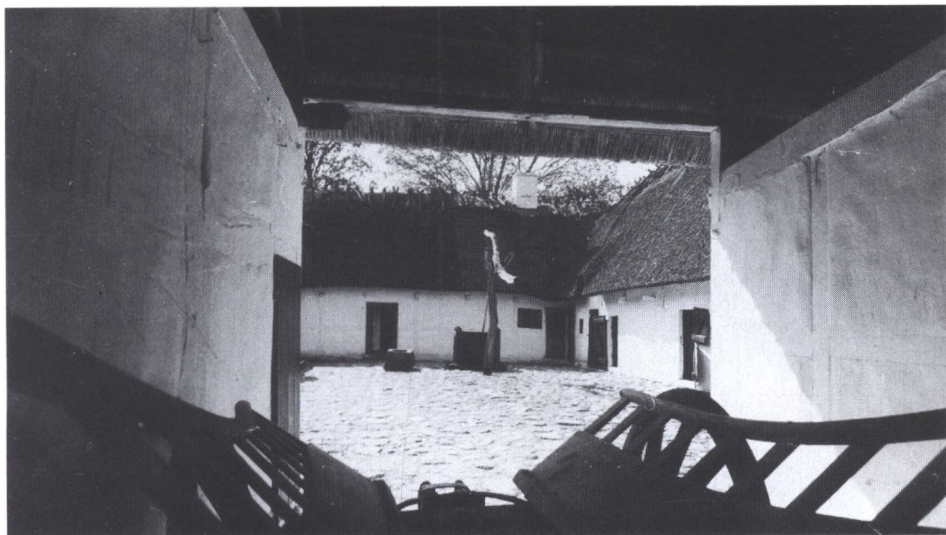
Gårdsrummet i Falstergården i Lolland-Falsters Stiftsmuseum. Man ser tagremmen under stråtaget, hvor der til spærenes afstøttelse er opsat en pløk på hver side.
