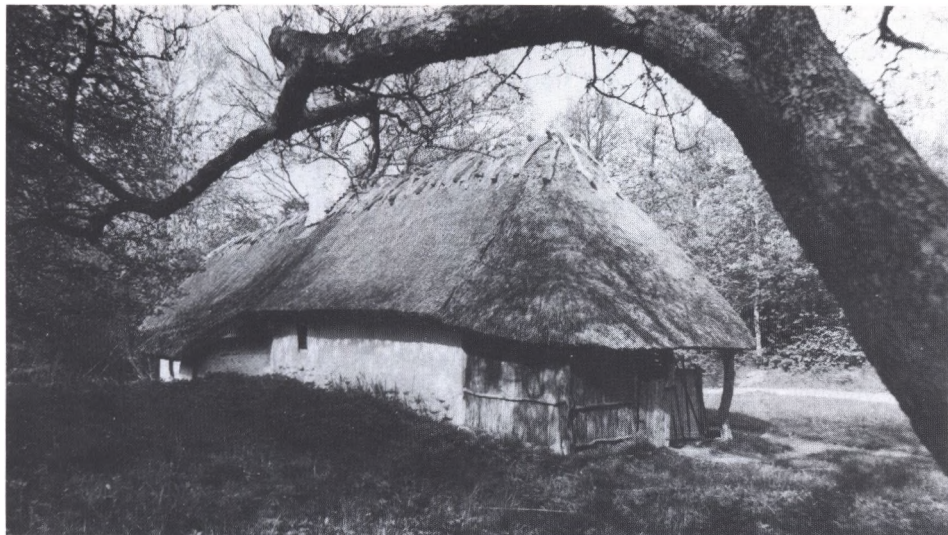
Lude på væverhus fra Tystrup, nu i Frilandsmuseet i Sorgenfri. Konstruktionen er opbygget med brædder fastholdt af tværgående bånd, – faktisk blot nogle naturgroede stave. Den ene side af luden er åben, og taget bæres oppe af en stolpe. Der er bås til en gris. Som alle andre sjællandske bondehuse og gårde har dette kun een skorsten.
