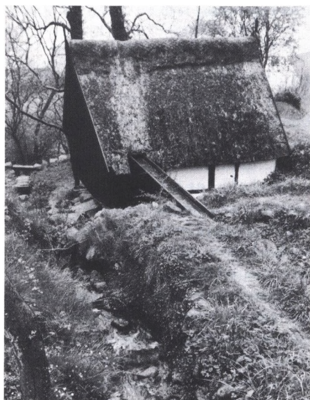
Ved flere bornholmske gårde havde man små gårdmøller. Denne hedder Vang mølle og ligger ved en bjergbæk med stærkt fald. Der behøves ingen mølledam.
