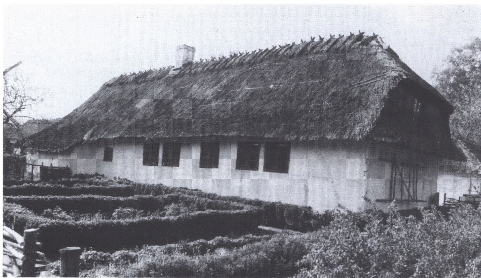
Dannemare-huset på Frilandsmuseet i Sorgenfri. Man ser, hvordan det tækkede parti under tagets halv valm svejfer ud og danner en skyne, – et læsted, hvor have-, og markredskaber kan ophænges. Taget er med krag-, eller vårtræer.
