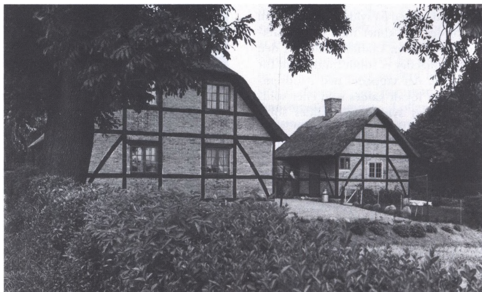
Hus og udhus nær Halsted på Lolland. Der er brugt ranker i hjørnerne. De støtter mod stolpe nr. 2.
