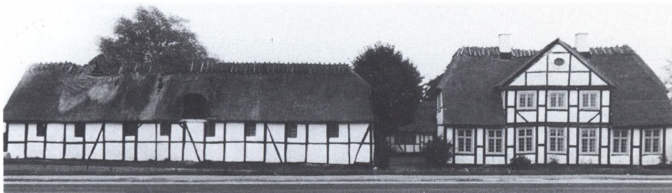
Stormbånd eller ranker ses også på sjællandsk bindingsværk. Avlsbygningen på denne smukke gård mellem Helsingør og Hillerød har en del – omend spinkle ranker. Hovedbygningen har i den brede gavlkvist et par små halvranker.
