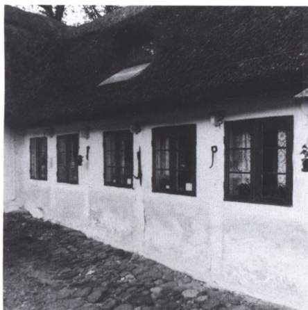
De sjællandske gårde var ikke rige på tømmer, og på mange gamle huse mangler fodremmen, som det bl.a. fremgår af dette foto af et stuehus fra 1629 i Kallinge.
