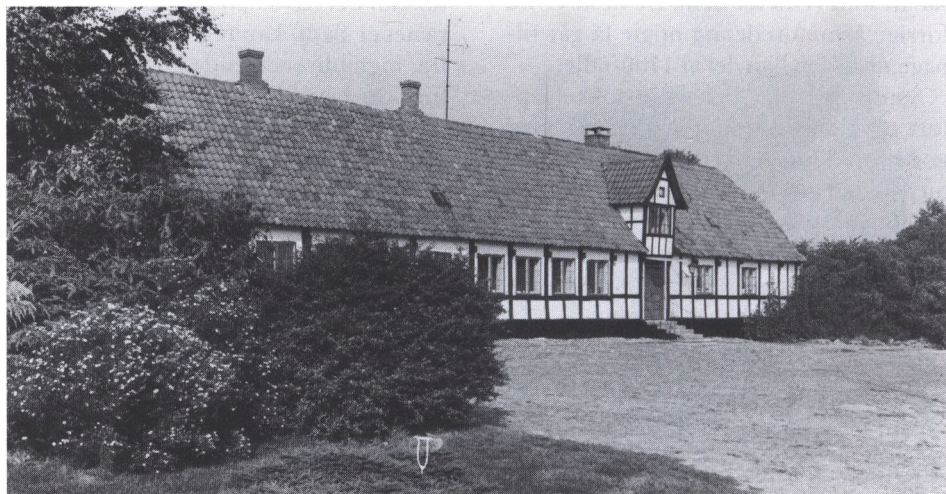
Der er gerne ret brede fag i de bornholmske bindingsværksbygninger, men de kommer til at virke smallere, når der som her, på Kofoedgaards stuehus, er opsat en dokke midtvejs i hvert fag. Over hoveddøren ses en lille gavlkvist. Som alle bornholmske bindingsværkshuse har den gennemstukne bjælker.
