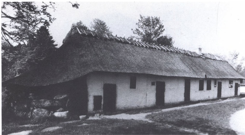
Enlænget husmandssted fra Taagense på Lolland. Her er udskudet ualmindelig dekorativt. Det er opbygget af vældige marksten, og det udsvejfende tag holdes oppe af stolper mellem stenene. Frilandsmuseet i Sorgenfri.
