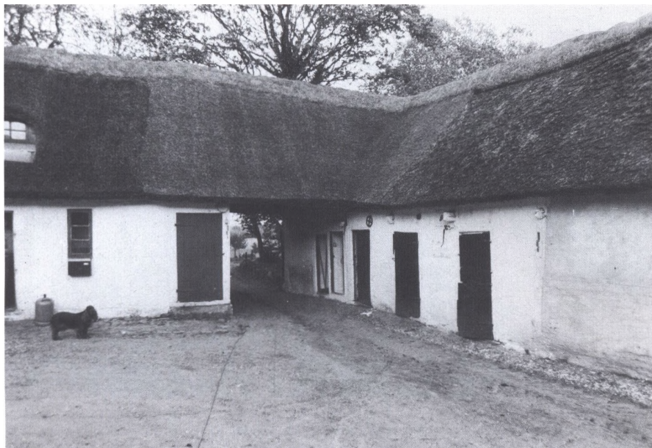
Det sjællandske landbindingsværk bør inde i landet stå helt overkalket, som det gør på denne gård ved Roskilde.
