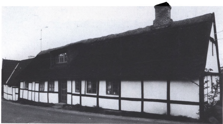
På Roskildeegnen blev der oprindeligt lagt tørvemønning på en del huse, og de er så senere blevet halmdækket, men kragtræer er det aldrig blevet til. Hus i Herslev.
