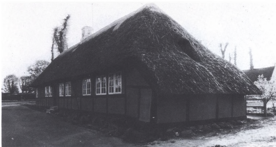
En lang beboelseløng med udskud i den ene ende. Engestofte hospital fra 1730-erne. Den er rødkalket med sort afstolpet tømmer og hviler på en høj syld.
