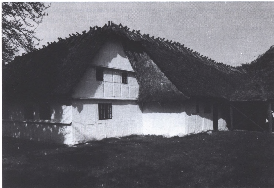
Lolland-Falsters Stiftsmuseums Falster-gård er et herligt anlæg med mange snurrige detaljer. Således er stuehusets gavl vokset sammen med staldlængen på en såre malerisk måde. Bemærk det overkalkede bindingsværk og dryplælene.
