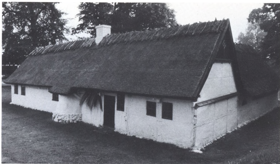
200 år gammelt husmandssted fra Helsingørskanten, nu i Nordsjællands Folkemuseum i Hillerød. Bjælkerne er her i nogle tilfælde glammede sammen med stolperne. Der er dryppjæl i gavlen og syld uden fodtømmer. Væggene er overhvidtede. Bageovnen med sokkel af marksten dækkes for oven af et tagudhæng.
