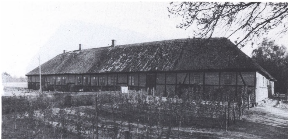
Det lidt tørre bindingsværk i en gård nær Krænkerup lives op af en dodenkop afstolpning af tømmeret og hvidtning af fugerne mellem teglstenene.
