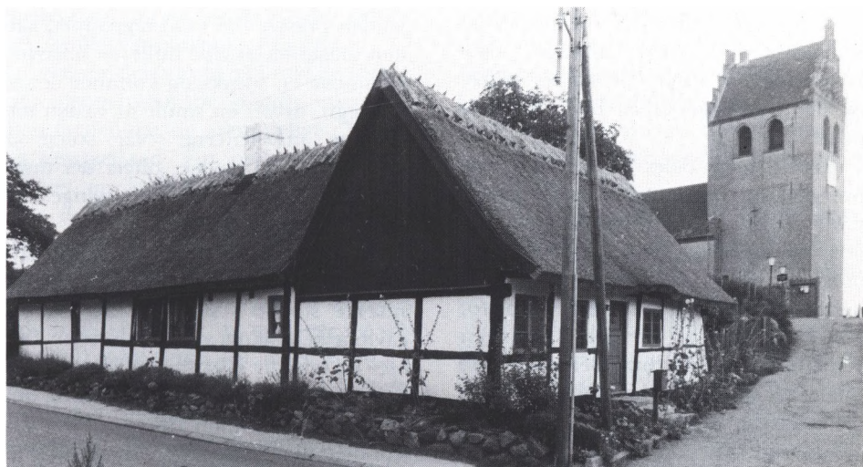
Hus ved Jørlunde kirke med skalkestøttet tagskæg, der selvfølgelig svejfer elegant ud for neden. Gavltekanten er her brædeklædt med een på to, – en konstruktion, man næsten altid har valgt ved senere restaureringer, fordi den gør huset mere tæt. Oprindeligt var det almindeligst blot at sidestille bræderne.
