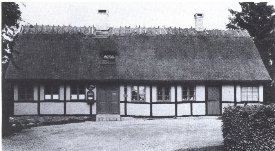
På det meste af Sjælland bruger man at sætte halmmønning på taget og »låse« den med kragtræer som på dette hus i Jydstrup.
