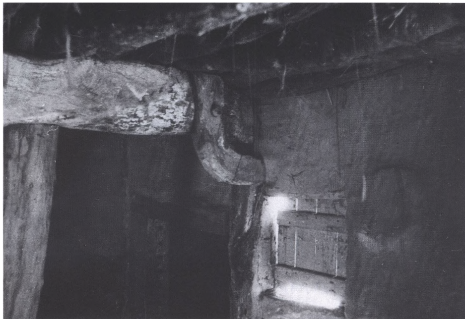
En anden sælsom detalje fra Falster-gården: En bjælke er afstøttet med et krumt kobånd. – En betænkson konstruktion, der næsten ingen plads tager.
