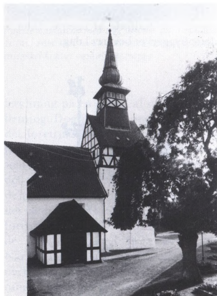
Nexø kirke er særdeles røjnefaldende med tårnets bindingsværksoverdel, tagrytter med bindingsværk og våbenhus i bindingsværk. Tømmeret er tjæret og tavlene er hvidkalkede.
