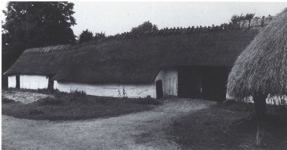
Den prægtige Pebringe gård, nu på Frilandsmuseet i Sorgenfri, er et anlæg, der er blevet til over flere etaper. Den ældste del er fra det tidlige 1600-tal. Anlægget rummer et utal af spændende bygningskonstruktioner, og et langt udskud giver bedre plads i laden.
