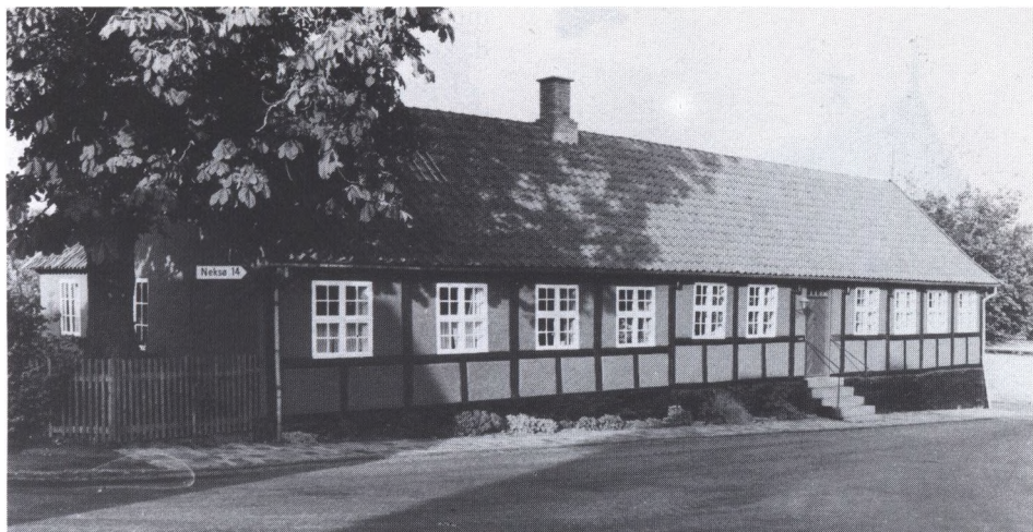
Om – og tilbygninger på huse røber sig ofte ved forskydninger i bindingsværket som her i Aakirkeby.
