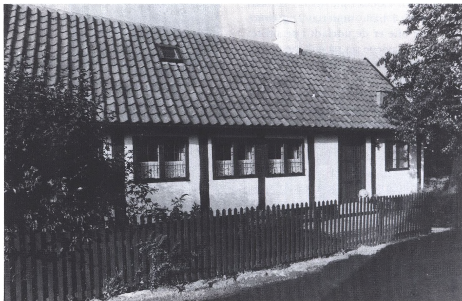
Hus i Aarsdale af den typiske mere spartanske klasse, hvor der udvendigt kun ses stolper og tagrem. I huse af den art er der ofte et indvendigt sidebånd.
