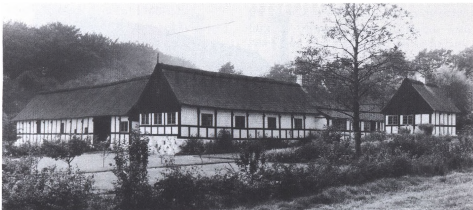
Den fornemme bornholmske gård på Frilandsmuseet i Sorgenfri. – Damaskegården – hvis stuehus rejser sig på en høj sokkel og har udskud i den ene ende. Bemærk, at gavltrekanter, der er bræddeklædt, er afstumpet i siderne. Fodremmen forløber – som karakteristisk for øens bindingsværk – i to plan. De går længst ned på langsiderne.
