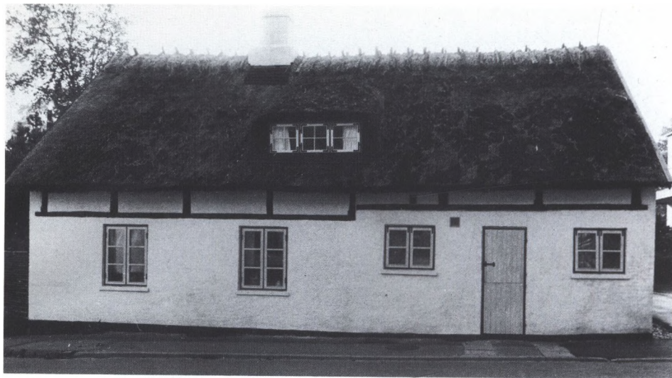
Bindingsværks-overdel i ellers grundmuret hus. Farum.
