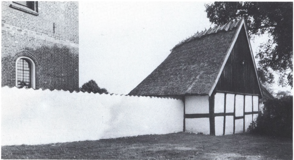
Ofte ender gavltrekanter for neden med en lille drypsfæl eller vandnase, om man vil, og den bæres oppe af diminutive knægle. Kirkeladen i Farum.
