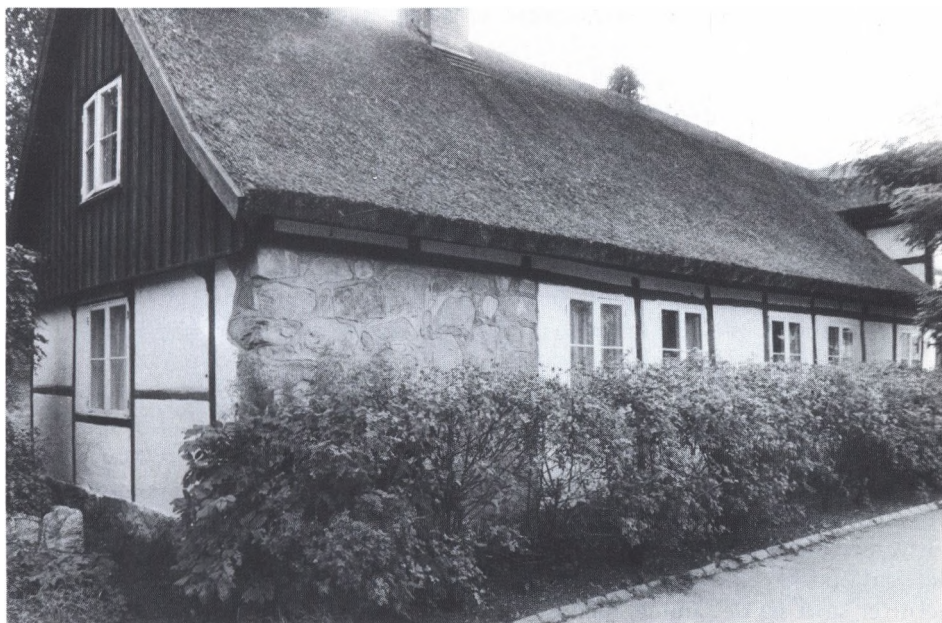
Man kunne nok improvisere lidt i de sjællandske bindingsværkshuse, som hér i Farum, hvor der engang indsatles et vægstykke af kløvninger i bindingsværks-langsiden.
