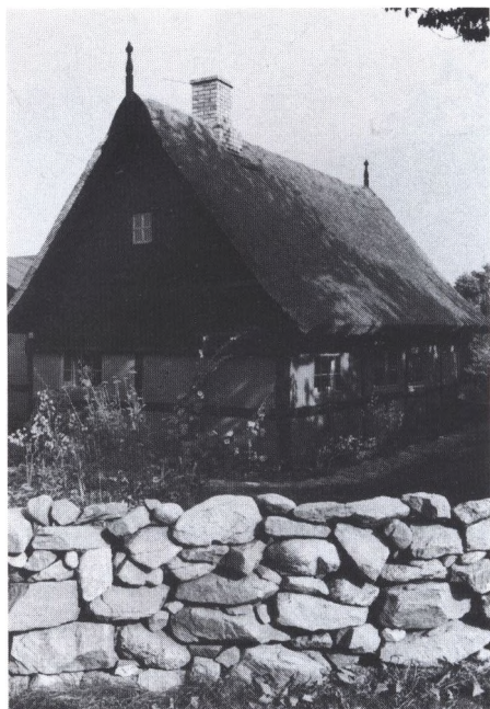
Dette nydelige fiskerhus i Bølshavn har endnu stråtag, der efter bornholmsk skik er uden kragtræer. Derimod er der husbrand i hver gavl – smukt udsavede endda – udsavel vindskede og bræddeklædt gavl.
