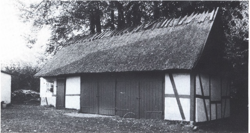
Vognport og redskabshus på Farumgaard. Stormbåndet går her fra fodrem til lagrem og berører overhovedet ikke stolperne.
