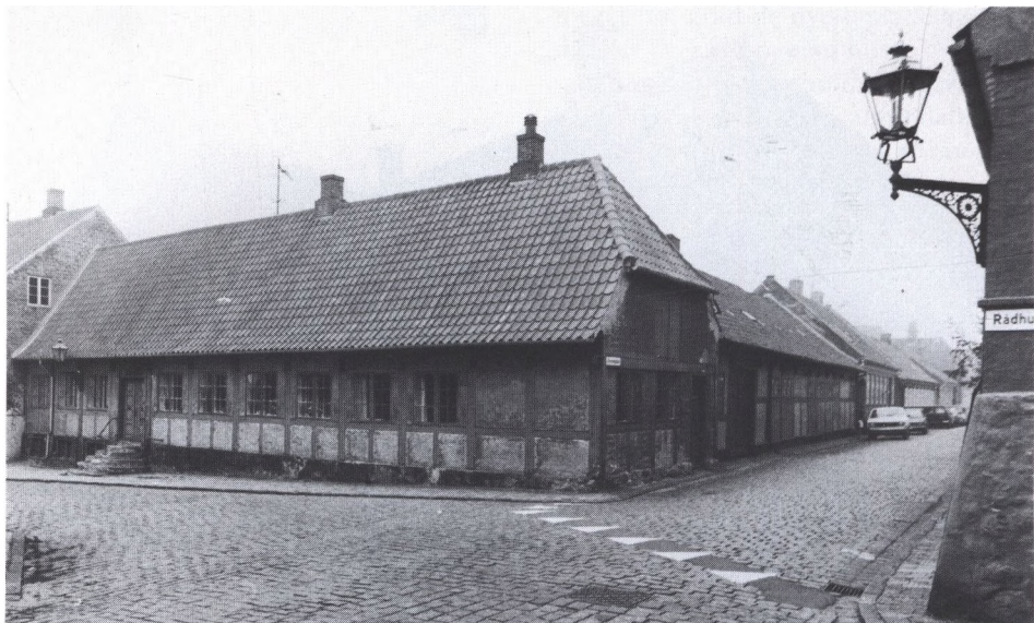
Væggene blev pudsede, så sten og fuger dækkedes, inden der blev kalket med en eller anden farve. De pudsede vægge ses her på en gammel gård i Grønnegade i Rønne.
