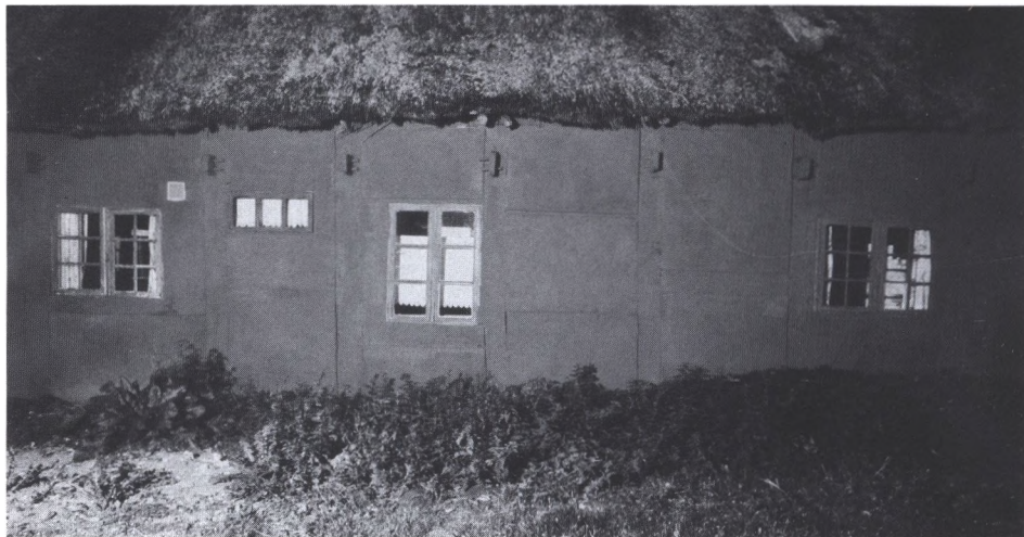
Del af »Røde gårds« stuehus. Man ser det kraftige tømmer, som her er anvendt i ret rigelige mængder. Og selvom gården er rød, følger den alligevel god sjællandsk skik, hvor både tavl og tømmer er overstrøget. Bemærk de gennemstukne bjælkehoveder og de meget små vinduer.
