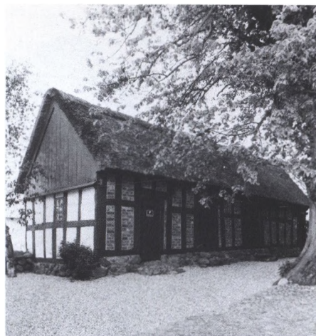
Danmarks muligvis ældste bindingsværkshus findes ved præstegården i Feldballe på Djursland. Det er middelalderligt, – evt. fra 1400-årene, måske endda ældre. Tømmeret er ekstremt tykt.
