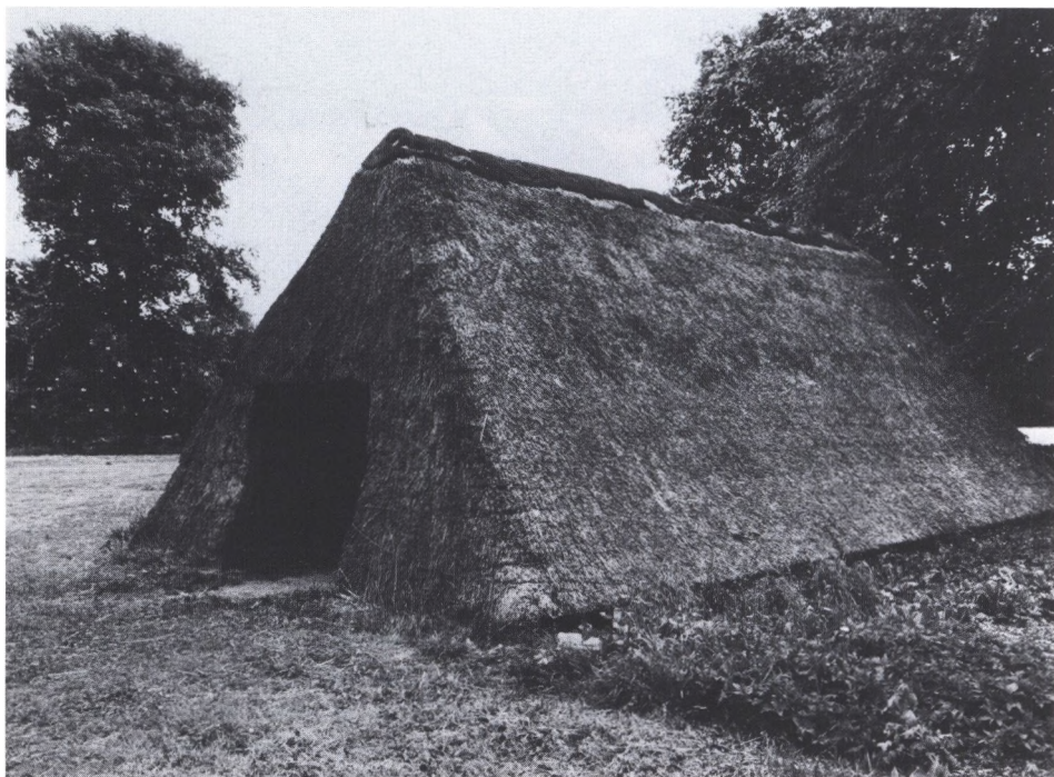
Større spændhus på Herning Museum. Det har fungeret som vognport og har også lækte gavle. Man kendte også meget store spændhuse, der f.eks. brugtes som lader.
