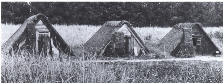
Tre små spændhuse fra den jyske vestkyst, nu på Frilandsmuseet i Sorgenfri. De har været brugt som sommerbeboelser af fiskere og sildepiger, de har ildsted med græstørveskorsten og bræddeklædt endevæg.
