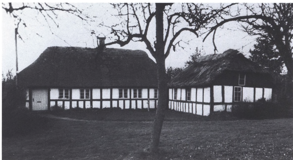
Halvvalm på »krumt sted« ved Skanderborg. Det nederste af gavlen er brædeklædt.
