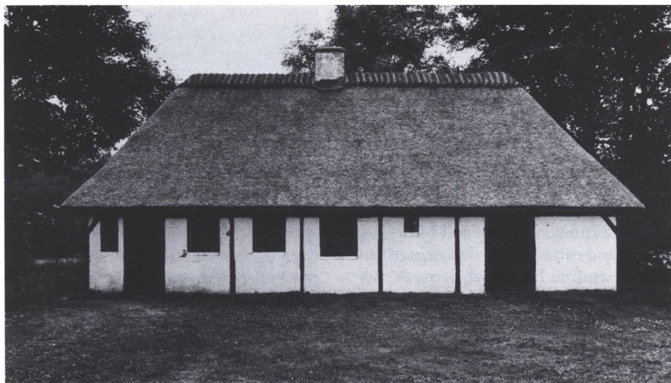
Selv i meget fattige egne fik huse tage af ren strå eller af tagrør, hvis det nødvendige materiale var for hånden. Dette landarbejderhus fra Midtjylland – nu på Herning Museum – har f.eks. fået et fint stråtag med helvalm. Tømmeret er derimod uendelig sparsomt uden løsholter, dokker og fodrem, og sagene er brede.
