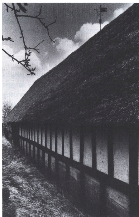
Langside af lade i Trelde. Her er der endnu hele vejen hen bevaret bulfjæle i de underste tavl. – Desværre et særsyn i dagens Danmark.
