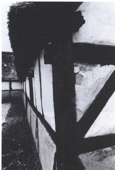
Hjørne af gammelt stuehus fra Høgild, nu i Herring Museum. Af stolpehullerne i gavlen kan man se, at tømmeret tidligere har siddet i et andet hus. Det lille skråbånd for oven – swarbond, er karakteristisk for det vestjydske og midtjydske bindingsværk.
