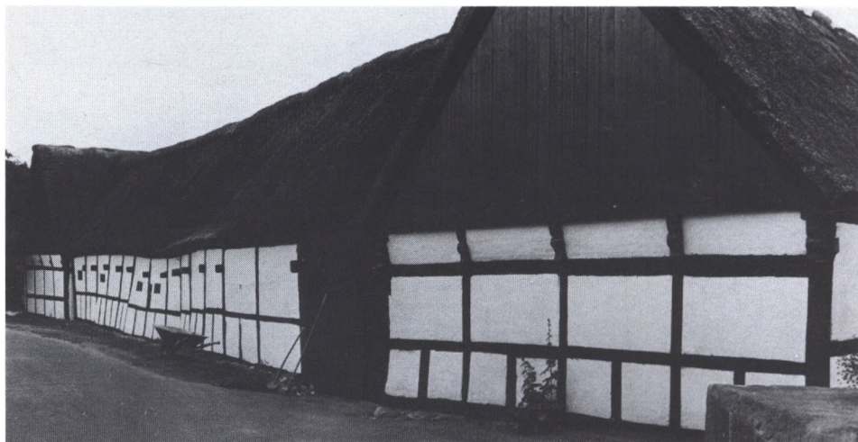
Typisk samsisk gård med fjælegavl båret af profilerede knægte. Bygningerne har gennemstukne bjælker. »Kræmmergården«.
