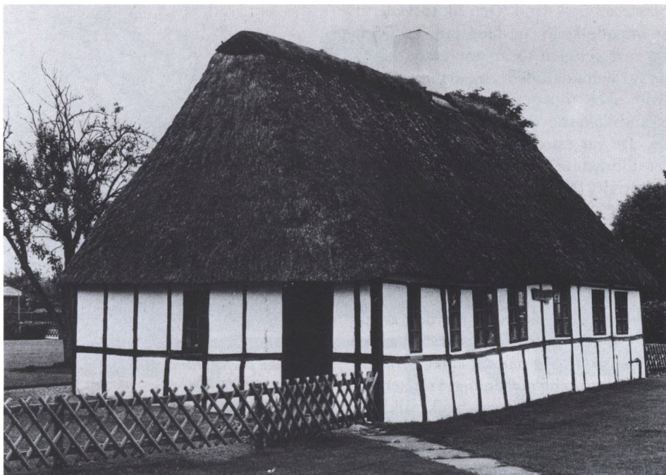
I Vorbasse findes dette lille, enkle hus med stråtag og magert bindingsværk. Der er dog blevet råd til en gang hvidtning. – Et glimrende eksempel på midtjydsk bindingsværk. Bemærk den meget stejle gavlf, der snarere er en stråklædt gavltrekan end et valmtag.
