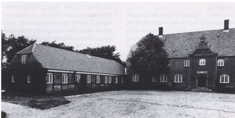
På herregården Kaas i Salling har man en 1700-talsfløj med bindingsværk og teglsten, der sikkert er brændt på lokaliteten.
