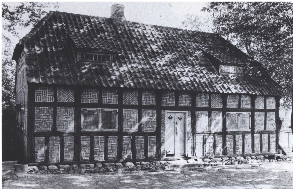
Nydeligt hus fra Ringkøbing med fyrretræsbindingsværk og mønstermuringer i tavlene. Der er stadig gennemstukne bjælker, og dertil små knægte. Huset, der nu findes på Ringkøbing Museum, er antagelig fra begyndelsen af forrige århundrede, måske lidt ældre.
