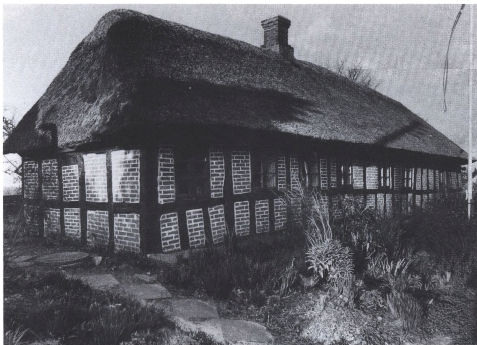
Østjydsk farveglæde, – lille hus i Boes, hvor der er malede mursten og hvidtede fuger.
