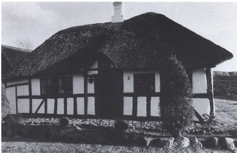
Lille hus fra Illerup opført 1837 efter landsbyens brand. Der er blevet plads til en lille stråtagkvist over hoveddøren, og taget skræner opad i den ene ende for at kunne forbinde sig med en tværtånges lidt højere tag.
