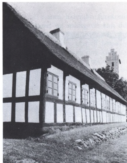
Hus i Dråby, hvor de gennemstukne bjælker i en del af huset tydeligt ses. Mellem gennemstikningerne og lagremmen ligger styrterummet.
