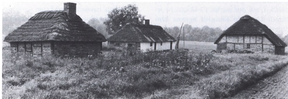
Frilandsmuseets Vemb-gård er vistnok den eneste endnu bevarede midtjydske parallelgård. Tagene er typiske blandingstage med halm og lyng. Det lille hus i forgrunden er en smedje. Frilandsmuseet i Sorgenfri.
