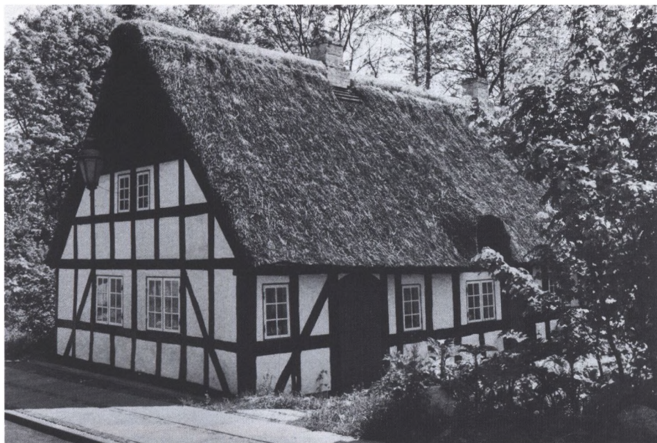
Det hænder også, at skråbåndene -rankerne støtter mod anden stolpe, som det også oftest ses på Fyn. Hus i Femmøller på Mols.
