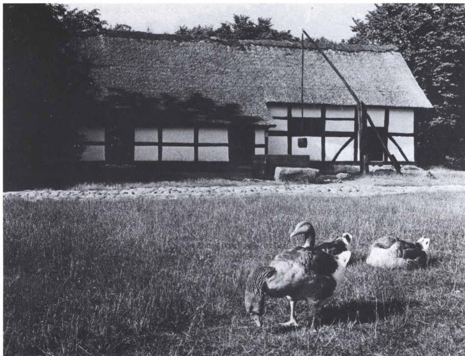
Vinkel-gården på Hjerl Hede. Danmarks ældste bondegård, som går tilbage til første halvdel af 1500-årene. Intet overdådigt bindingsværk, men dog med godt og kraftigt egetømmer. Stuehus-afdelingen er højremshus uden udskud, avlsforlængelsen er med udskud på begge sider.
