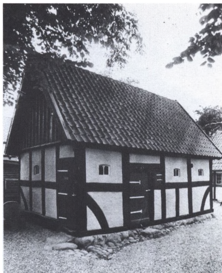
Halvranker kendes også i Østjylland, selvom man sjældnere ser dem her. Dette hus fra Barrit fra 1688 har buede halvranker i hjørnerne og iøvrigt sulekonstruktion. Glud Museum.
