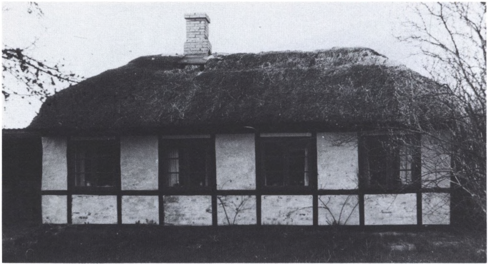
Lille beboelseshus mellem Sindal og Astrup. Tømmeret er spinkelt og sparsomt anvendt. Det er afstolpet med sort, og tavlene er okrede. Bemærk det meget flade valmtag, som ikke giver vinden mange angrebspunkter.
