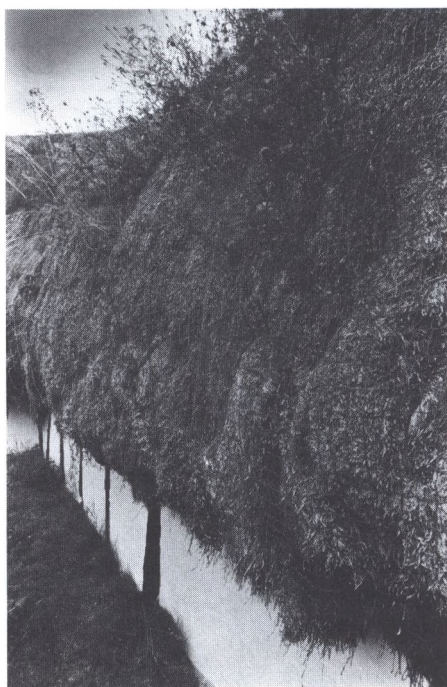
I egne, hvor der blev drevet fiskeri, som på Læsø, hændte det, at der lagdes et gammelt fiskenet over taget, for at holde lidt på det flyvske materiale. Det er sket på Hjemstavnsgården i Byrum. Ud over denne herlighed har taget en rig flora og fauna. Der ruger bl.a. gravænder i det, og det er nu så hyggeligt.
