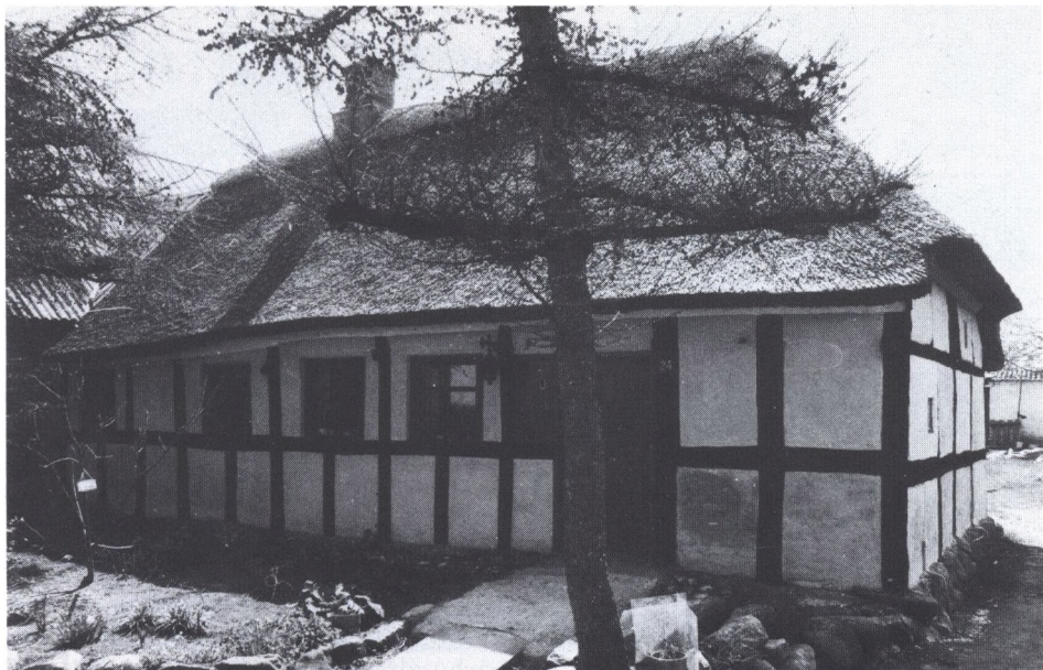
De fleste steder i Himmerland har man sparet fodtømmeret. Stolperne står direkte på syldstenene som i dette hus fra Mou.
