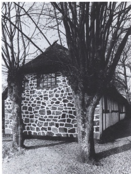
En lidt usædvanlig sammensætning: Gråstensgavl med kløvede sten og langsides i Bindingsværk. Støvring ved Randers.
