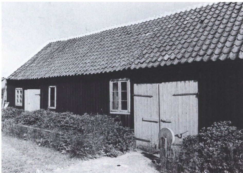
Det fjæleklædte bindingsværk med én på to -konstruktion var meget udbredt i Skagen, men er nu i stor udstrækning erstattet af grundmurede vægge.
