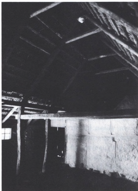
Højremskonstruktion set indefra. Det er fra Aggerhuset på Frilandsmuseet i Sorgenfri.
