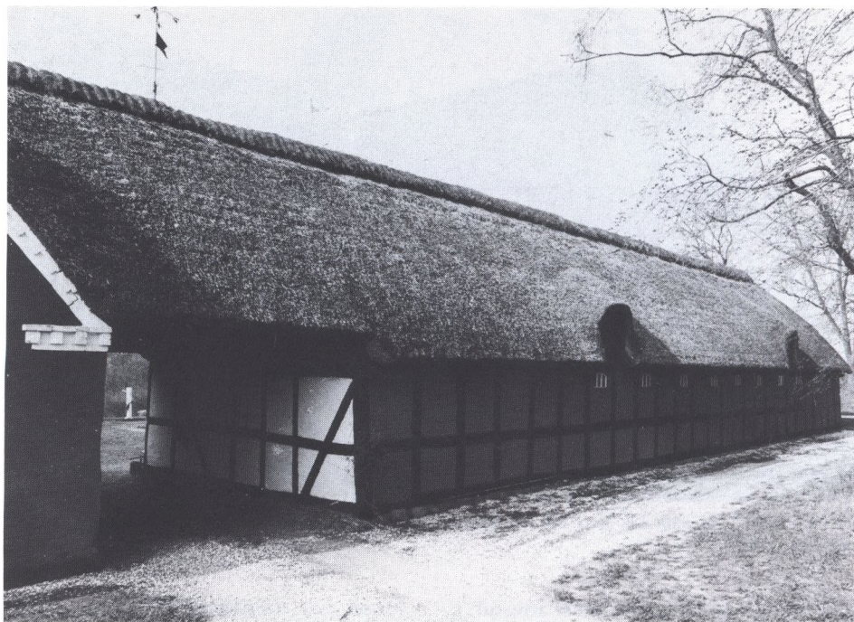
Ommersyssel er en farveglad egn: På denne smukke og velholdte gård i Østrup er væggenes tavl rødalkede, tømmeret er sort afstolpet, og i portgennemkørslen er tavlene blevet hvidtede, hvad der får det hele til at se så lyst og venligt ud.
