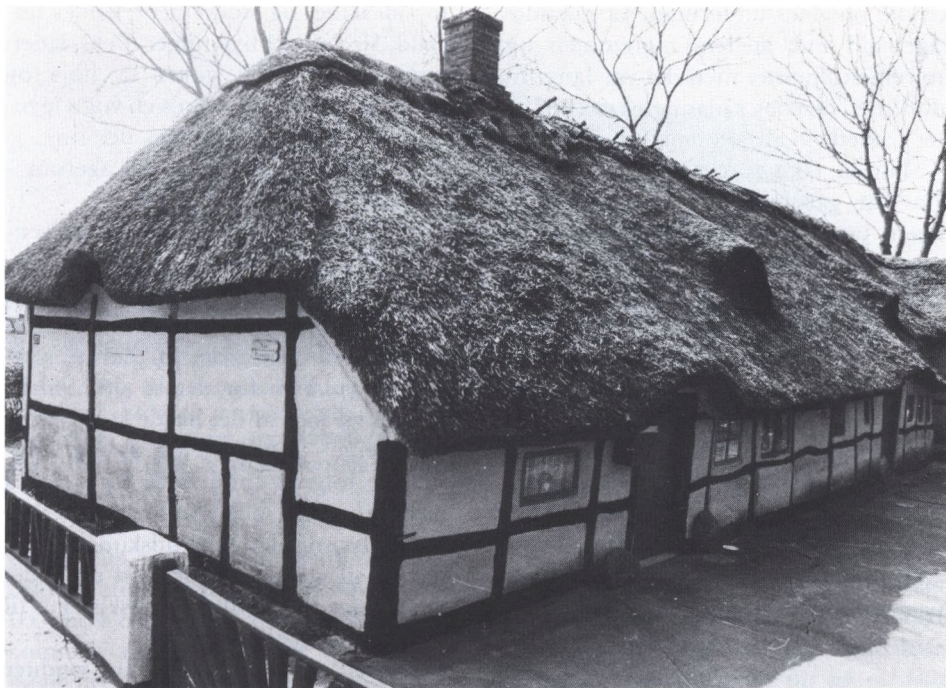
Gammelt hus i Gerå, – i dag ravnemuseum. Der er kun udskud på den ene side. Bemærk springet i gavlens tømmerkonstruktion, og hvor små man har måttet gøre vinduerne i den lave væg.
