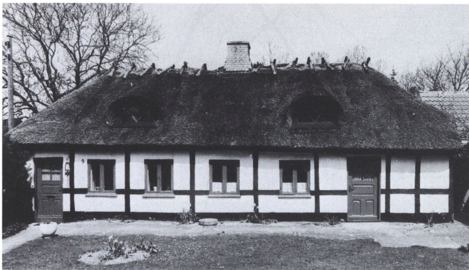
Dette hus er ganske vist fra Mou, som ligger lige syd for Limfjorden, men dets tag er lige som husene nord for Limfjorden ganske lavt og med afvalmninger, der går langt ind, hvilket skyldes hensynet til det meget blæsende klima i de egne. Kragtræerne er en senere tilkomst.
