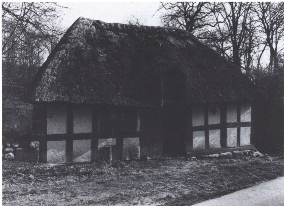
Miniaturehus under Støvringgaard med brunt afstolpet tømmer og okrede tavl. Bindingsværket er enkelt, men tømmeret svært.
