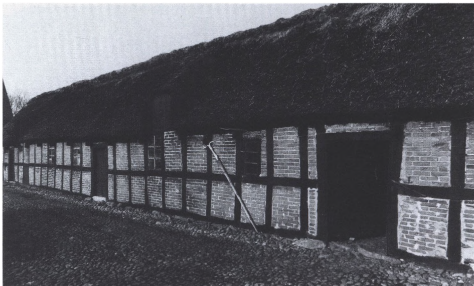
Dette er en gammel staldlænge fra Lem i Ommersyssel. Den er intet højremshus, men er vist her, fordi man på billedet tydeligt ser de gennemstukne bjælkehoveder og på gennemstikningerne længst til højre også fornaglingerne, – to tværgående pløkke eller nagler, der fastlåser konstruktionen.
