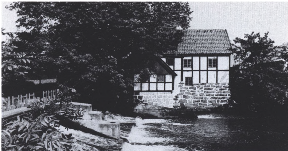
Sæbys vandmølle fra 1710 med bindingsværket hvilende på en vældig kampestenssokkel.
