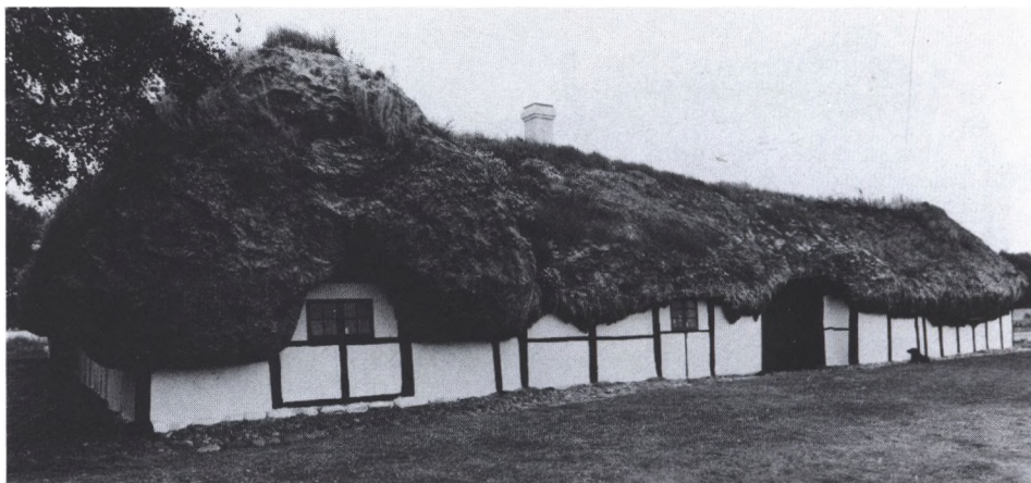
Museumsgården i Byrum på Læsø har endnu tangtaget i behold, og som det kan ses, hænger taget noget uregelmæssigt ned på væggene. I gavlen er der hugget ud til vinduet.
