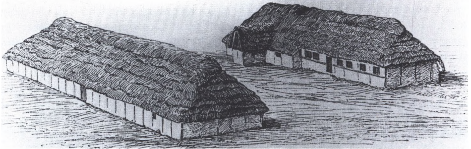
Parallelgård fra Thy, hvor der i det hus, der bl.a. rummer beboelsen, er udskud i vestenden samt brøndstue i en lille korsbygning. Bindingsværket er meget spartansk, og røgen fra ildstedet er sluppet ud gennem byrehullet i taget. Sådanne gårde ses desværre ikke mere. – Efter tegning af Karl Jensen.
