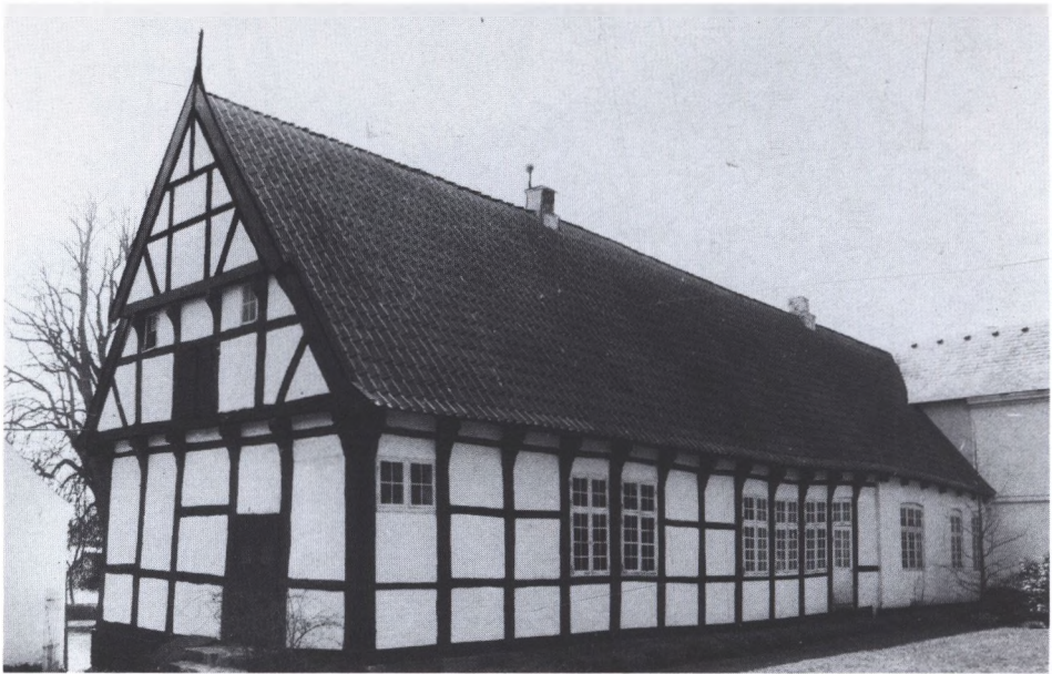
I gavlen og på den ene langside er Randrup stadig et hus fra midten af 1500-årene med knægte og udkragende gavltrekant.
