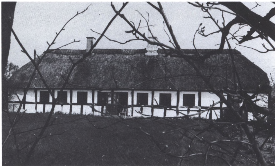
Hus i Helberskov i Himmerland, hvor man meget tydeligt ser tørvemønningen, der hér er af lange enkelt-tørv. Mønningen nord for Limfjorden var ganske mægtige til denne.
