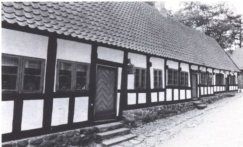
Denne prægtige række af sammenbyggede håndværkerboder stammer fra Rosengade i Randers, hvor de opførtes i det herrens år 1741. Som så meget andet gammelt Randers-bindingsværk måtte de vige for nye byggerier, og omkring 1930 flyttedes de til Den gamle By i Aarhus. Det viste sig, at praktisk talt intet var ændret ved dem siden opførelsen. Boderne – også kaldet renteboder – er et glimrende eksempel på, hvordan man i en by kunne følge et stærkt skrånende terræn.
