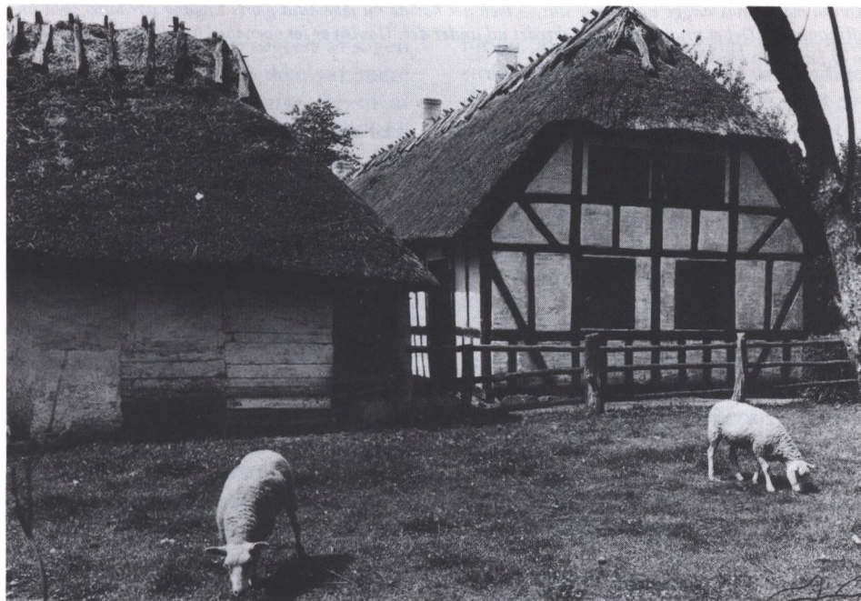
Bulhuse har man ikke haft på Fyn i nyere tid, men nok undertiden en stump bræddeklædt væg. Den fynske Landsby.
