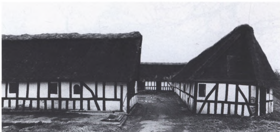
Ned langs denne gamle længe til gård i Brenderup, ser man de gennemstukne bjælkehoveder, som viser hvor sulerne står.
