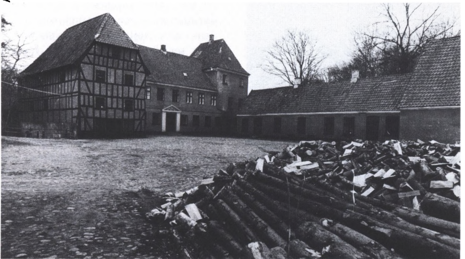
Ranker, halvranker, løsholter og en gudsvelsignelse af dokker gør Skovmøllen ved Paddesø fra forrige århundrede til et pragtfuldt bygningsværk. Bindingsværksdelen står i rødt med sort tømmer. Stolperne går op gennem flere stovværk og er såkaldte højstolper.
