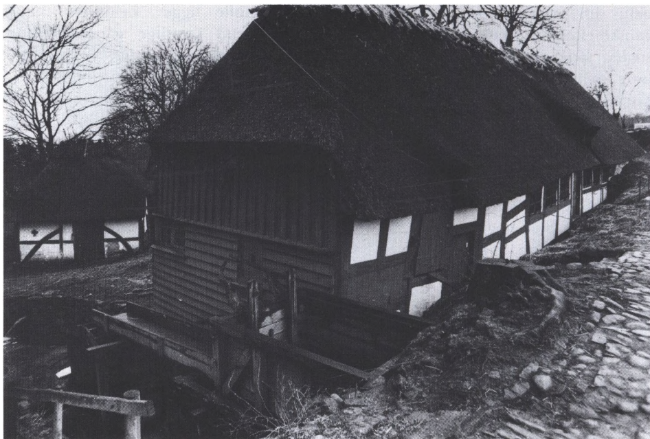
Kaleko mølle, hvis vægge lidt skæve står, – men det har de nu ikke altid gjort. Engang var huset med fine afstrøninger. Det er grunden, som er skredet ud under det. Gavlen er for oven med bræddebeklædning eet på to og for neden klinkbygget.
