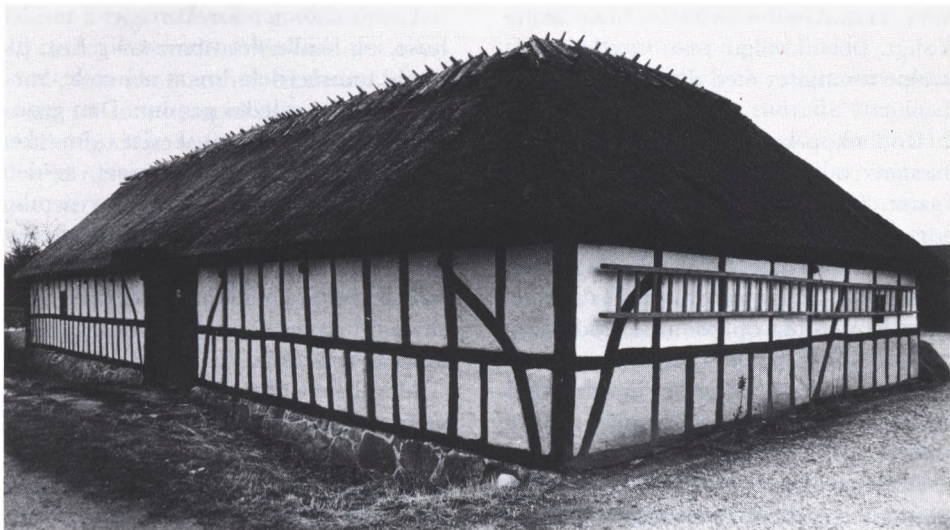
På denne gård i Gamby på Nordfyn har man hovedsageligt holdt sig til okrede tavl og sort afstolpet tømmer, men gavlen har for oven hvide tavl.
