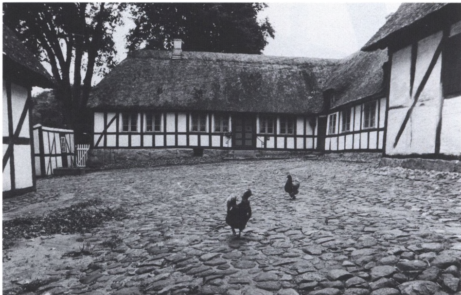
Bankegården i Aasum ligger i et skrånende terræn og har sokkel af marksten af varierende højde. Over soklen – eller sylden – ligger en kraftig, solid fodrem. Bemærk den fint brolagte gårdsplads.
