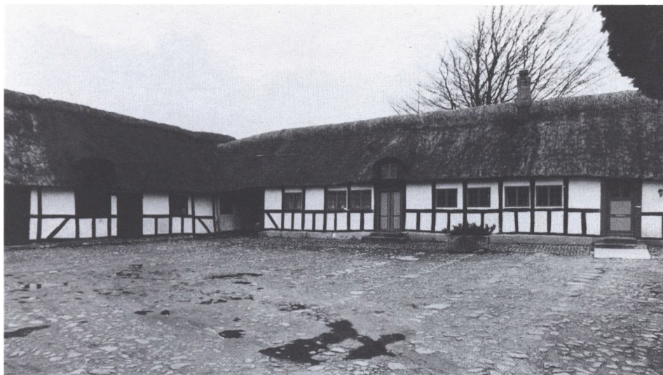
Hjørne med tofteport i kringbygget gård ved Langsted.
