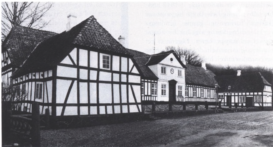
Flenstøfte ved Assens har trefløjet hovedbygning af bindingsværk fra 1748 og grundmuret midterparti fra ca. 1790. Bindingsværket er med gennemstukne bjælkehoveder og står med rødt afstolpet lømmer.
