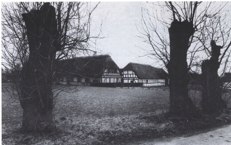
Gammel gård i Brenderup med tætsiddende dokker i stuehusets nedre tavl og dokkefriser.
