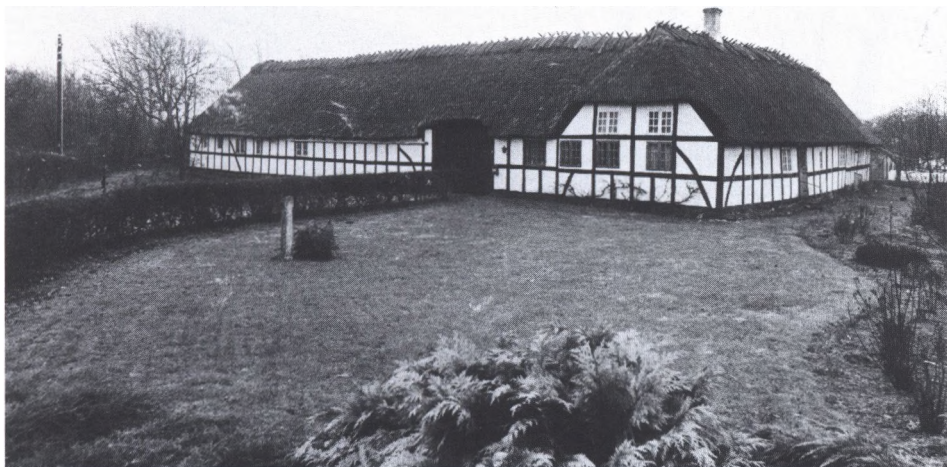
På Fyn er det almindeligt, at de lange ranker støtter mod den anden stolpe i stedet for mod hjørnestolpen. – Gammel gård ved Svanninge.
