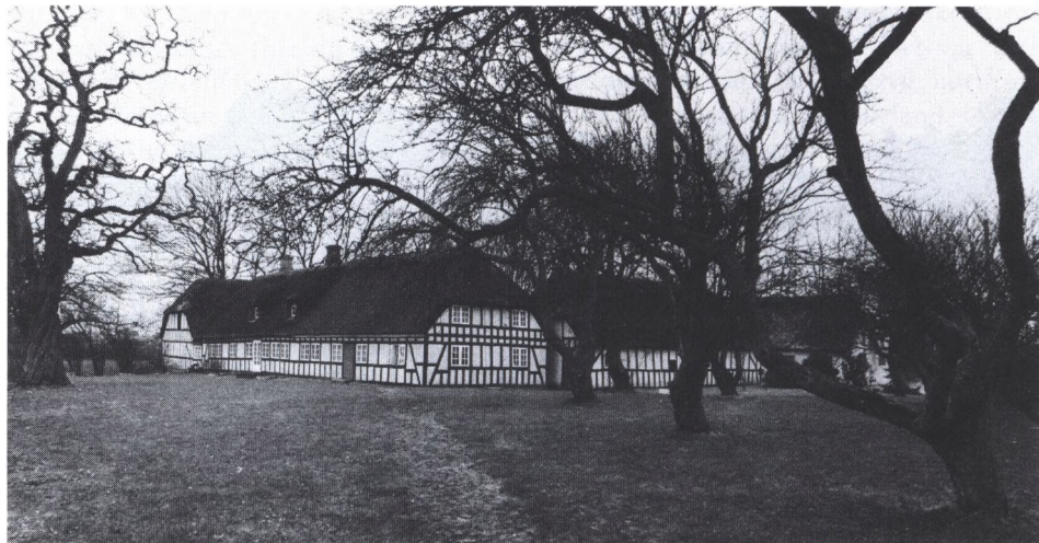
Gammel bindingsværksgård i Brenderup. Det er fynsk bindingsværk, når det er rigest, med en mængde pynte-, eller fyldtømmer mellem leddene af mere vital betydning. Gården er med sulekonstruktioner, hvilket fremgår af de enkelte gennemstukne bjælker.
