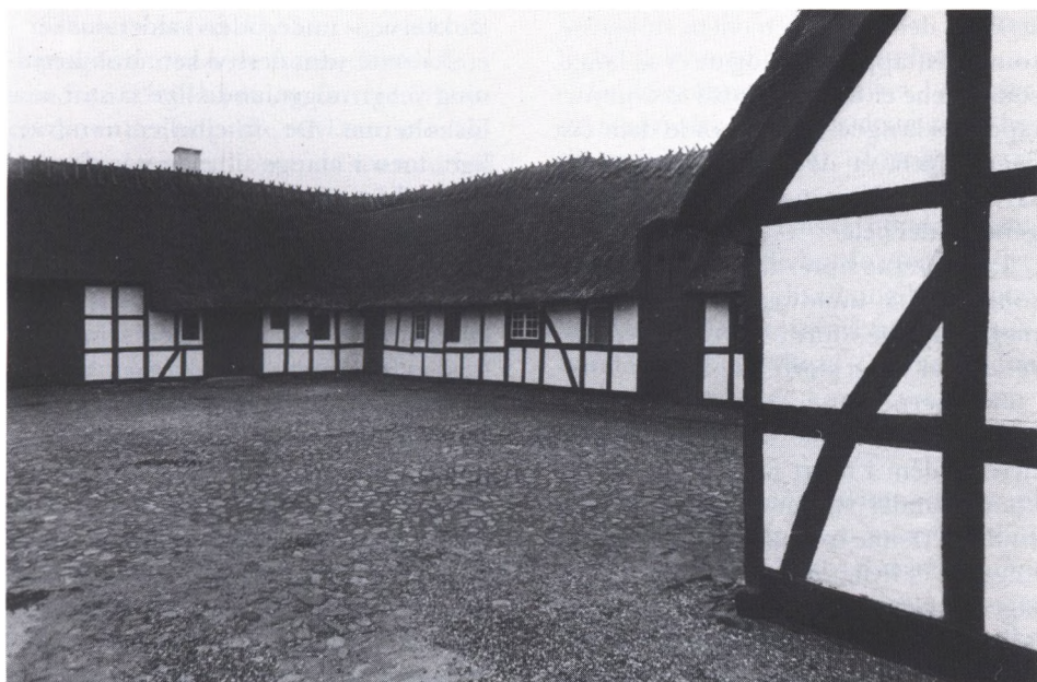
Skovkildegård ved Svanninge har i ladeafdelingen tre tavl dannet af to hold løsholter.
