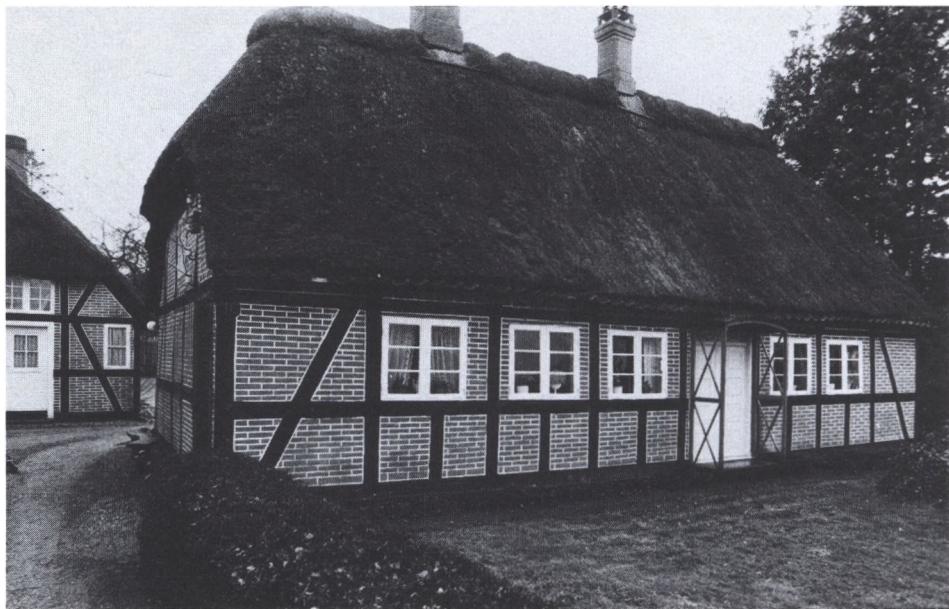
Dette skovfogedhus under Hagenskov på Vestfyn har pudsede bindingsværksvægge malede som var det brændte teglsten lagt i forbandt, – og det er det såmænd også neden under pudsen, men måske knapt så ensartet som det malede kan opvise.
