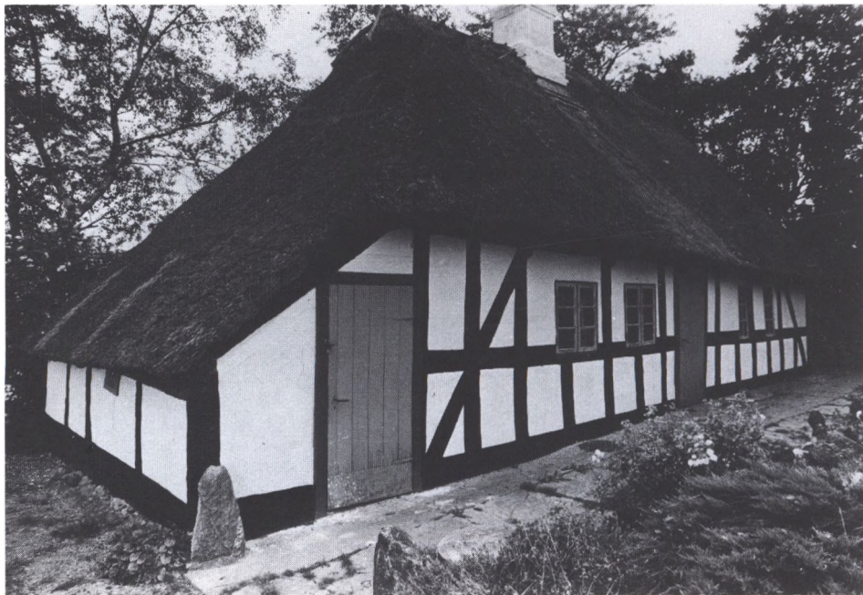
Hus med udskud og »kabusetag« ved Morud.
