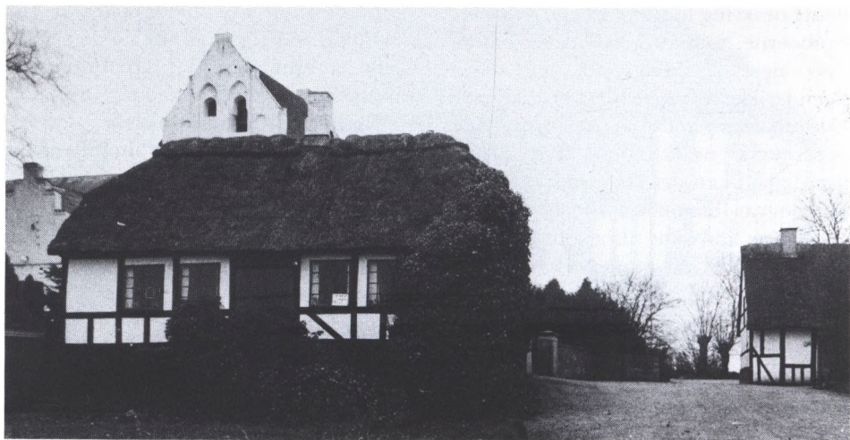
Småhuse som dette ved Kirke Søby kirke fik tidligt brændte teglsten i bindingsværkstavlene.
