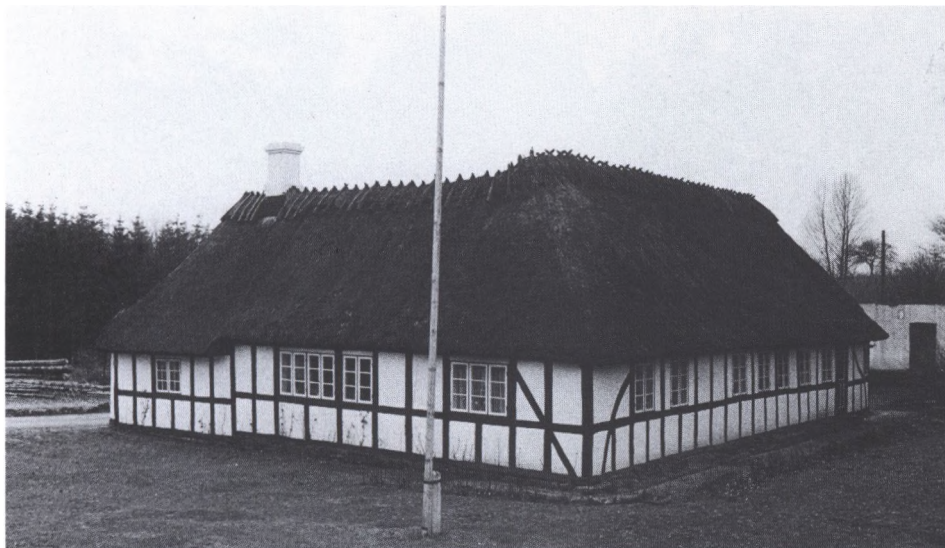
Helvalm var det mest bekvemme, når man byggede helt rundt. Gård ved Ringe.
