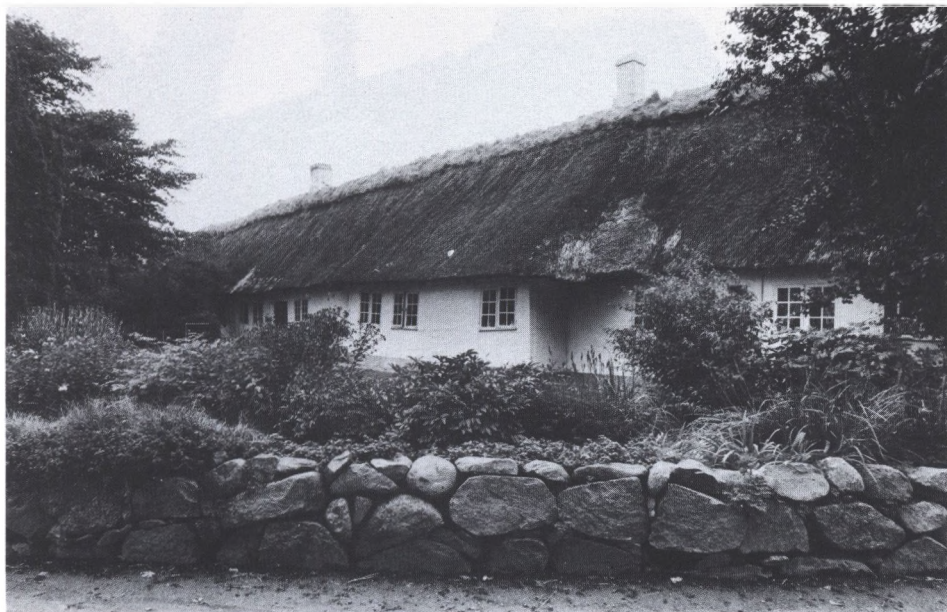
Helt overhvidtede huse forekommer ikke sjældent på Fyn, det kan være avslængerne, der er hvidtede, medens hovedhuset har afstolpet tømmer, men stuehuset kan også – som hér i Viby på Hindsholm – være overkalket.
