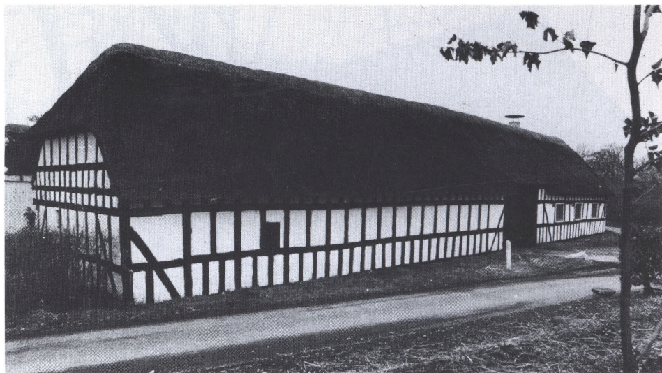
På denne gamle sulegård i Åhøjrup er der løsholter både over og under vindueshøjde, og der er dokkefrise for oven mellem øverste løsholt og tagremmen samt en dobbelt frise i gavlen. I fagenes midtertavl er der én dokke, i nedertavlene to.
