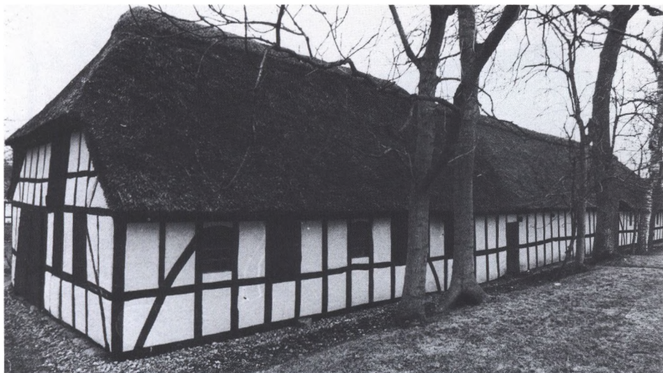
Ranken, som støtter mod anden stolpe, fordeler vindens tryk ned gennem hele huset, så alle stolper må være med til at afbøde det. Gård i Morud.
