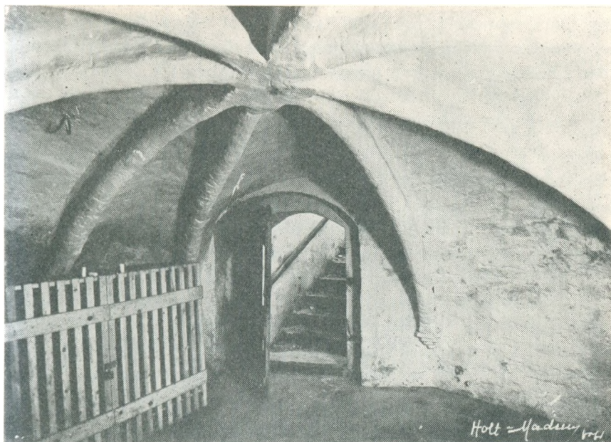
Kælder med middelalderlige hvælvinger under Brundlunds nord-vestre tårn.
