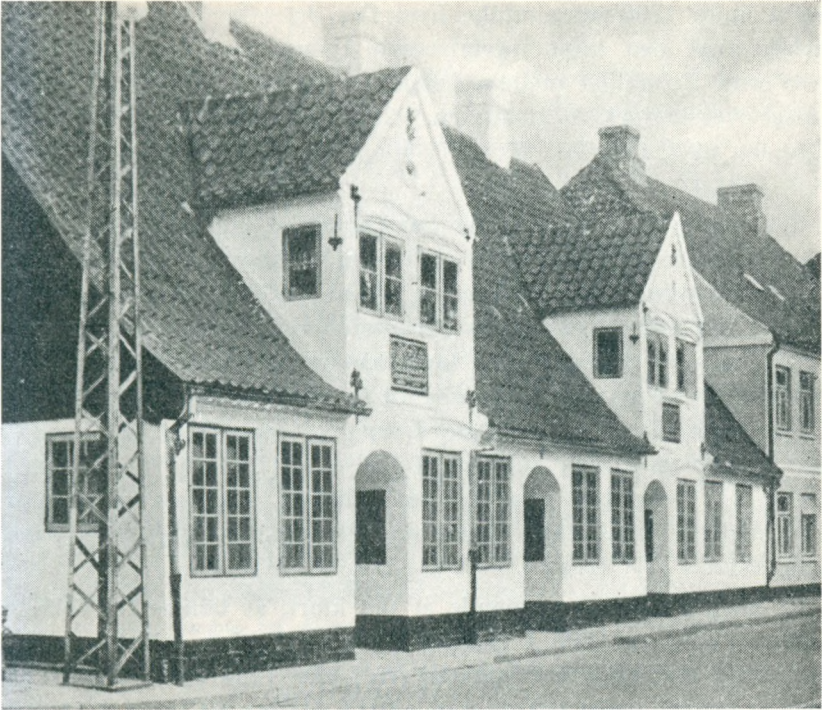
Schwennezens stiftelse i Sønderport 1 er bygget 1772. Det er et langhus med tre indgange og to gavlkviste, der bryder det høje tag.
