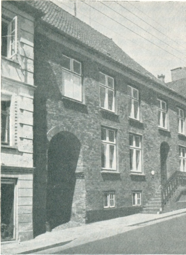
Storegade 24 er et empirehus fra Frederik 6.s tid.
