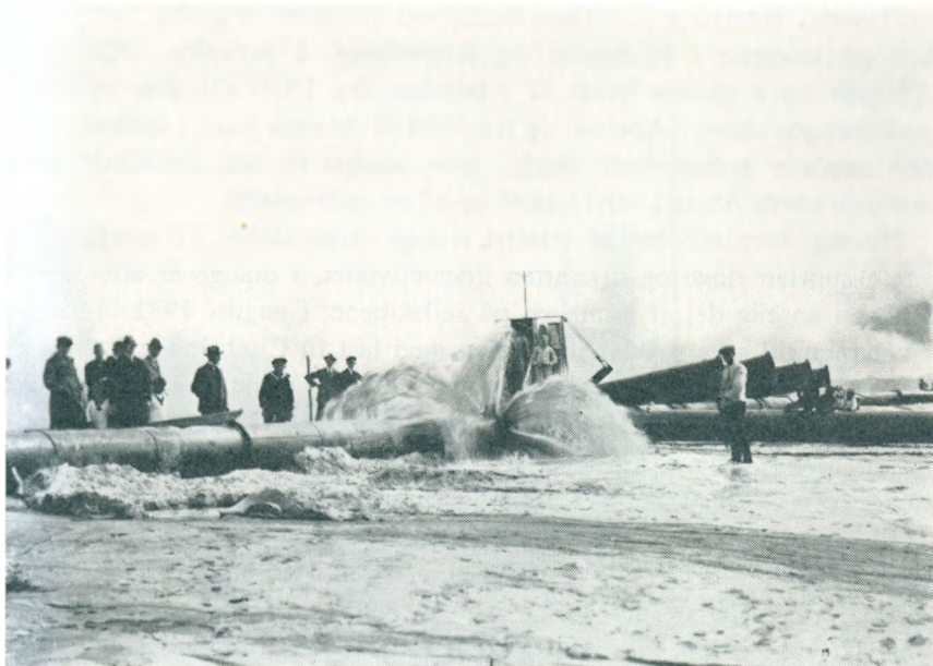
Ved anlægget af Nyhavn 1922–23 brugtes store sandpumpere til opfyldning af i alt ca. 15 ha nyt havneareal, hvor bl. a. Højspændingsværket kunne placeres.
