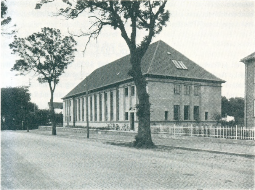
Landsarkivet er opført 1932–33 på Nørre Chaussé i Åbenrå efter tegninger af kgl. bygningsinspektør K. Lehn-Petersen. Landsarkivar Frode Gribsvad var dets første leder.
