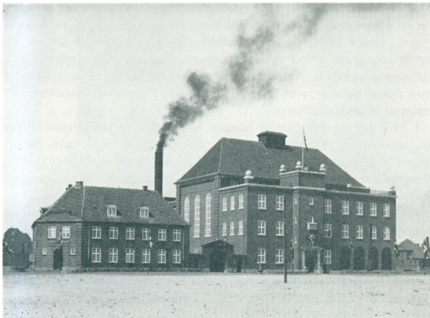
Sønderjyllands Højspændingsværk er bygget 1923–24 på et opfyldt areal i Åbenrå havn. Dets arkitekt var Jep Fink, og dets første direktør var Jes Christiansen.
