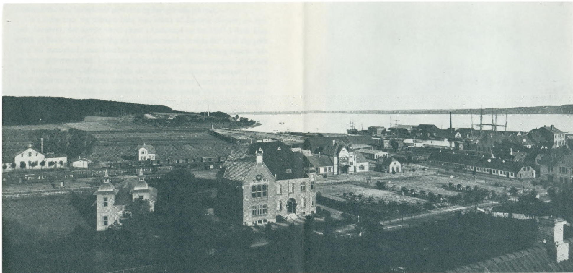
Udsigt fra kirketårnet over markedsplads, kredsbanegård, havn og Lindsnakke, hvor teglværksskorstenen endnu ses. Foran t.v. det med tårne og spir prydede gymnastikhus.
