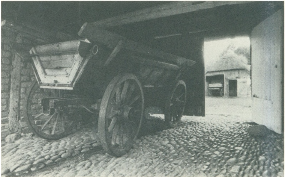
I vognporte og på gårdspladser var det ønskeligt med en god brolægning, så der ikke kom dybe vognspor, der vanskeliggjorde manøvreringen. Den vestjydske gård, Hjerl Hede.
