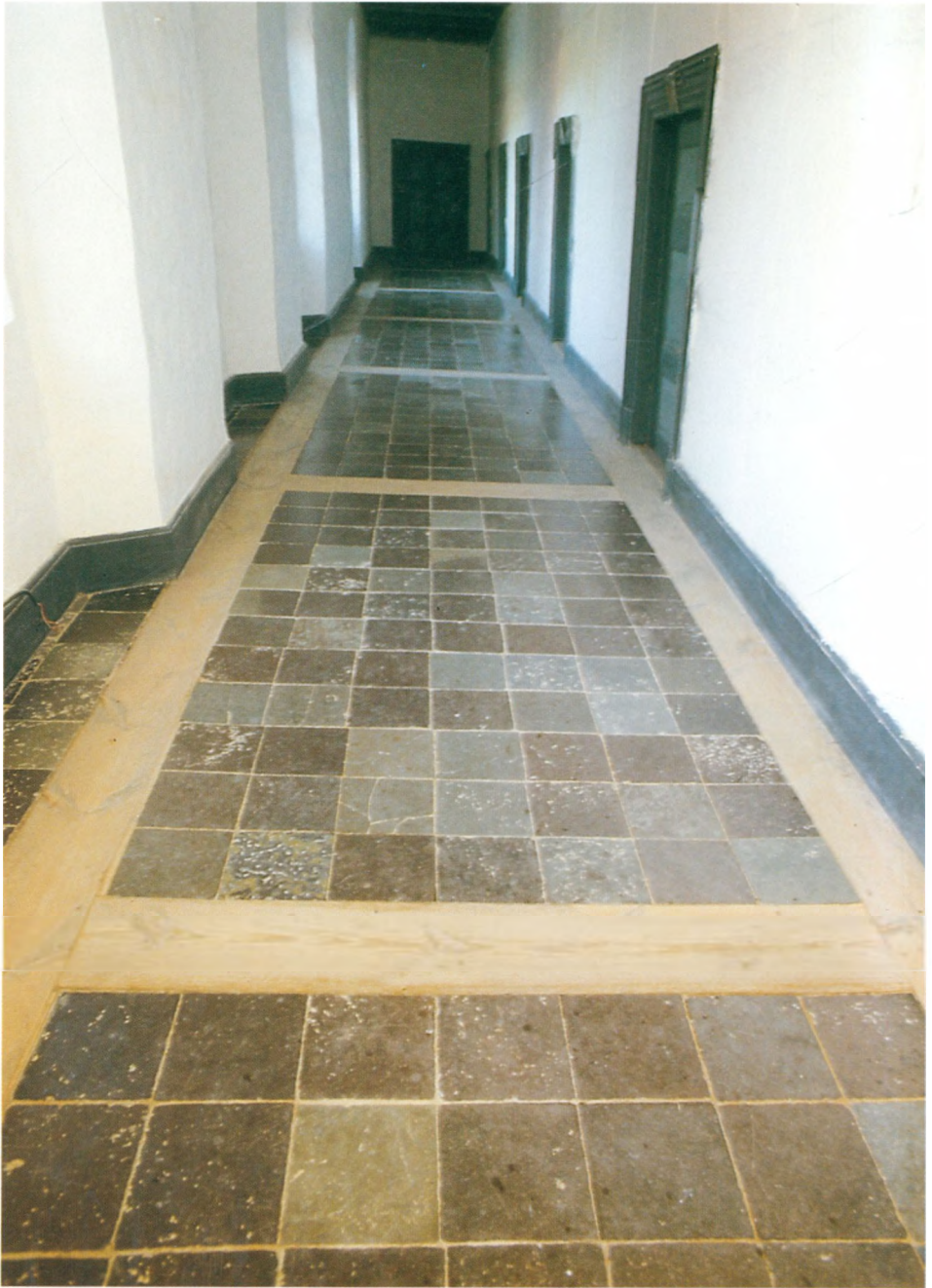
Stengangen med ölandsfliser i frisebrætter. Trudsholm.
