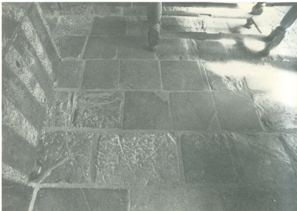
Gammelt gulv af ölandsfliser i Borgmestergården i Den gamle By. Man ser, hvordan nogle af fliserne er dekomponerede på overfladen, meget muligt på grund af ætsning. Den spidse skygge i en af fliserne er spor efter en ortoceratit.
