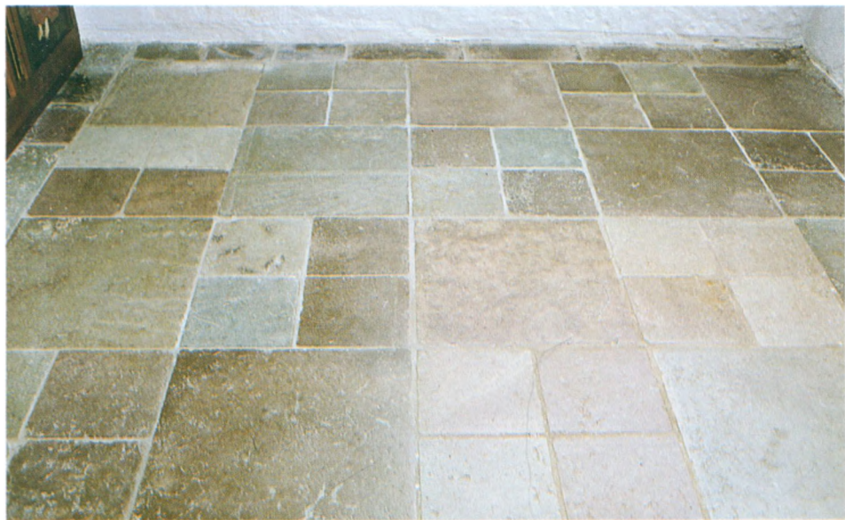
Ølandsflisegulv i koret i Aalsø kirke på Djursland. Det er lagt sådan, at fliserne i nogle af felterne danner korsformer.
