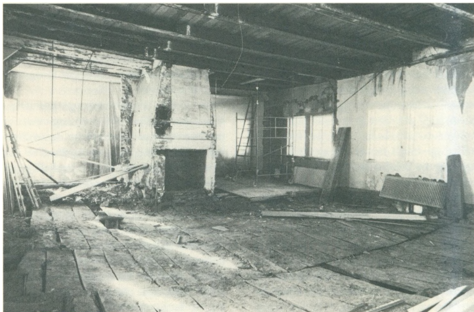
Under talrige senere opfyldningslag lå det oprindelige gamle egetræsgulv på Oregaard, det dannede bund for et lergulv.
