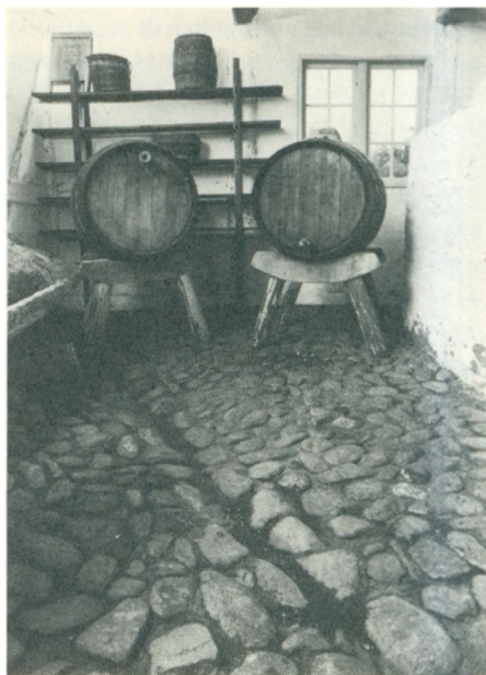
På steder i huset, hvor der kom megen fugt til, f.eks. i bryggerset, var det udmærket med en stenpikning, som måske endda kunne have en afløbsrende. Præstegården fra Nr. Aarslev ved Randers. Hjerl Hede.
