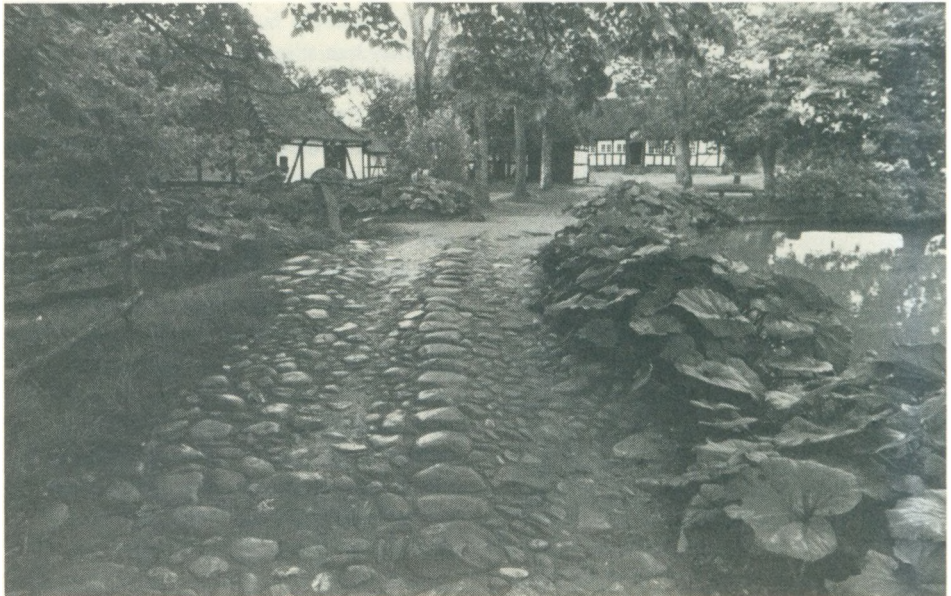
På mange gamle brolagte veje er der i midten en række lidt større sten, som man kan træde på. Hjerl Hede.
