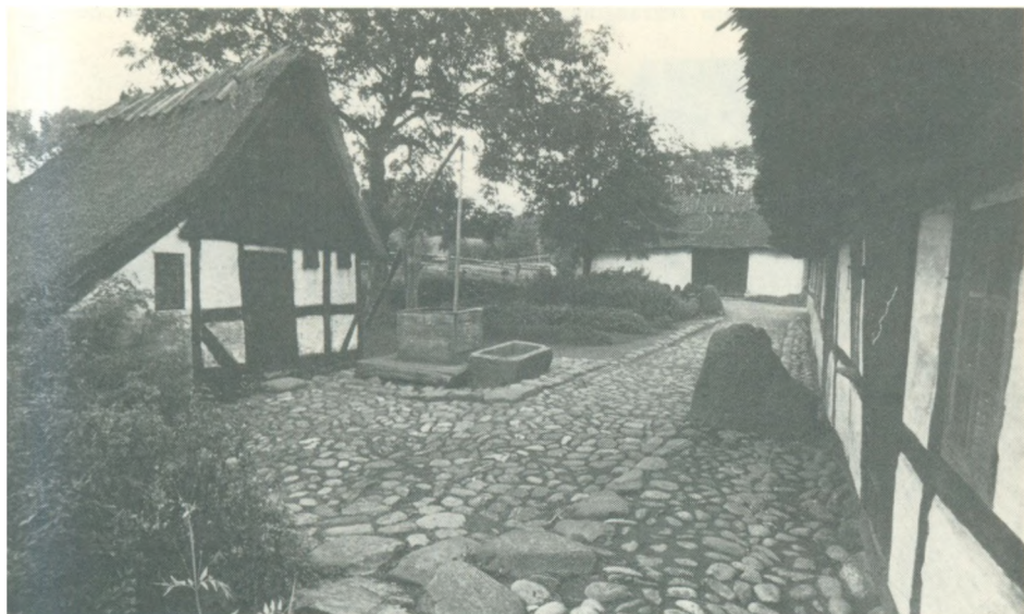
Brolagt gade foran gård i Den fynske Landsby. Gården stammer fra Ærø. Brolægningen er meget omhyggeligt udført med kantning mellem »fortå« og vejbane af nogenlunde jævnstore sten. Den meget store højkantstillede sten er en dørstopper, og uvivlsomt landets største sådanne. Under brøndens vandingstrug er der også brolægning.
