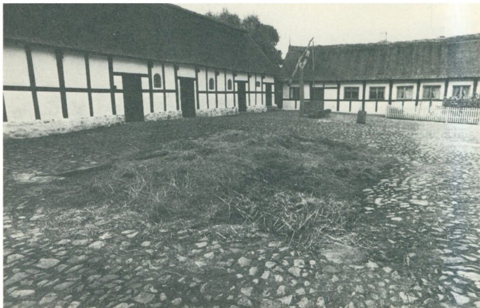
Den bornholmske gård på Frilandsmuseet i Sorgenfri har en stor, vel brolagt gårdsplads, hvor der tildels er anvendt flækkede sten eller kløvninger.
