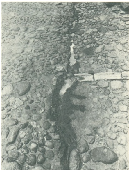
Som afløb fra husene for tagdryp etc., brugte man ofte render udhugget i ølandssten. I dag er disse huggede afløbsrender store sjældenheder, men kunne så de ud i den knubrede brolægning. Gårdspladsen på Koldinghus har ligget uændret siden Chr. III's dage.
