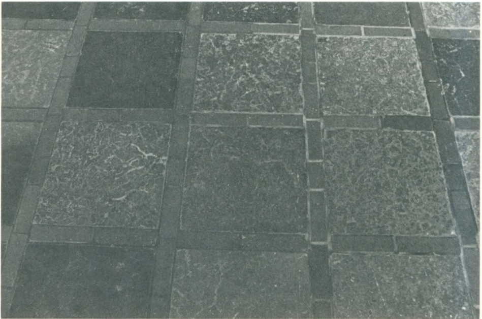
Ölandsfliser lagt med kantninger af kantstillede teglsten. Sct. Knuds kirke i Odense.
