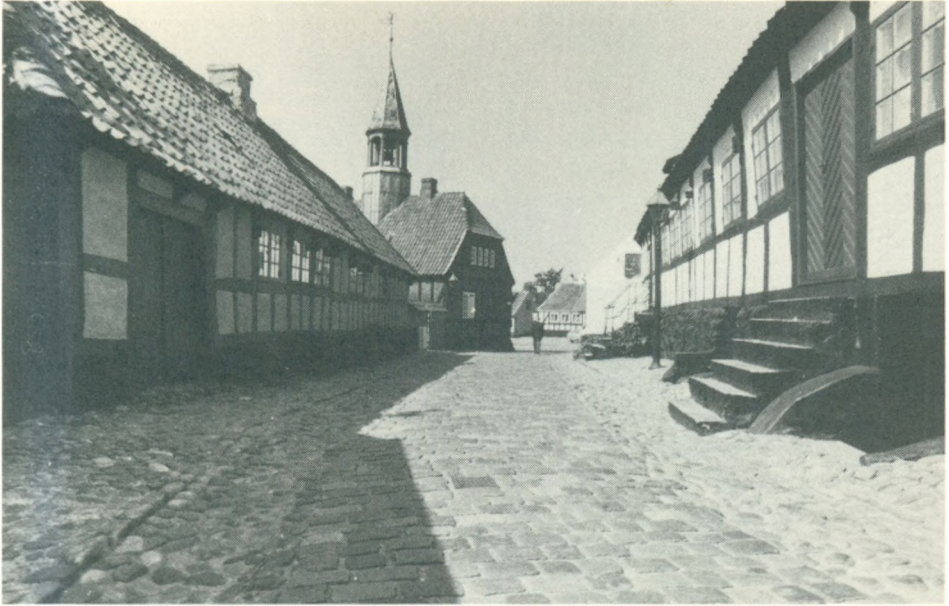
Brolægning i den gammeldags manér med knubrede brosten ved siderne og kørebane af tilhuggede sten på midten, kan ses i Ebeltoft.
