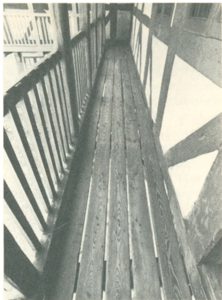
Men det kan også være rart med åbninger mellem gulvplanker, som f.eks. på en svalegang, hvor fygesne ellers ville blive liggende på gulvet. Borgmestergården. Den gamle By.
