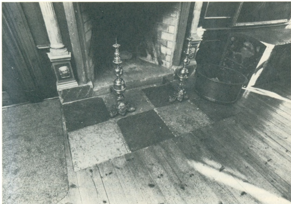
Ölandsfliser lagt i niveau med gulvet foran kamin. Rosenholm.
