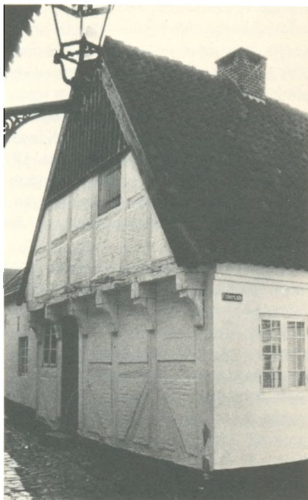
Dette renaissancehus i et stokværk i Ribe vender den pæneste side – gavlen – ud mod den vigtigste gade. Der er bl.a. prydet med mønstermuringer i tavlene.
