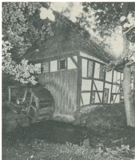
Vibæk vandmølle på Als med bræddeklædning ved møllehjulet.
