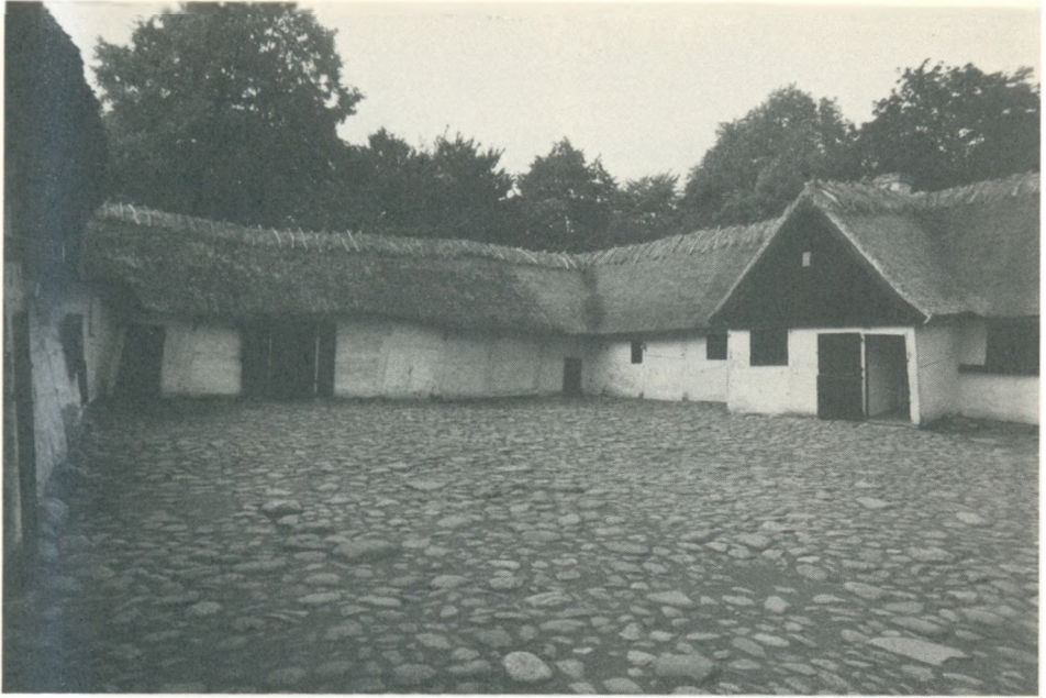
Strå- og rørtage har den fordel, at de er bløde og derfor let følger de skævheder, som kan være i et gammelt hus, f.eks. i Pebringegården på Frilandsmuseet i Sorgenfri.
