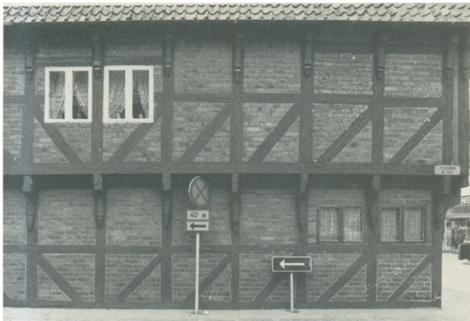
Hovedhuset i Pilgrändsgården er med knægte i begge stokværk. De større vinduer er ikke originale og skærer ind i tømmeret.
