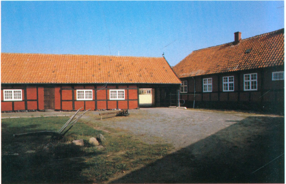
Vendelbogård hedder dette smukke anlæg i Hasle. – Bindingsværk med sorttjæret tommer og røde tavl.
