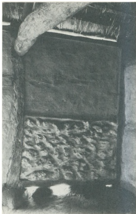
Mangt og meget kunne sættes i bindingsværkshusenes tavl. Her er det ren lerklining for oven og indklinede marksten for neden. Frilandsmuseet i Sorgenfri.
