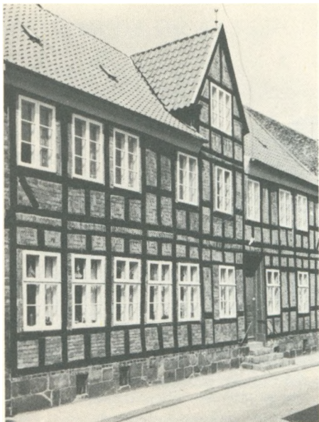
I Sct. Mogensgade i Viborg ligger dette noble hus fra ca. 1730. Det er gedigent byggeri med kampestenssokkel og svært tømmer. Den enkle, hvidtede gesims er nærmest at opfatte som en sugfjæl.
