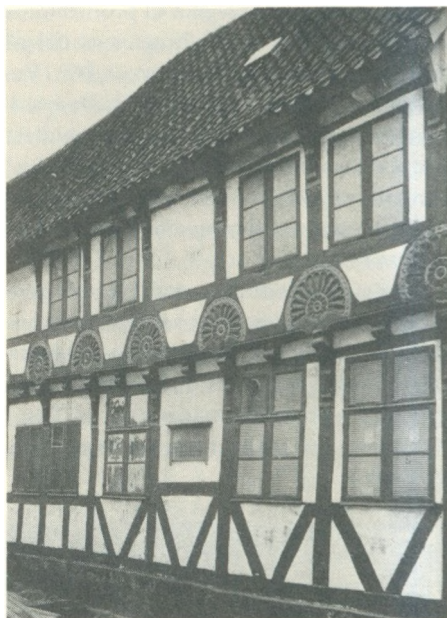
Påskestræde-huset i Odense fra 1570 med meget smukt skårne rosetter, lange knægte og lille bladfrise på stolperne.
