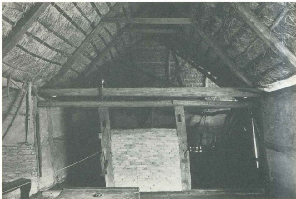
Spærtæg med hanebånd. Frilandsmuseet i Sorgenfri.
