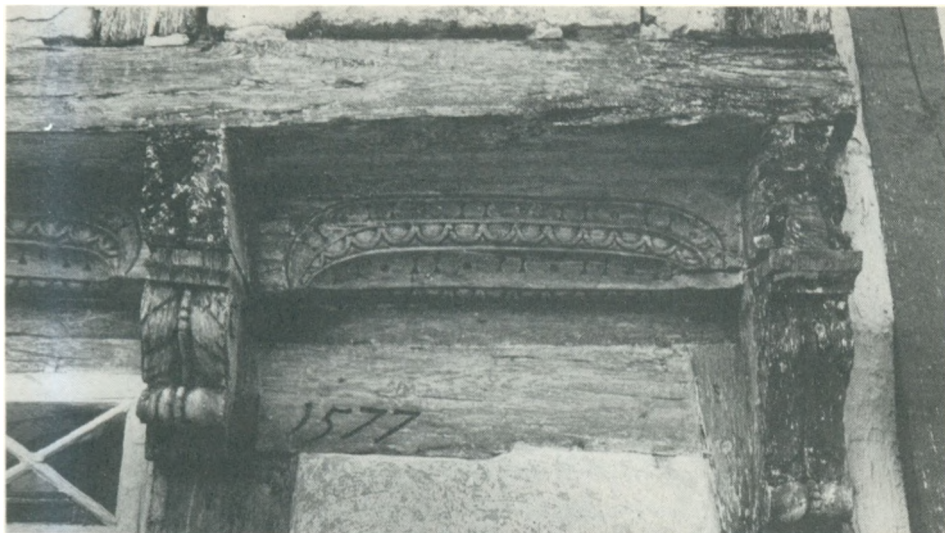
Fyldholt med rige skæringer mellem knægte med akantusblade. Detalje fra Helsingørs ældste bindingsværkshus fra 1577. Strandgade.
