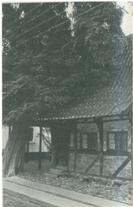
Store Kirkestræde-huset fra 1526 i Køge, halvdel af en bod – et lille udlejningshus – fra gotisk tid. Knægtene er meget lange og har enkle profiler.
