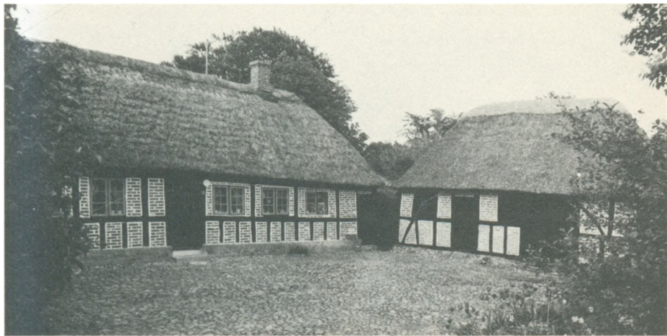
Et fornemt stykke arbejde: Ejeren af dette hus i Feldballe på Djursland holder stadig fugerne optrukne med hvidt. – Det ser pragtfuldt ud, men det er et forfærdeligt slid at holde det vedlige.
