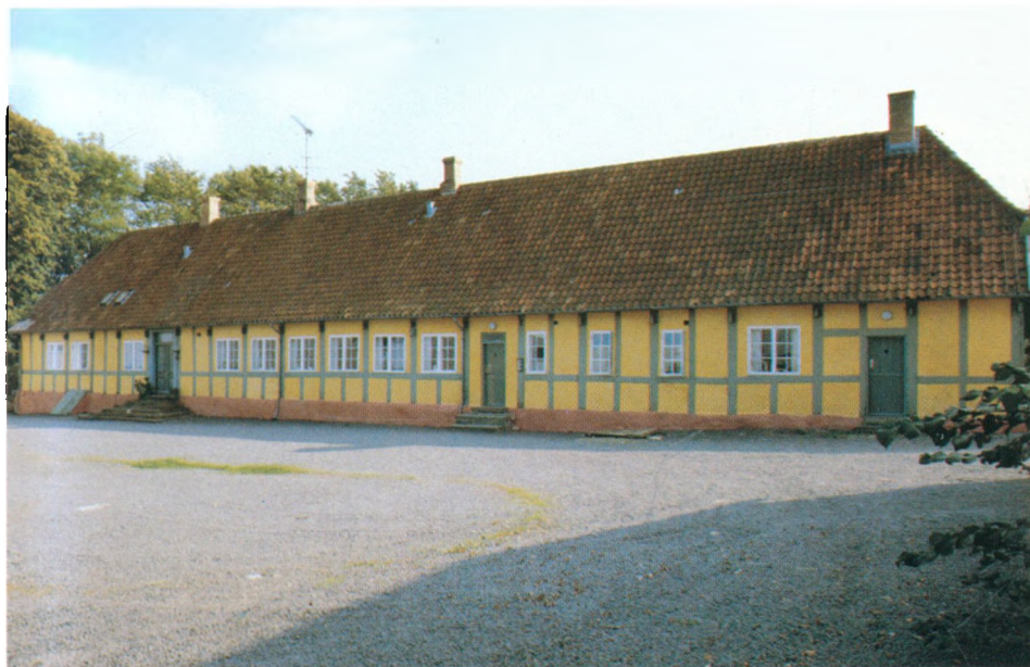
Maglegaard ved Svaneke er en statelig bindingsværksbygning med tegltag.
