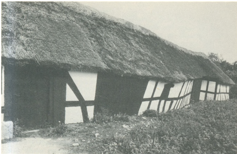
Den bjælke, der støtter en sule, er stukket gennem stolpen og fornaglet. Det kunne synes, som om den udøver et vist pres på væggen. Gammel gård i Skårup på Vestfyn.
