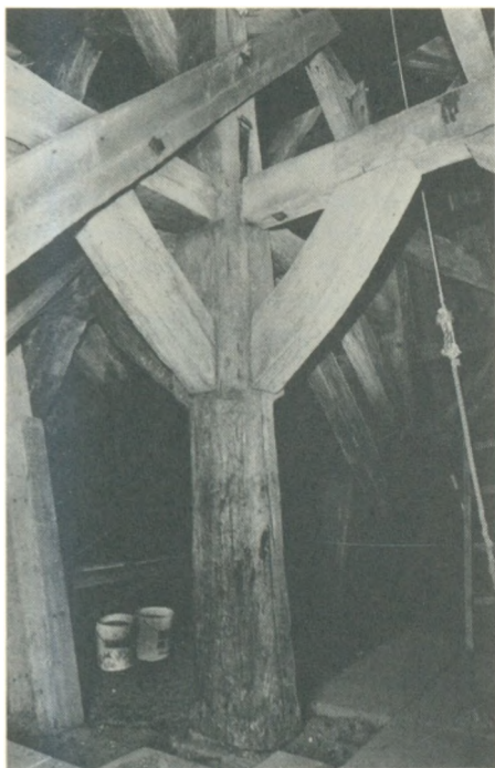
Det indre af Tandslet klokkehus med det svære tømmer og den vældige stolpe, kongen, i midten.
