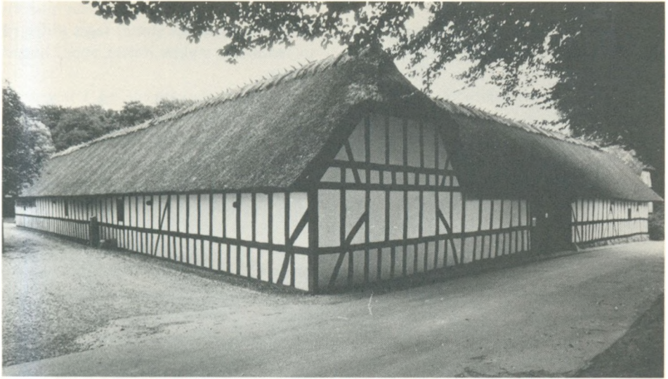
Landmålergården i Gummerup er en sulegård. De gennemstukne bjælker viser, hvor i huset vi kan finde sulerne.
