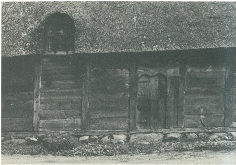
Dør i Tyrstrup-laden. Som det fremgår, er dørhammeren forlænget, så den også tjener som løsholt. Den ene stolpe tjener også som dørstolpe, den anden dørstolpe er faktisk, hvad man vil kalde en dokke. For neden har dørhammeren en flot æselrygbue. Fodtømmeret – fodremmen – hviler på en syld afløst sammenpakkede marksten.
