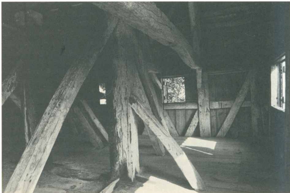
Klokkeloftet med det svære tømmer i Østerlars kirke. Væggene er faktisk bindingsværk, som i stedet for udfyldning af tavlene har fået sat en bræddebeklædning uden på tømmeret.
