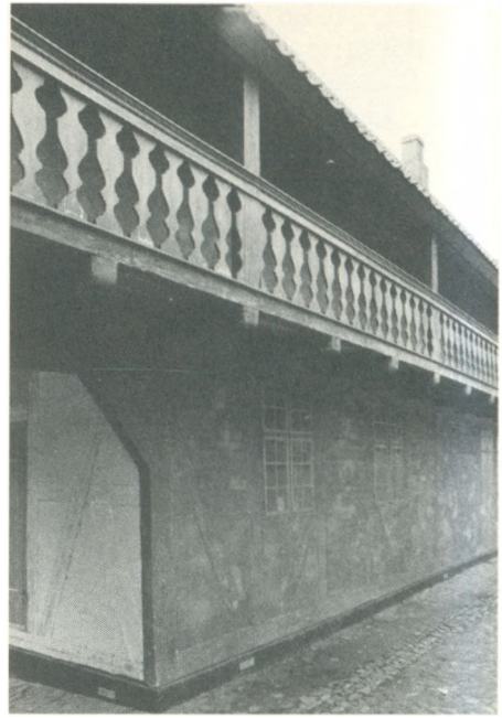
Svalegangen på Bendtzens gård i Den gamle By er en langstrakt konstruktion med smukt udsavede balustre. Her har man forladt sig alene på de forlængede bjælkers bæreevne. Der er ingen kopbånd under.
