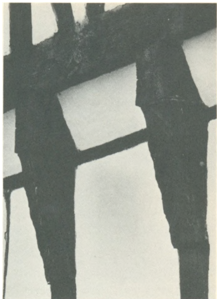
Den karakteristiske Ribe-knægt er en trekantsknægt med sparrer.
