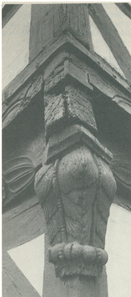
Ejendommen Stengade 20 i Helsingør har en elegant konstrueret hjørneknægt prydet med akantusblade med perlestav i midten.
