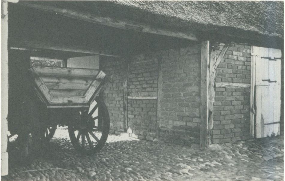
Det spinkle og ofte skrøbelige bindingsværk i de vestjydske gårde kunne meget vel være lavet af strandingsstømmer. Her er det udfyldt med murværk med dybe fuger. Hjerl Hede.
