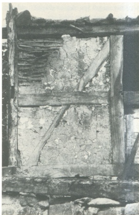
Vendreværk i bindingsværk. Man ser risflejtningen, som leret er klinet fast på.
