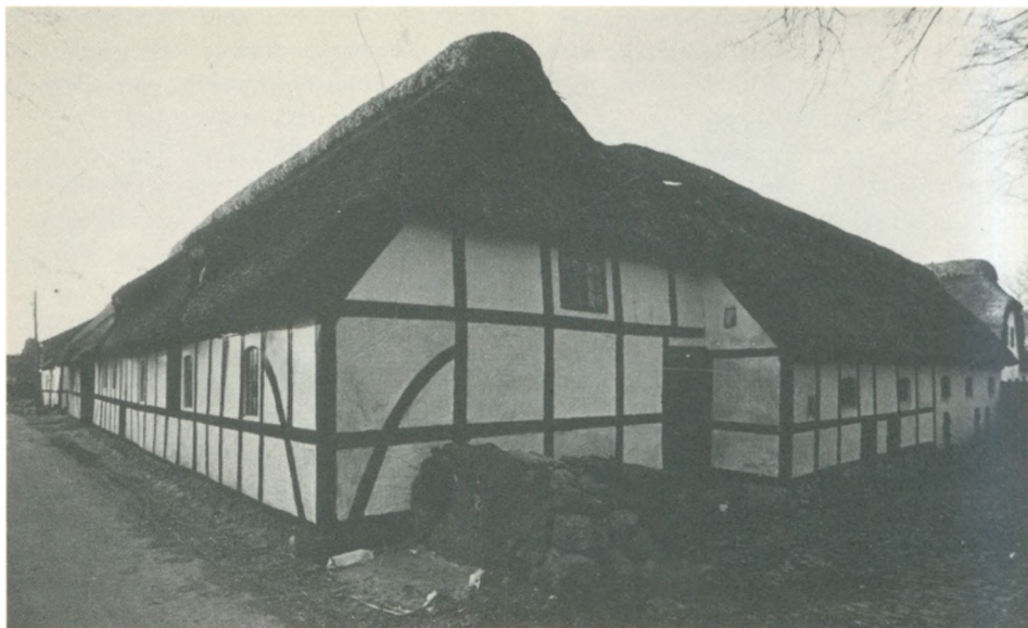
På Lyø har mange gamle gårde haft rygning med tang i stedet som nu strå. Det har også været tilfældet på denne prægtige, velbevarede gård i Lyø by.
