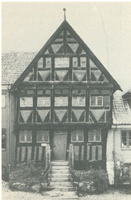
Henner Frisers pyntelige gavlhus fra 1575 i Middelfart. Her er der ikke skåret rosetter i trekantstømmeret ved stolperne.
