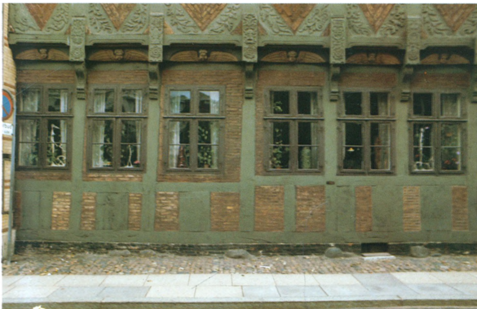
Fra apoteker Reimincks gård i Kolding. – Et afvore mest ødsle renæssancehuse i bindingsværk.
