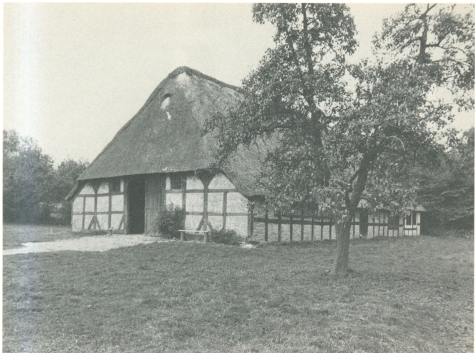
Brede og flotte ser højremshusene ofte ud, som Frilandsmuseets gård fra Ostenfeld i Sydslesvig. I sideskibene har der bl.a. været båse til dyrene, opholdsniche til mennesker osv. Sorgenfri.
