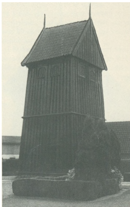
Klokkehuset i Søllested på Lolland. Det har seldeltag og vandnæseprofil.
