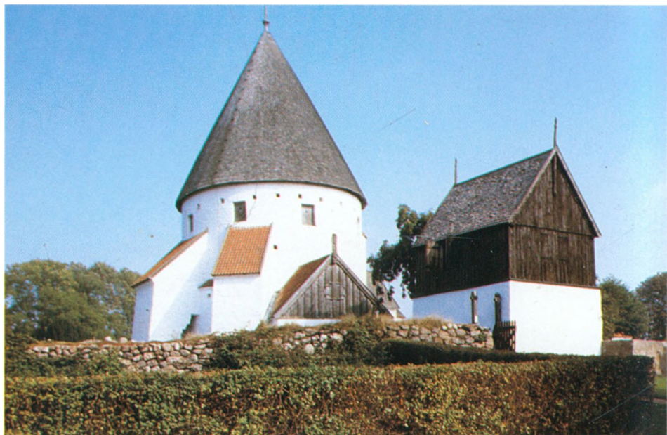
Olsker kirke med klokkehuset, der har bræddeklædt klokkeløft. – I middelalderen var den tillige en stærk fæstning.
