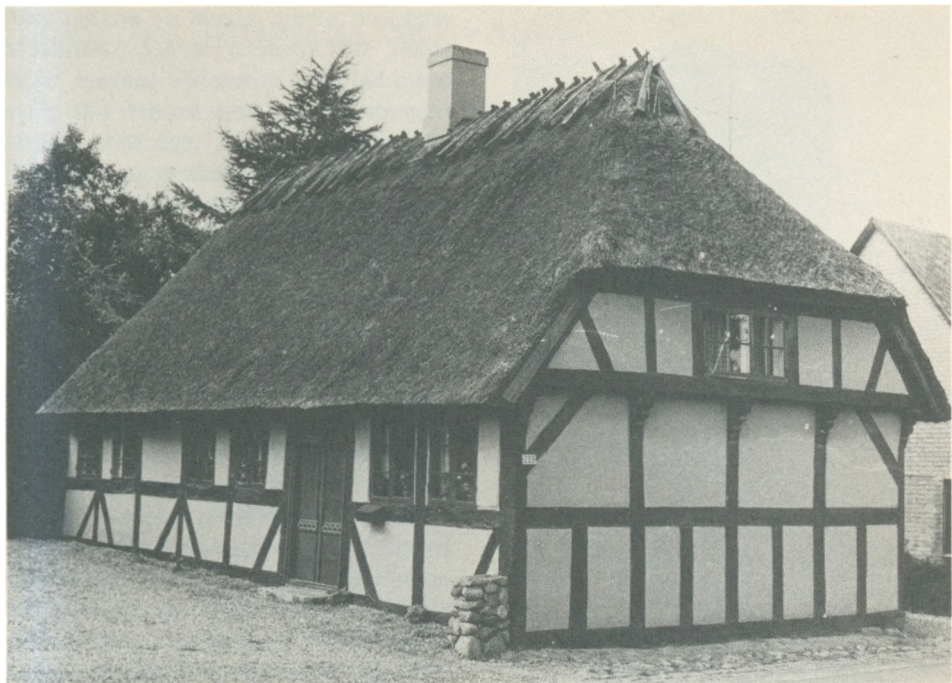
Bondehus med knægtbygget gavli i Stenstrup på Fyn.
