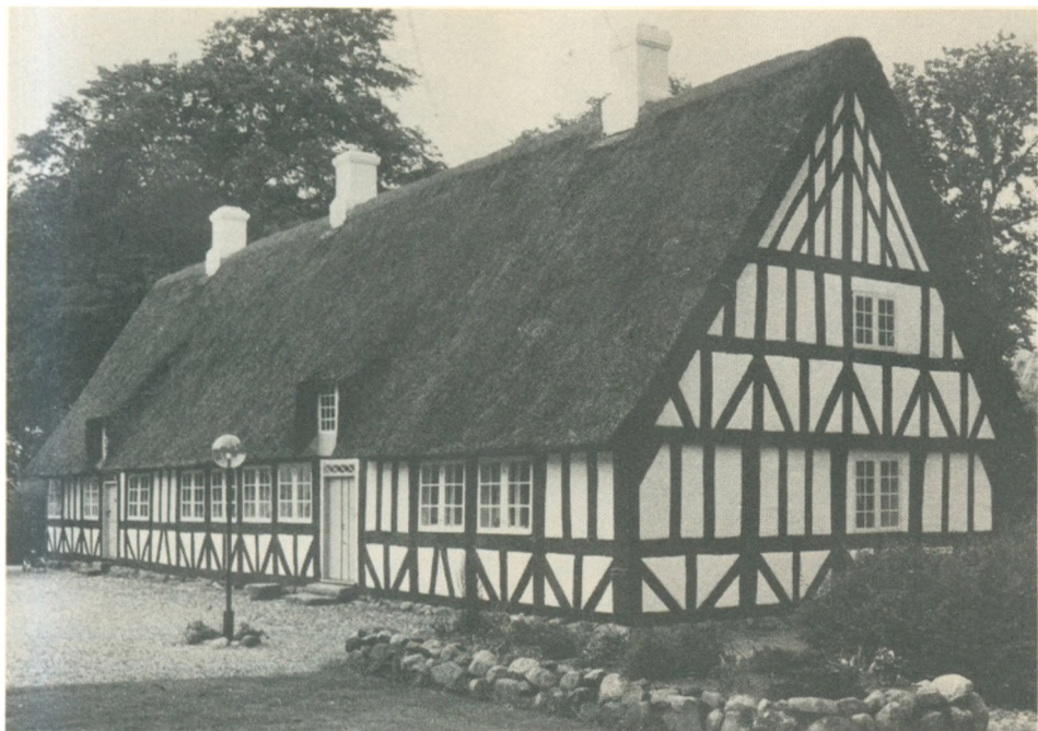
Hjarup præstegård. Et meget tømmerrigt renaissancehus med flotte konstruktioner og svære hjørnestolper.
