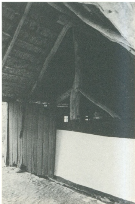
Sulekonstruktion i gammel gård i Skårup på Vestfyn.
