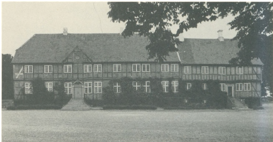
Lyngbygaard med de to huse lagt i forlængelse af hinanden. Den vestre ende med frontispice hviler på renæssancekældre.
