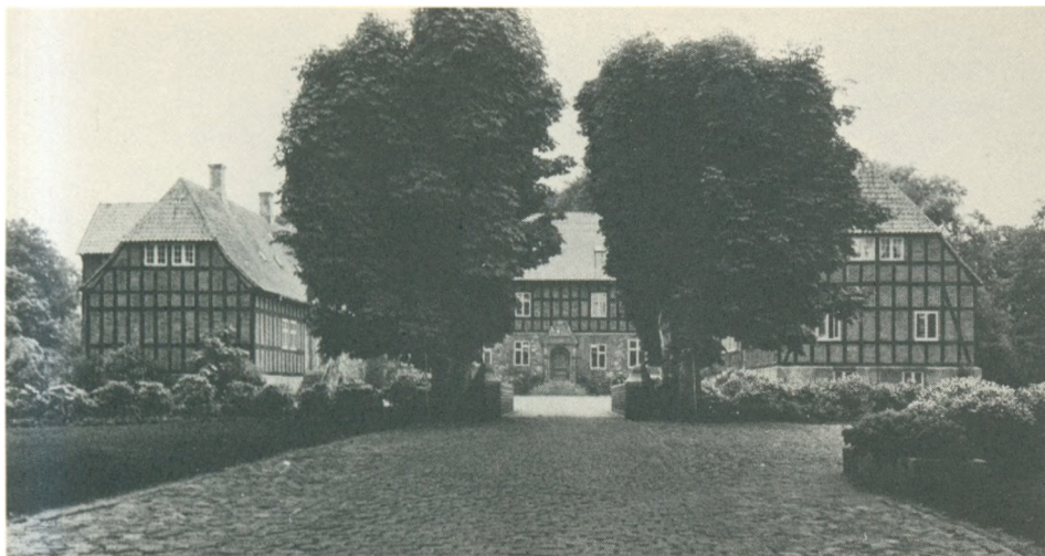
Steensgaard på Sydfyn har antagelig bindingsværk i sig fra det tidlige 1500-tal.
