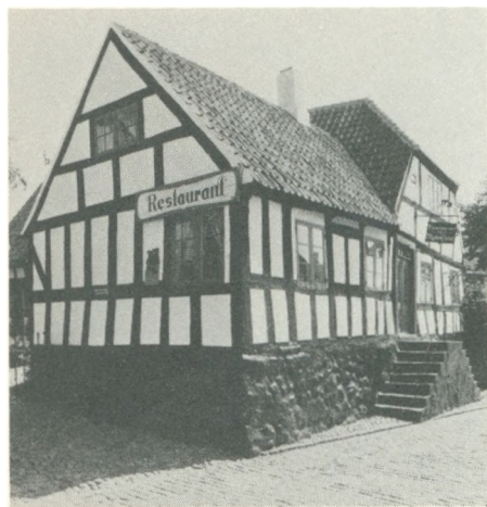
Ebeltoft er en sand guldgrube, når det gælder huse fra 1700-årene. Her er et af dem, bygget på den for så mange af byens huse karakteristiske høje sokkel, som bl.a. nødvendiggøres af det skrå terræn.
