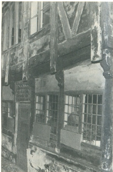
Stolpeskel på renaissancehus i Helsingør.
