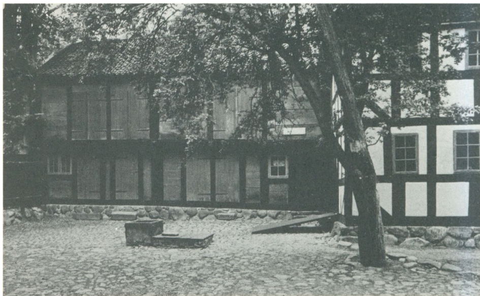
Købstadsbulværk fra 1700-årene. Det stammer fra ejendommen Slotsgade 11 i Haderslev, men er nu i Den gamle By i Århus.
