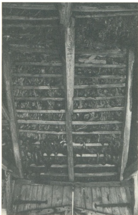
Læsø-tangtag set indefra. Vaskere og gumlinger er vredet om lægterne og danner en stoppende vold, så resten af taget ikke skrider ned.
