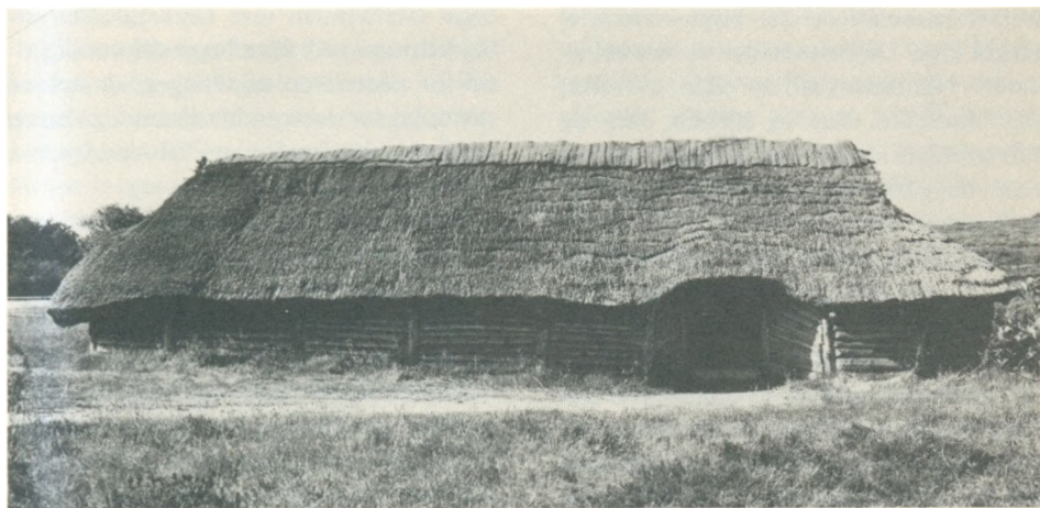
Tag på rekonstrueret bronzealderhus på Hjerl Hede. Det er bygget i en slags bulværk, og det strå-tækte tag har rygning af lange strimler græstørv lagt på tværs.
