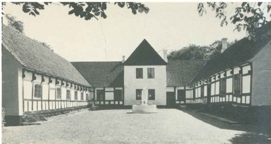
Den markante Bangsbo med grundmuret midterblok omgivet af bindingsværkslænger fra 1700-årene.
