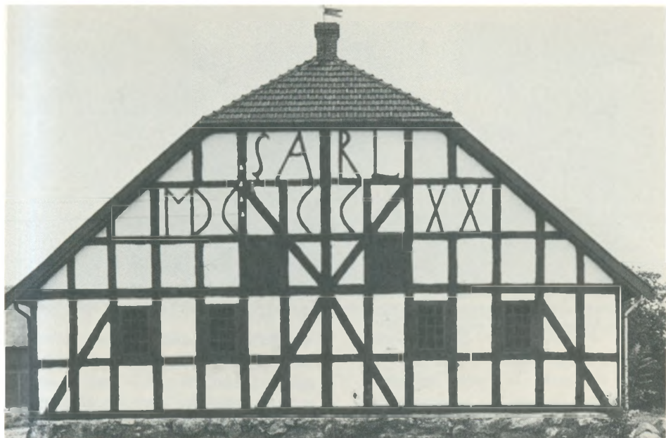
Forskellige skråbåndskonstruktioner. Her i Hvidkildes store kostald fra 1820 opført af Sophie Amalie Rantzau-Lehn. Ved hushjørnerne er der almindelige stormbånd, i husmidten en konstruktion af krydsede ranker.
