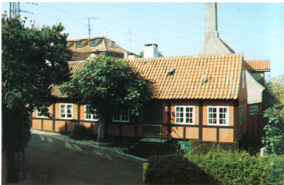
Et af Bornholms mange farvestralende bindingsværkshuse med den høje sokkel, der er så karakteristisk for bornholmsk byggeri.
