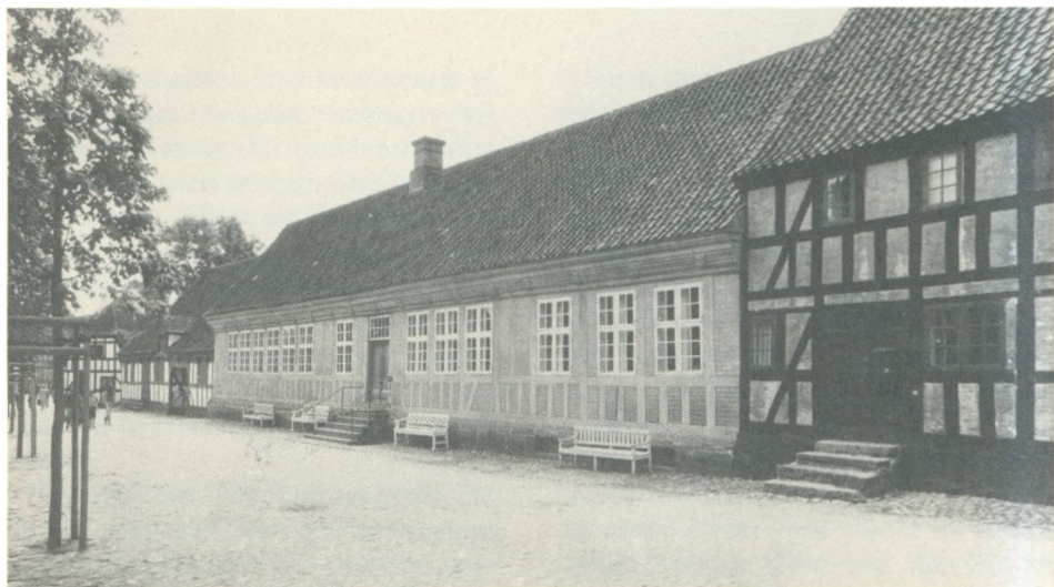
Møllergården fra ca. 1700 i Den gamle By er en enkel bygning med en vældig træ-gesims med rige profileringer for oven. Bjælkehovederne følger profileringen og markerer sig kun svagt.
