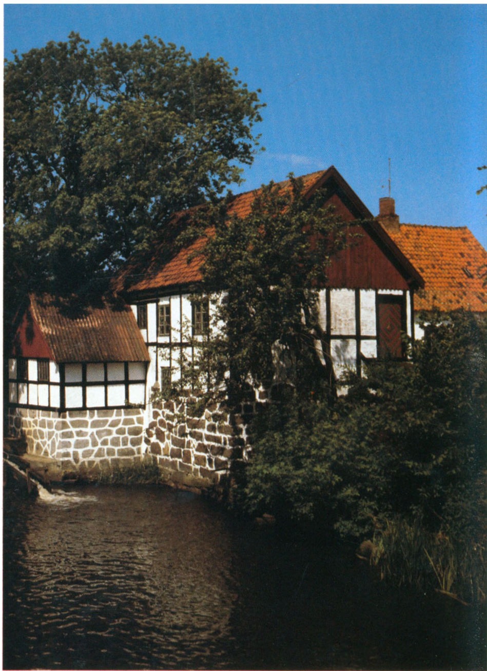
Sæbys vartegn, den gamle vandmølle fra 1710 med bindingsværk på høj kampestensokkel.
