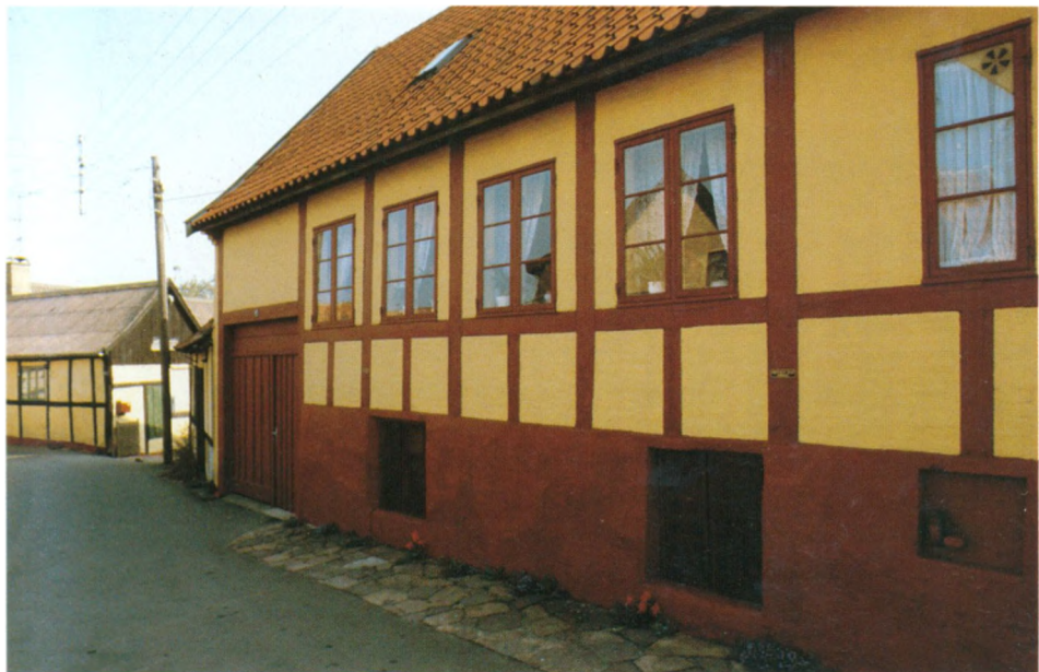
Der ses mange farvekombinationer på bornholmsk bindingsværk. Dette hus i Gudhjem har rodtømmer, gule tavler og dødenkop sokkel.
