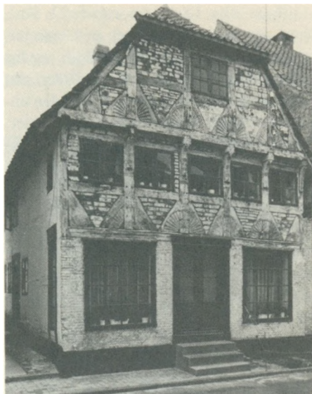
Gavlhus med rosetværk. Det ligger i Korsgade i Assens og var, da det fotografieredes, under restaurering. Her er der rosetter i to stokværk. Huset er fra 1575.
