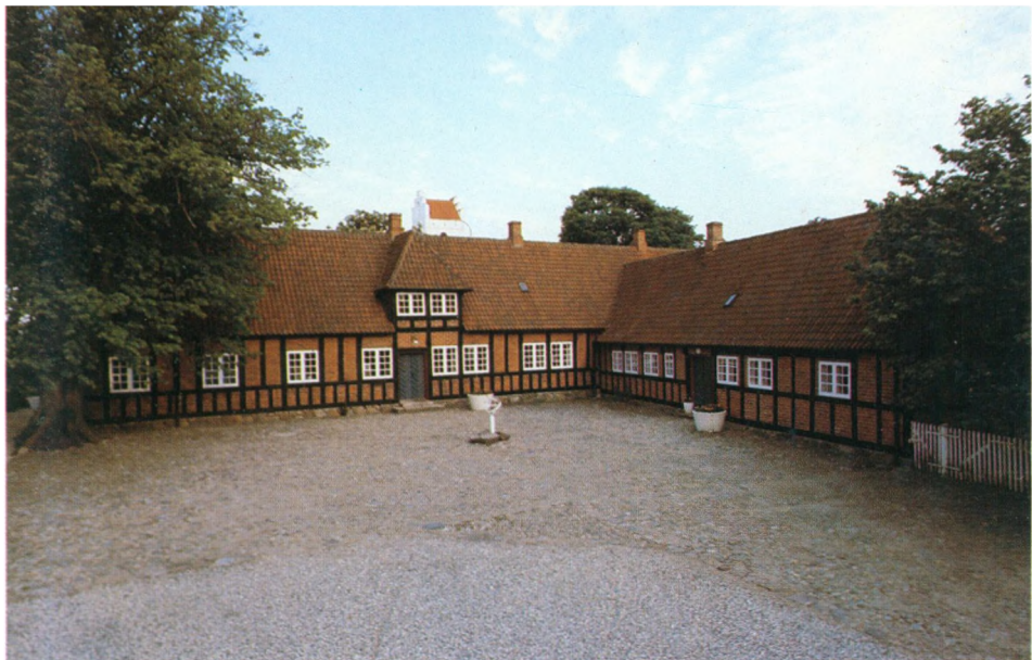
Feldhalle præstegård på Djursland. Et smukt, men ret hårdt restaureret anlæg.
