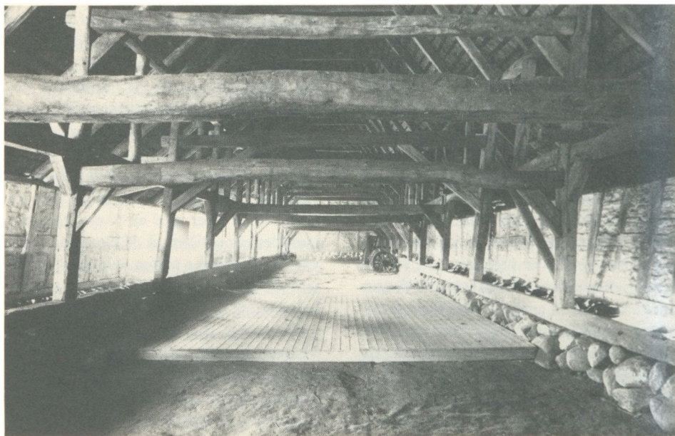
Højremskonstruktion i agerumslade fra herregården Fjellerup, nu i Frilandsmuseet i Sorgenfri. Bemærk, at de bærende stolper står i to rækker ned gennem huset. Stolperne i ydervæggene bærer ikke så stor vægt. Huset er treskibet, sideskibene kaldes også udskud.
