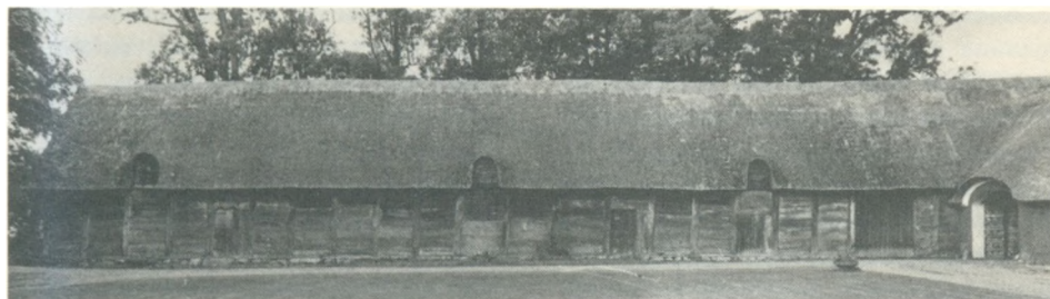
Den flotte præstegårdslade af bulværk fra Tyrstrup. Landets største nu stående bulhus.
