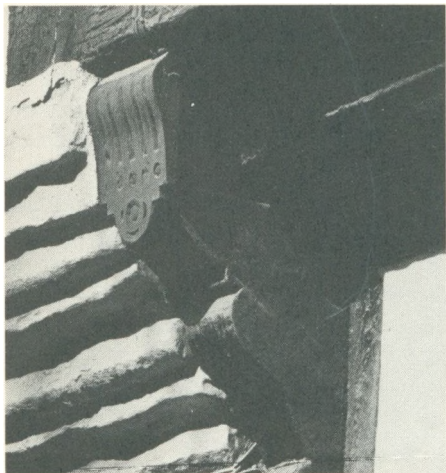
I et 1600-tals gavlhuis i Perlegade i Sønderborg er der sat smukt skårne dækplader på bjælkeenderne. Det pynter, og det beskytter bjælken mod indtrængende fugt.
