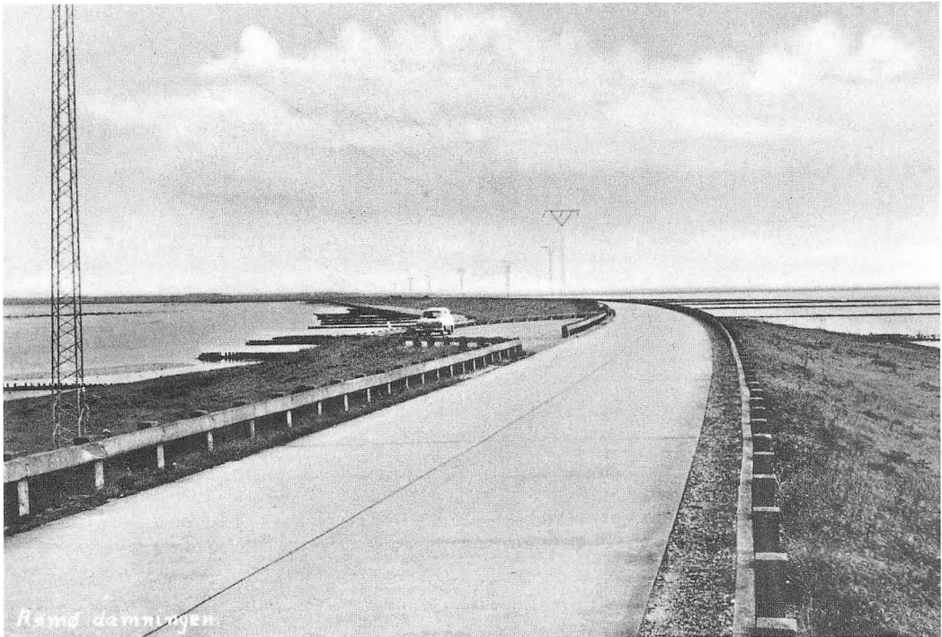
Efter lange, opslidende år lå Rømødæmningen færdig i 1948. Som beskæftigelsesarbejde var det en begrænset succes, og den etablerede vejforbindelse bedrede ikke meget på øens handel og landbrugets økonomi - opsvinget kom først senere i forbindelse med oplomstringen af turismen.
