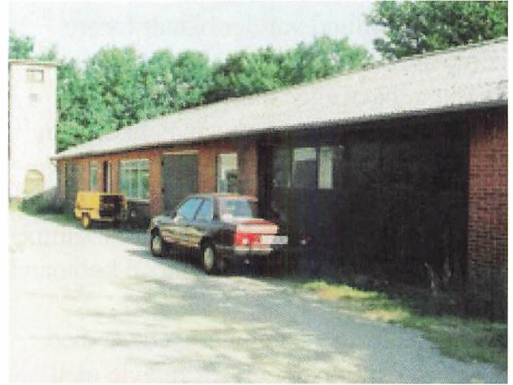
Elværksbygningen efter nedlæggelsen, hvor den i en kortere periode først i 1960'erne blev anvendt af firmaet "Alphamatic"
