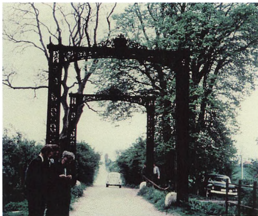
Den gamle støbejernsbro ved Kluvensiek-slusen er fra o. 1850
