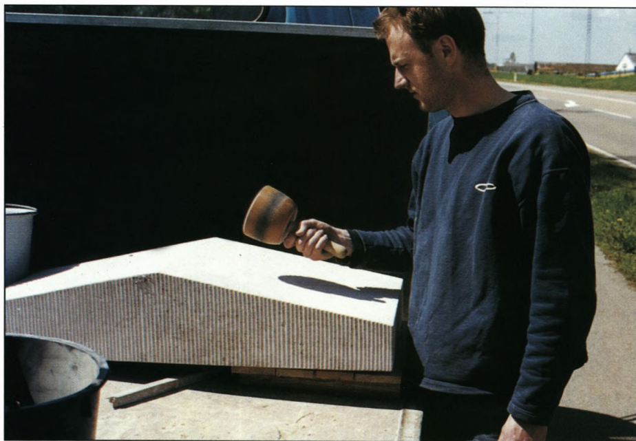
Stenhuggeren ses her ved en af de nye (halve) overliggere. Kanneleringen er udført i hånden!! Med knippel og mejsel -.
