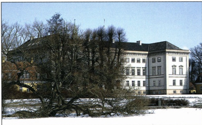
Hovedbygningen, december 2006, soranerarkivet.dk
