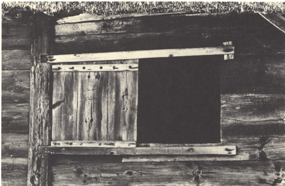
Skydelukke for luge. Pladen glider i træskinner dyvlet fast til bulhusets vægge. Hallandsgården, Frilandsmuseet.
