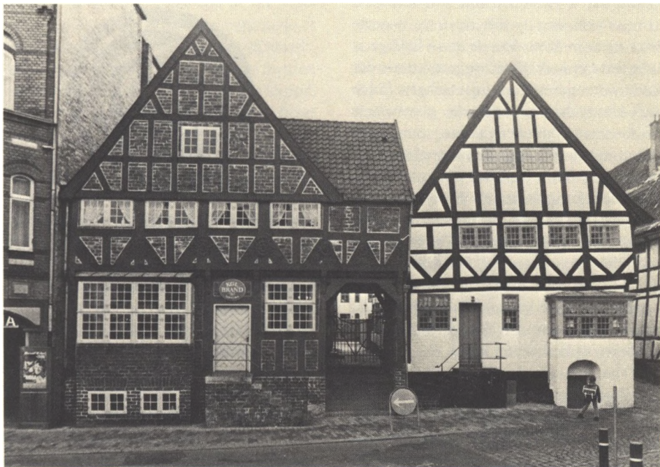
Renæssancehusene på torvet i Haderslev giver et ganske godt indtryk af, hvordan vinduerne kønt måtte føje sig efter bindingsværket.
