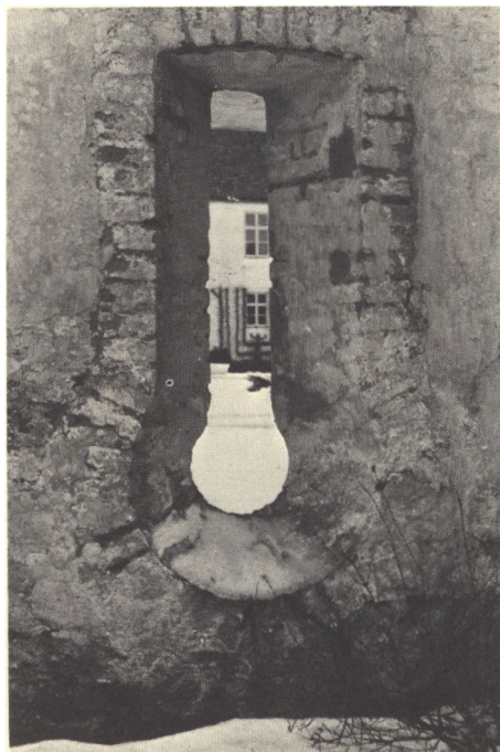
Skydeskår i middelalderlig spærremur på Dallund på Fyn set fra murens yderside.
