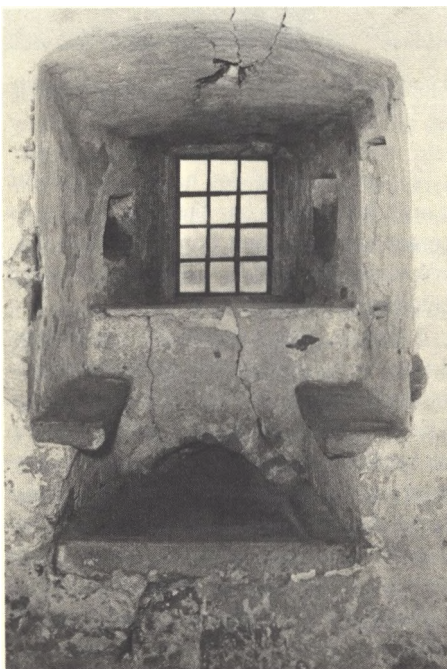
Selv i den strenge ridderborg var der brug for lidt bekvemmelighed. På Glimmingehus er der et lille vaskebassin - en piscine - med afløb gennem muren i en af vinduesnicherne.
