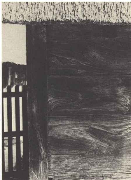
Et lille glughul i bulvæggen på Frilandsmuseets tvillinggård fra Gønge i Skåne.
