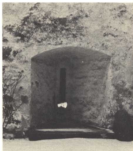
Spærremurens skydeskår set fra indersiden med skyttens niche.
