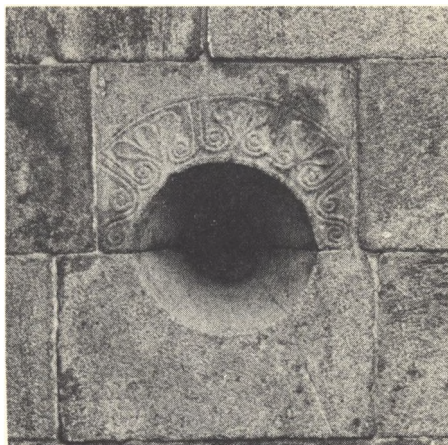
Det er sjældent, der er blevet gjort så megen stads ud af et spedalskhedsvindue, som tilfældet er i Hassing kirke i Thy.
