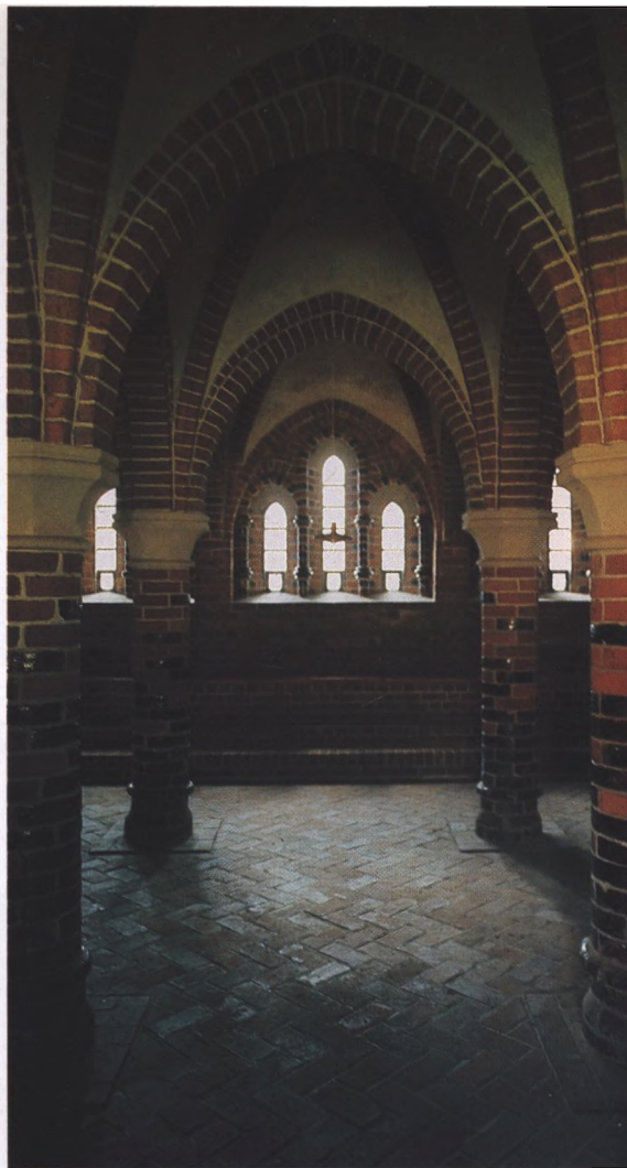
Et meget smukt eksempel på en triforium finder man i den restaurerede kapitelsal i Løgum Kloster, hvor vindueskonstruktionerne bæres af dværgsøjler.
