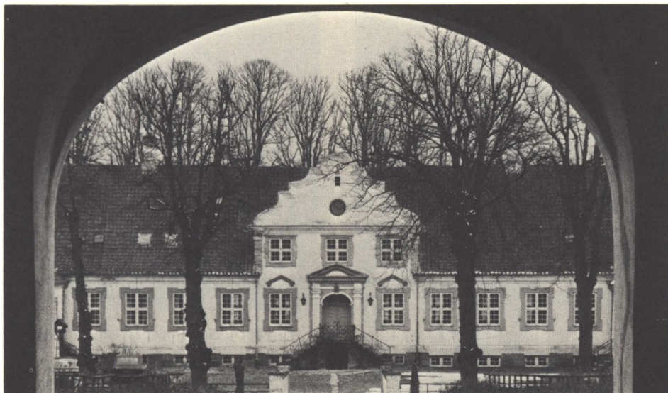
Gjesinggaard ved Randers. Et smukt senbarok-hus med flot portal og øregevændere om vinduerne i nederste stokværk. De svævende omvendte V-er over vinduerne kaldes fordakninger. De skal aflede regnvand.
