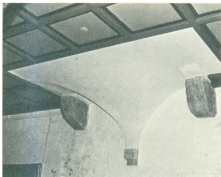
Konsolkonstruktion under kamin på overliggende etage. Kronborg.
