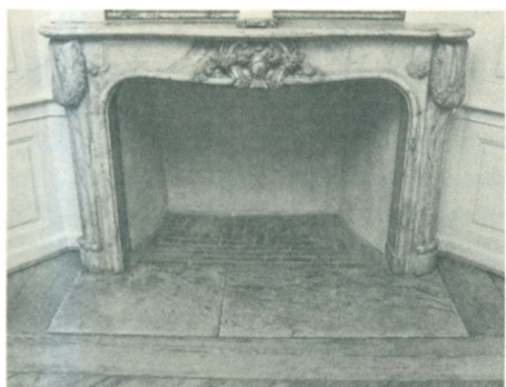
Klassicistisk marmorkamin på Marienlyst slot, Helsingør. Man ser her den ideelle bunddækning, hvor der inde i kaminen er muret med teglsten, medens der uden for åbningen ligger marmorfliser, som skal sikre mod at udirilende gløder kommer i forbindelse med trægulvet.
