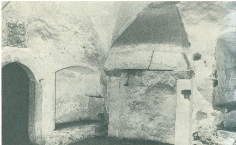
Sengotisk kamin på Glimmingehus. Den har både vanger, konsolsten, overliggersten og røgkappe eller røgfang.
