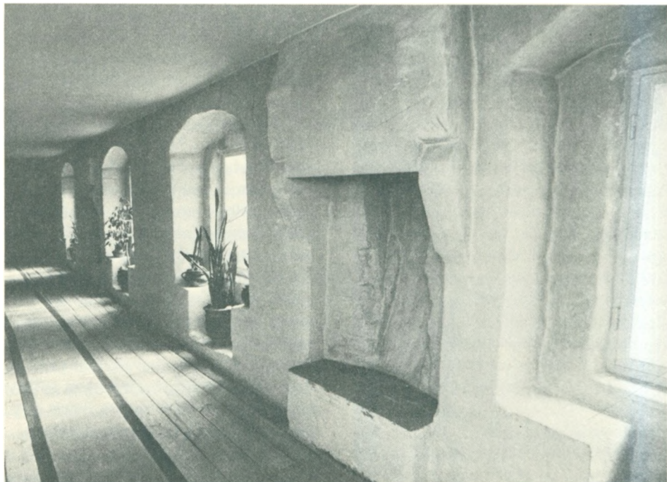
Korridor med kaminer til smeltning af beg og kogning af olie og vand til at hælde ud af skoldehullerne mod en angribende fjende. Vittskövle.
