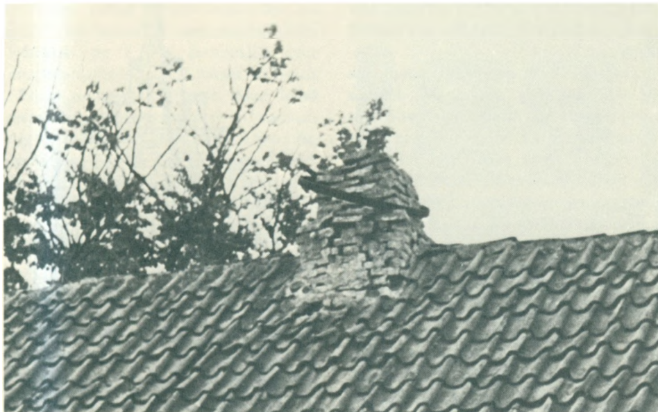
En skorsten nogle år efter en skorstensbrand. For at holde sammen på stenene, er der lagt et tondeband omkring den.
