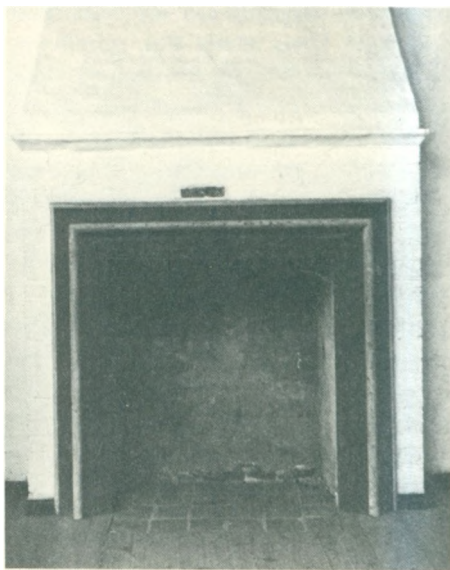
Med enkle midler kunne man opnå ganske nydelige virkninger: Her har en middelalderlig kamin på Spøttrup fået en profileret trækarm om åbningen og er dermed blevet omdannet til barok.
