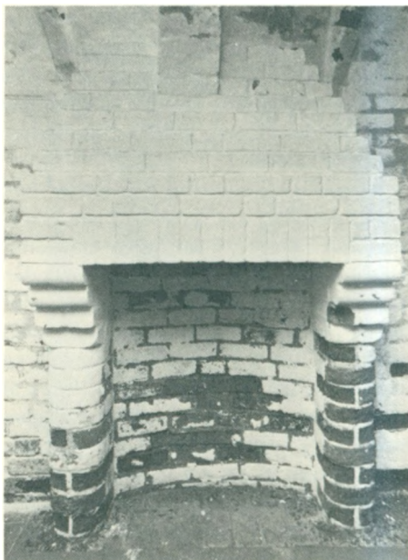
Kaminen i refektoriet på Brahetrolleborg. Røgfanget er noget restaureret.
