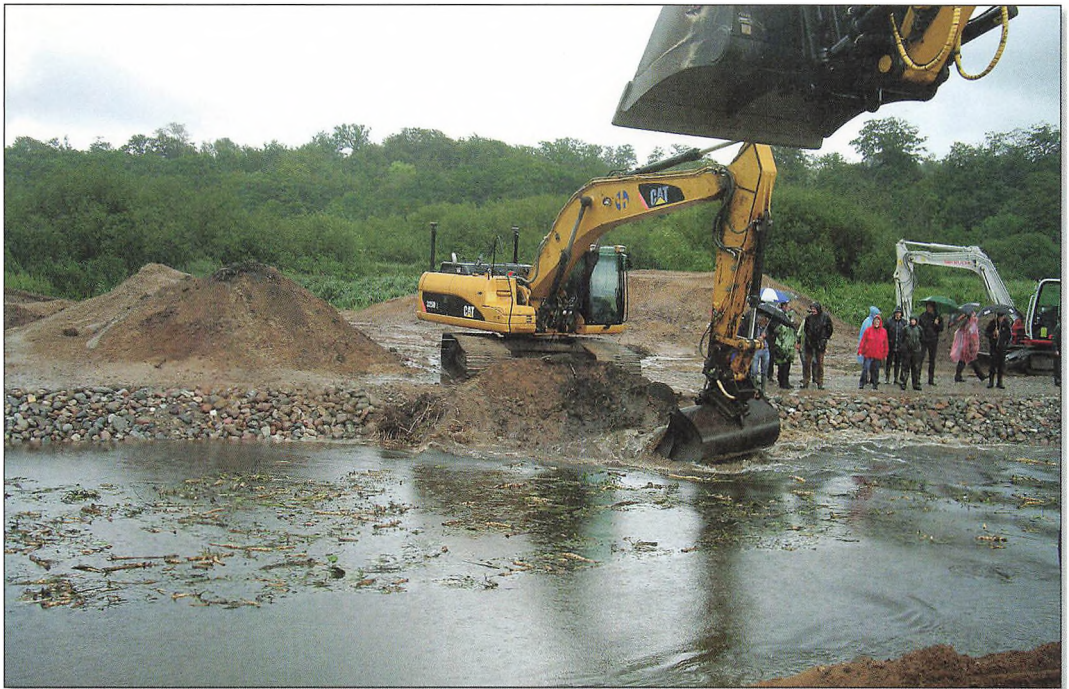
Det åbnes op for vand i det nye å-løb
