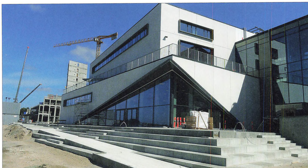
Vinduespartiet på Multikulturhuset rejser sig som en skibsstævne. Bag vinduespartiet er der cafe-område
