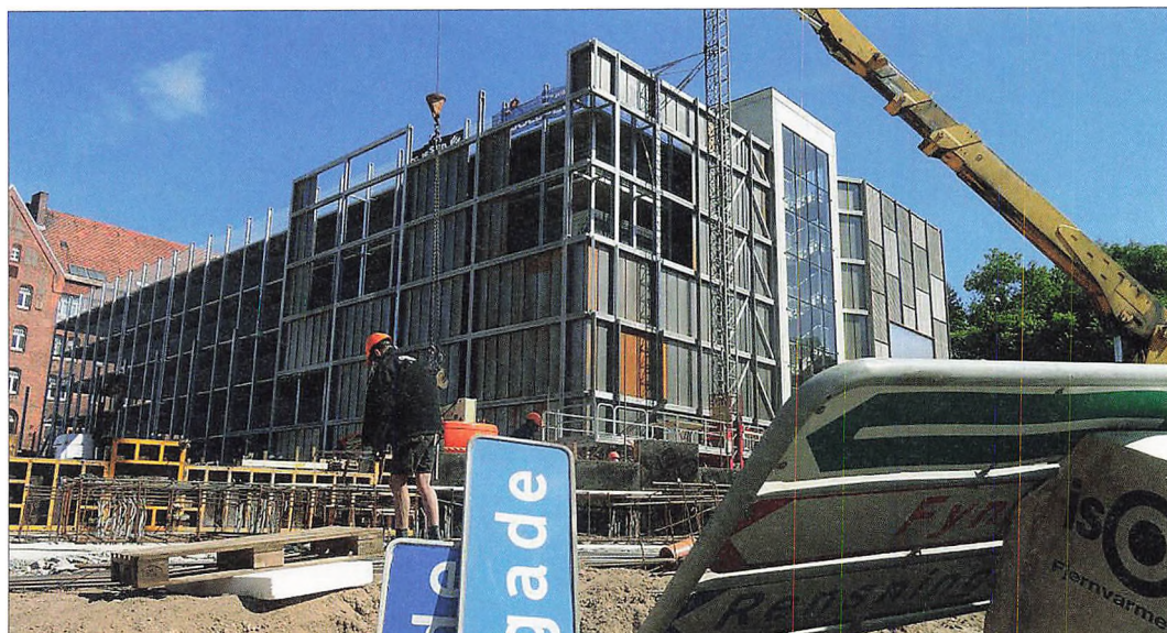
P-huset er en »let« konstruktion, bestående af betondæk lagt på jerndragere
