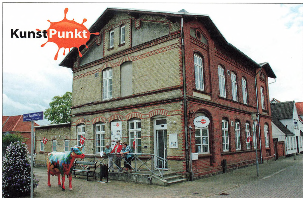
KunstPunkts hus, Storegade 14 i Augustenborg - det gamle posthus
