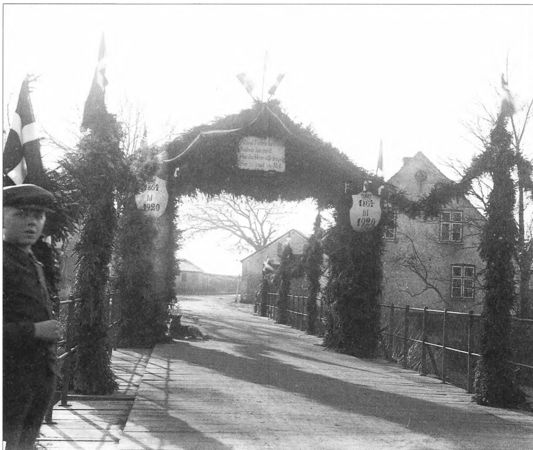
En af de mange æresporte, der blev rejst på afstemningsdagen – fotograferet før det dårlige vejr satte ind. (Foto: Niels Kjems, Arkivet ved Dansk Centralbibliotek for Sydslesvig)
