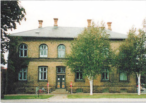
Jernbanegade 7 som museumsbygning i 2002. Bemærk at skorstenene er ført tilbage til deres oprindelige udseende, selvom de ikke længere er i brug
