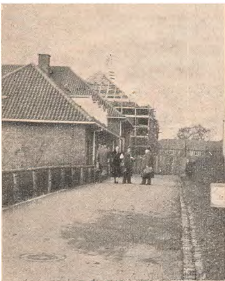
Kort før Jul rejstes Kransen over den store ny Skolebygning ved Knud Lavards Kirke i Kgs. Lyngby. Efter Sommerferien aabner den ny katolske Skole sine Porte og afhjælper et længe følt Savn.
