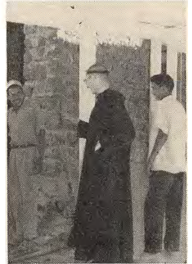
Der hersker god forståelse mellem benediktinermunkene og de marokkanere, der arbejder med ved klosterets opførelse. De indfødte håndværkere stifter her bekendtskab med moderne byggematerialer og konstruktionsmetode.
