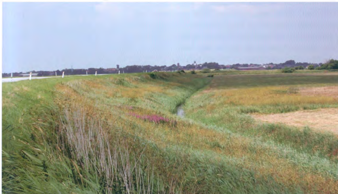
Del af diget fra Rudbøl til Højer med Højer i baggrunden. Diget er forhøjet nogle gange, men kernen udgøres stadig af Hans den Ældres dige anlagt 1554-1556. Foto 2005.
