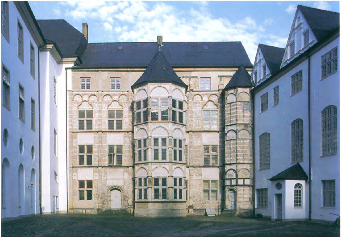
Frederik I vedblev at residere på Gottorp efter at være blevet konge, men han lod slottet udbygge, så det blev en mere fyrstelig residens. Ca. 1530 blev en ny vestfløj opført af form som et dobbelthus med en rigt udsmykket gavlfacade mod slotsgården og en karnap, hvor de to huse mødtes. Vestfløjen er betegnet som det tidligste renaissancehus nord for Elben. Facaden blev senere overpudset eller ødelagt, men er i årene 1978-85 frilagt og delvis genskabt, dog uden de to svejfede gavle.
