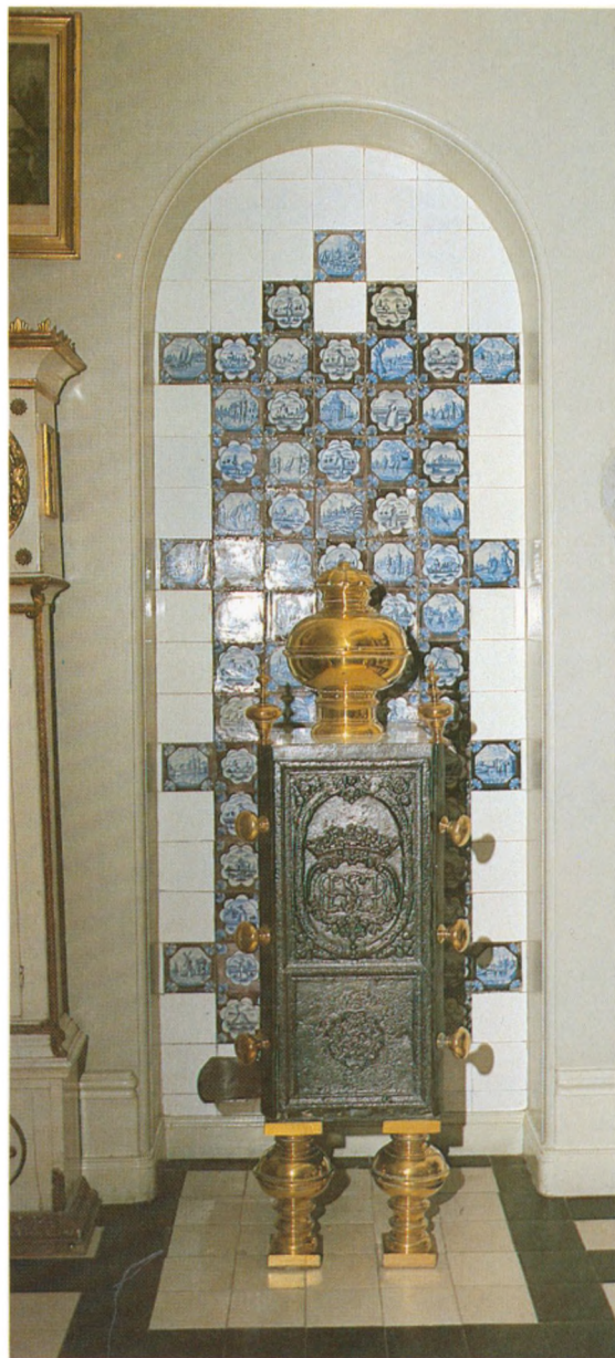
Vindovn med messingben, messingknopper og aftræksrør med gnistfang af messing. I den flade ovnniche hollandske blå og mangan dekorerede fliser. Godsejer Peter luel, Petersgaard.
