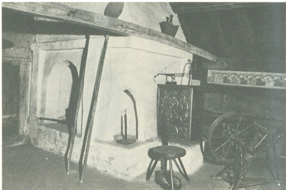
Et udmærket indtryk af, hvordan bilæggeren knytter sig til ildstedet, får man i dette billede fra Frilandsmuseets tvillinggård fra Gønge herred i Skåne. Der slipper ikke megen varme ud fra det helt indemurede ildsted, og derfor har man koblet ovnen til det. Bilæggeren er her af jern og af svensk fabrikat. Den minder en del om de tyske renæssanceovne.
