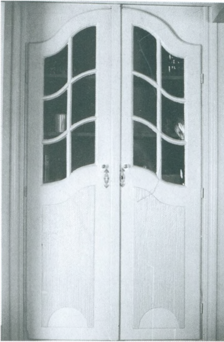
Billede 140: Vægfast skab fra begyndelsen af 1800-tallet. Skabsdørene er formet i Rokokostil og har Empire-profilerede fyldinger.
