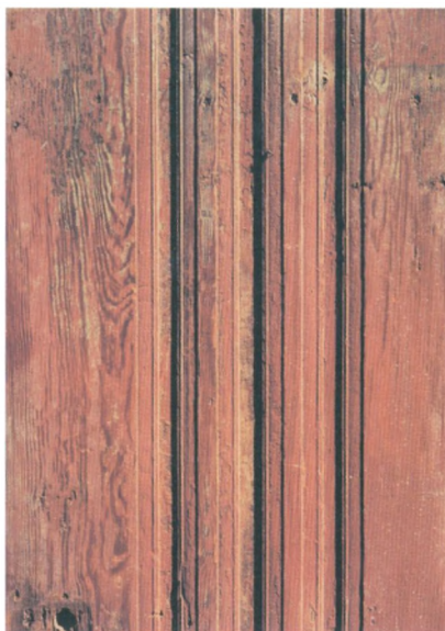
Billede 93: En revledør (udsnit) fra Kromose, dendrokronologisk dateret til 1640'erne. Den lodrette profilering er tegnet på billedet 99, nr. 4.
