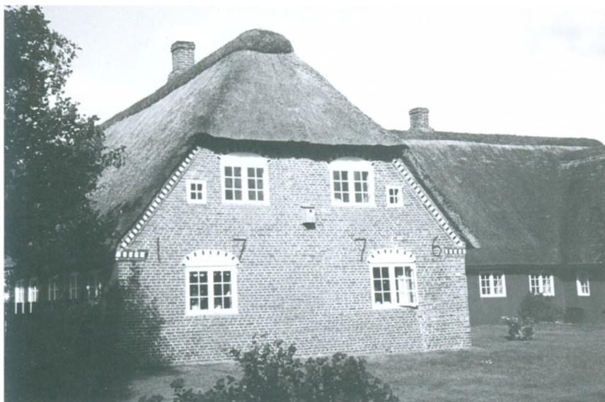
Billede 132: Østgavl af et hus i Tvismark med udbygget loftetage fra 1776 (art. 79 Kongsmark).
