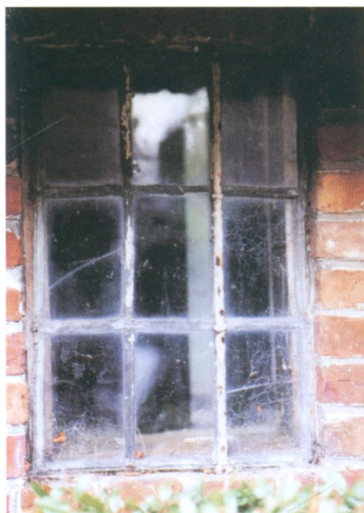
Billede 136 (t.v.): Typisk blyindfattet vindue fra Rømø med lodret forstærkning.
