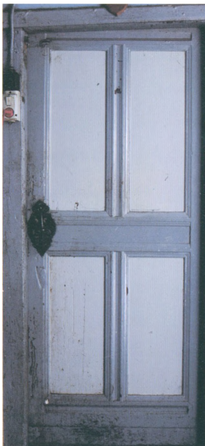
Billede 97: 4-fyldingsdør i Juovre, der efter konstruktionen at dømmes er fra 1600-tallet. Det gælder også for dørgrebet (se billede 107). (Foto Hanna Højland)
