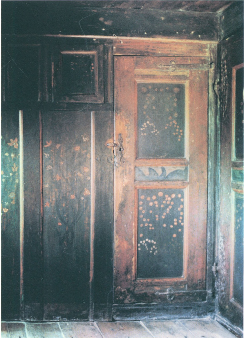
Billede 98: 2-fyldingsdør med langhængsler, sandsynligvis fra 1600-tallet, i Frilandsmuseets Rønmøgård. Blomstermaleriet er formodentlig fra første halvdel af 1700-tallet.
