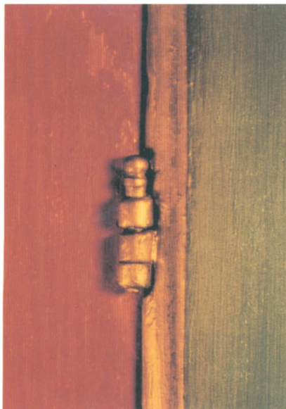
Billede 105 og 106: T.v. et barok-dørhængsel og t.h. et stifthængsel ved en alkove, begge fra 1730'erne.
