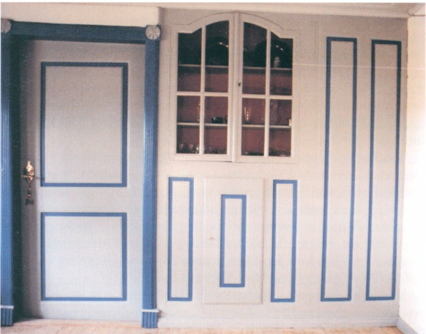
Billede 141: Et tredje eksempel fra samme periode, med årstal 1816 på dørens låseskilt (se billede 144). Dørkarmen har profil nr. 4, billede 114. Også uden profiler på væggen andre elementer bliver lodlinien forstærket pga. smalle panelfyldinger og dørens inddeling.
