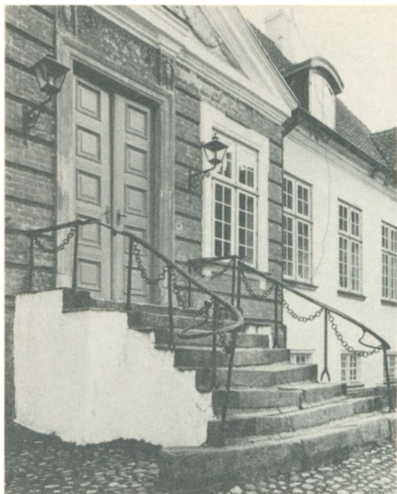
I 1700-årene var det en yndet prydding med nedhængende lænker fra trappegelænderet. Serridslevgaard.
