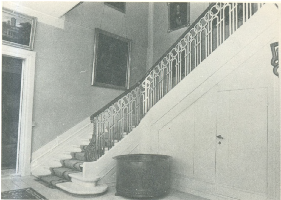
Hverringes elegante og lette klassicistiske trappe. Den har gelænder af forgyldt træ, – antagelig skal det efterligne tidens smedede og forgyldte franske trapper.
