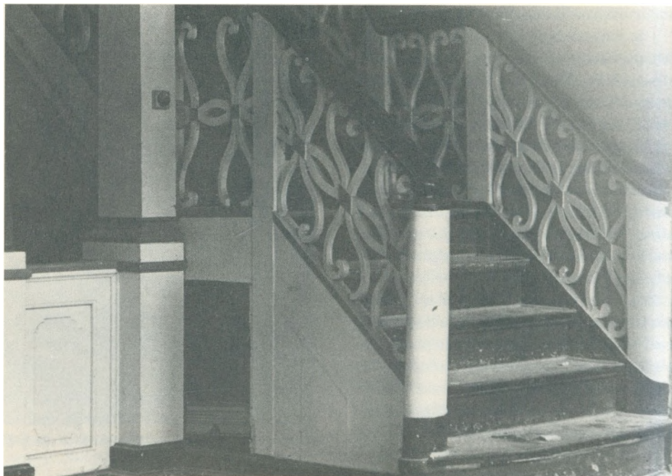
Del af større trappeparti i hus i Badstuegade i Haderslev. Huset er for tiden afspærret, så trappen måtte fotograféres gennem en vinduesrude.
