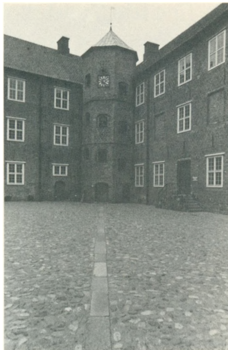
Stigende vinduer følger trappens stigning i mange trappetårne som her på Søndersborg slot.
