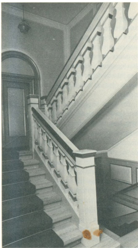
Baroktrappe med balustergelænder, – såkaldte dokkebalustre og firkantede mæglere som afslutning for hvert afsnit. Der er tale om en toløbs-trappe. Håndlisten er meget svær og bred. Vemmetofte.
