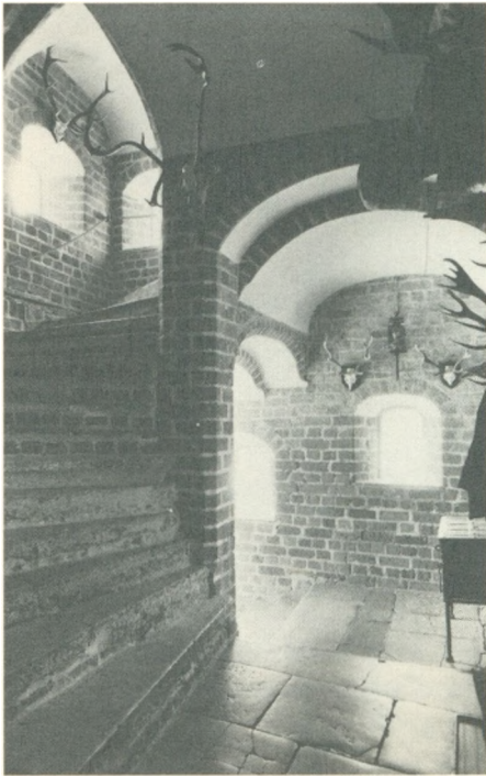
Trappen i Borrebys tårn har en ret spinkel kerne. De hvidtede kurvehankshvælv ender i affasede, uhvidtede sten.
