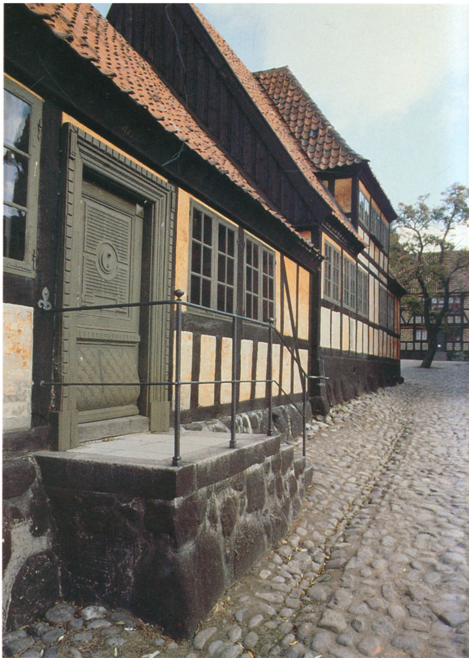
Enkelt fritrappel med høj sokkel af tjærede marksten. Købstadsmuseet Den gamle By, Århus.
