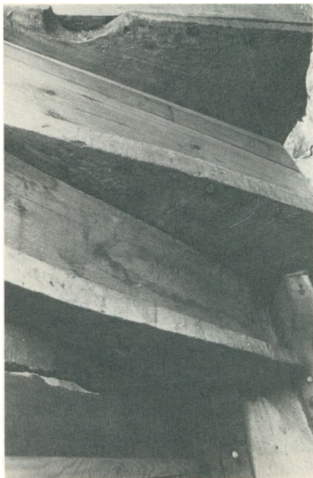
Medens trinnene på murværkssiden er fastmurede i væggen, hviler de på bindingsværkssiden på små konsoller eller knægte (Veng kirke).
