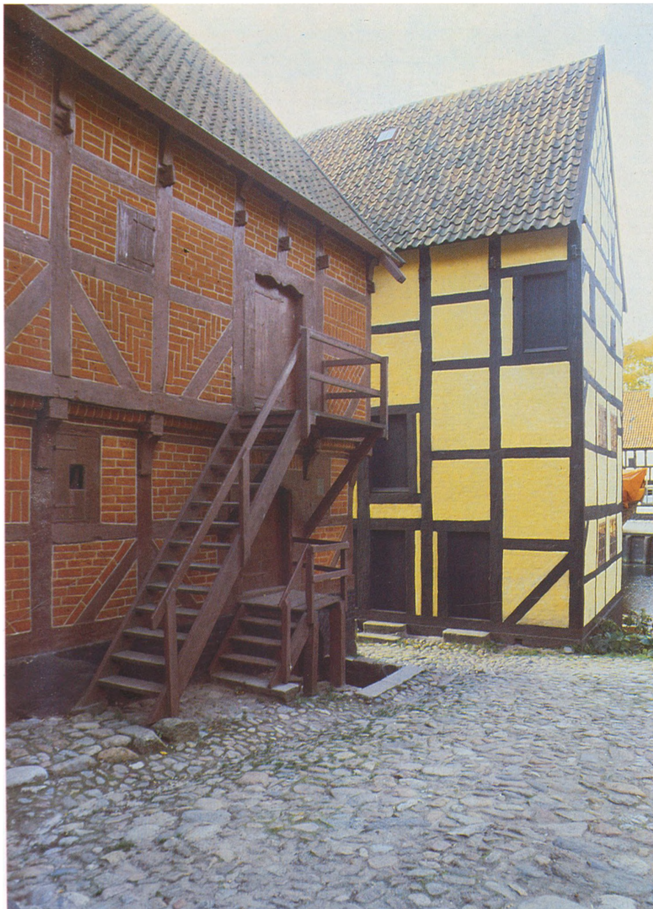
Udvendige trapper til første og andet stokværk. Den gamle By's Aalborg-gård.
