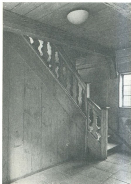
Lille baroktrappe med udsavede balustre i »Møntergården« i Odense.
