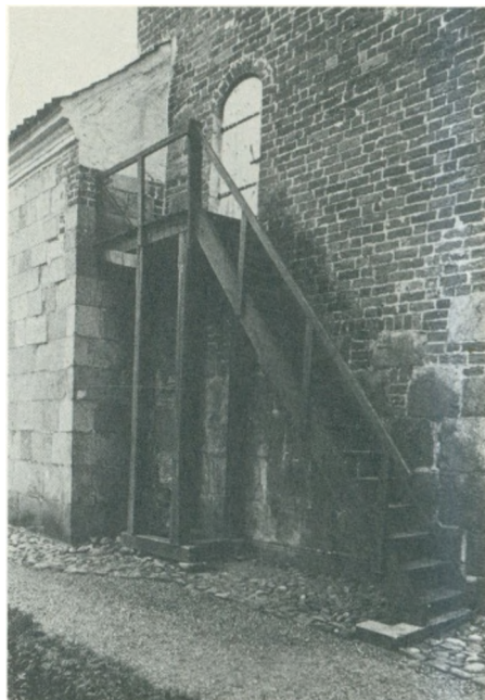
Trappen op til Sjørring kirkes tårn bæres af fire kraftige stolper og har repos for oven.
