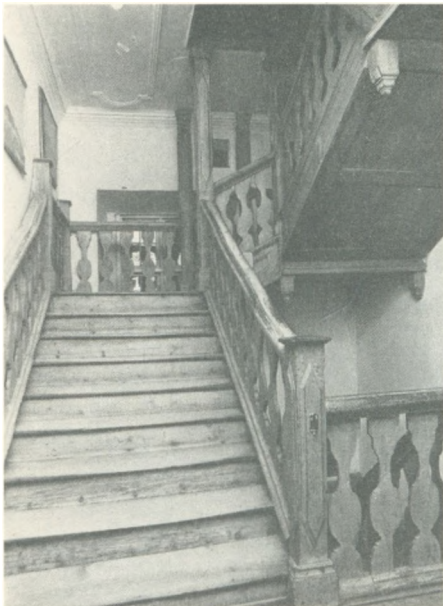
En af de 10 store baroktrapper på herregården Bidstrup. Med sine hængende stolper er den meget let og elegant konstruktion.
