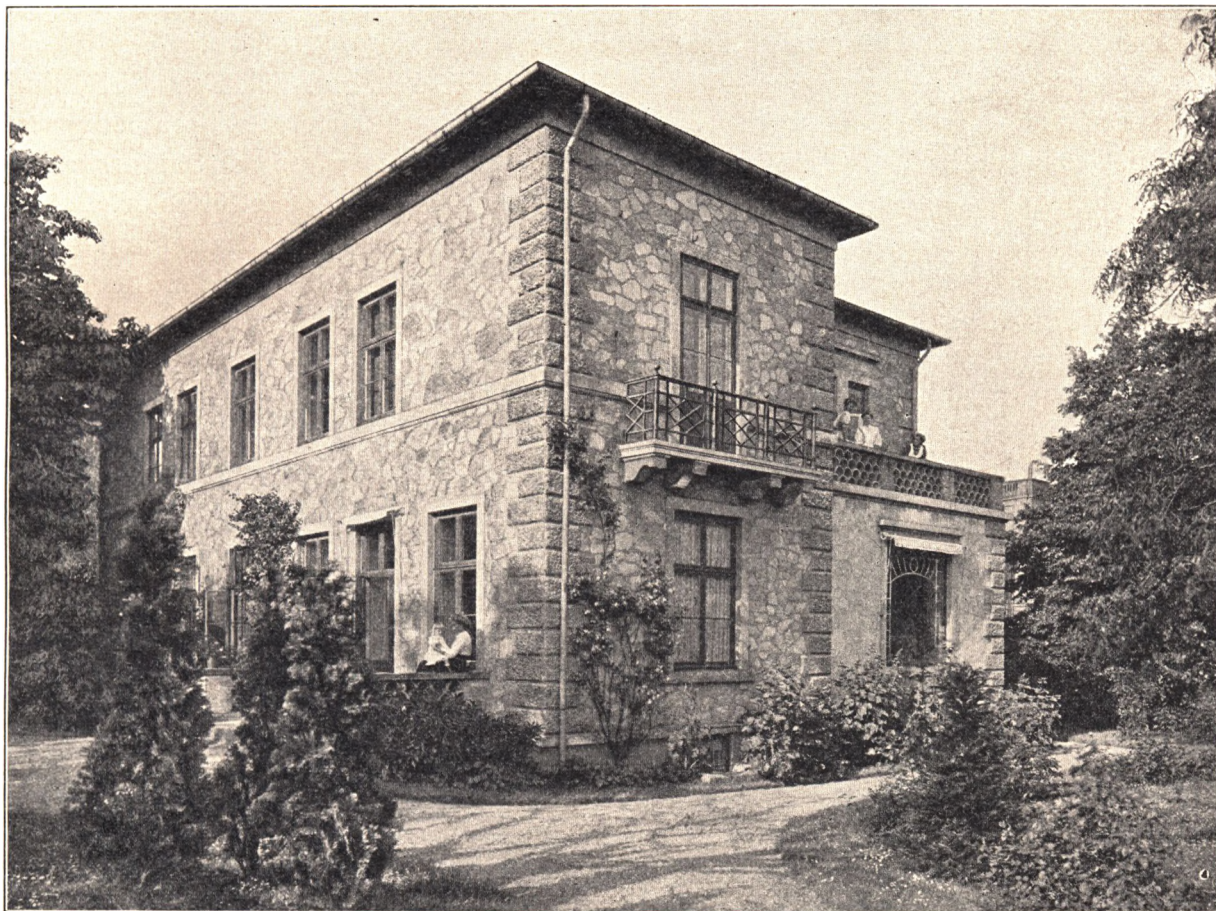
Faxehus. Opført efter J. C. JACOBSENS Tegning 1875.
