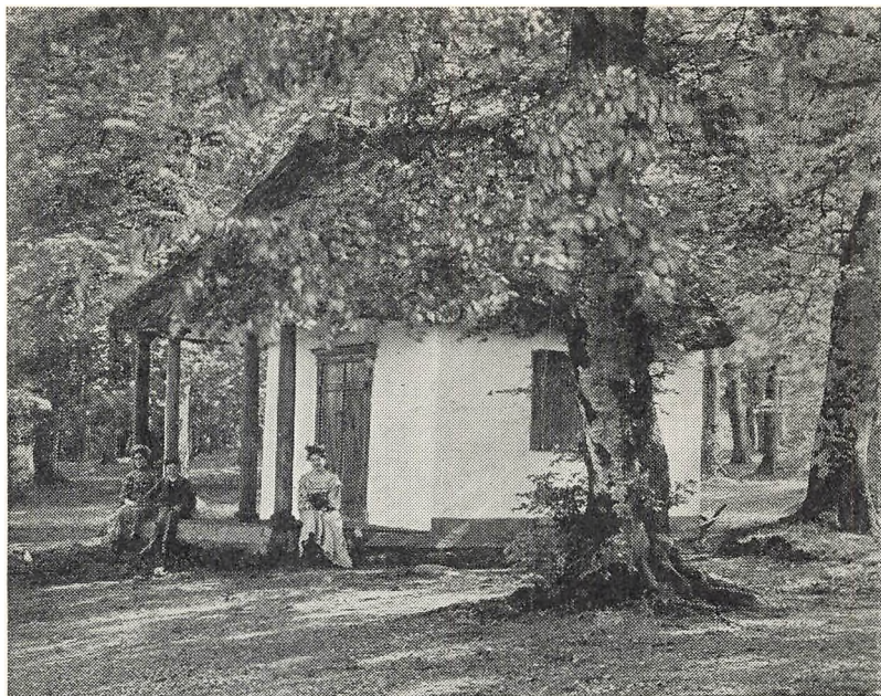
Kildehuset i St. Bøgeskov.
