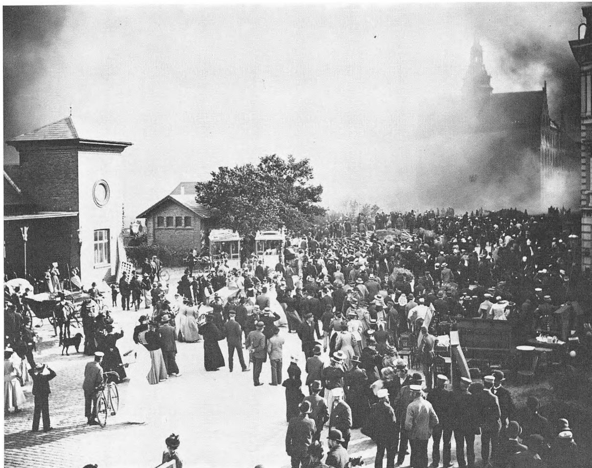
Mejlborgs brand set fra Østbanetorvet. Midt i det store opbud af tilskuere står møbler og andet indbo, som er slæbt ud af de truede lejligheder. Ved Østbanegården holder to af vognmand J. C. Dyhrs hesteomnibusser, der i årene 1896–1903 kørte mellem byens to banegårde.
