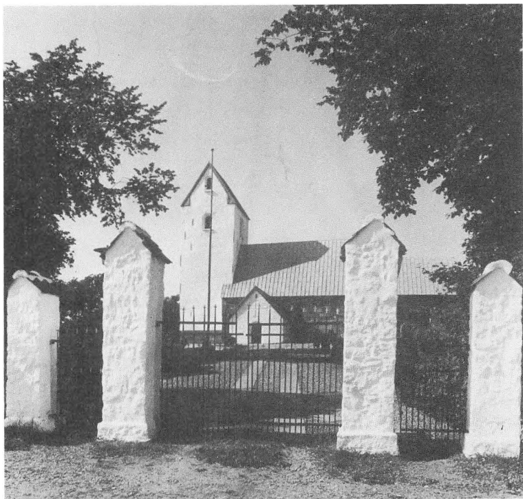
Vorde kirke på hvis murværk der endnu ses hesteskomærker på nordsiden af koret.
