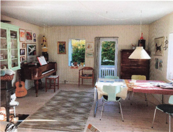
Opholdsstue på første sal efter at skillevæg og to døre er fjernet. Før 1989 var det to store værelser med udgang til altan og tagterrace. Foto: 2023 Jan Arnt
