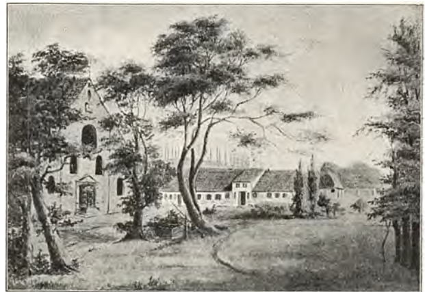
Kirkepladsen i Sorø og Hovedbygningen under Opførelse i 1825.
