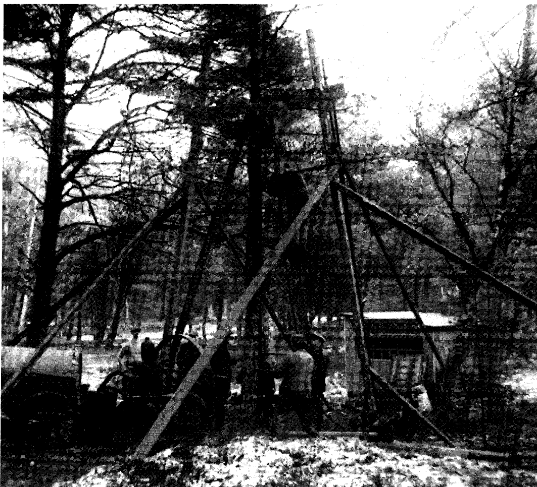
Fig. 28. Eksempel på kulboring: Teknisk Centrals mejsel-skylle-boringer syd for Hasle, 3. december 1943. Boremester: E. J. S. Schmidt; geologer: dr. phil. Helge Gry og mag.scient. A. Nørvang.
