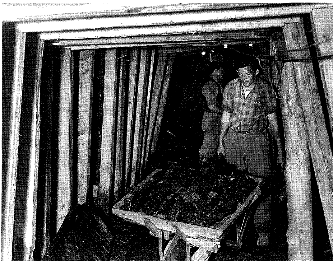
Fig. 55. Arbejdet under jorden. (III). Kultransport i stolle I i statens underjordsbrydning, 30. juni 1948. (Foto: C. Gerli.)
