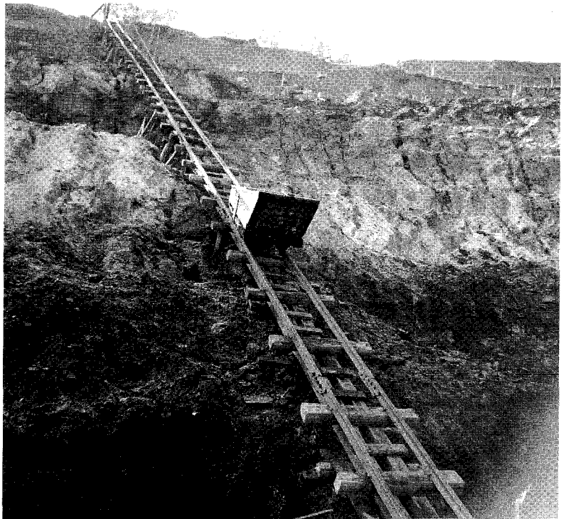
Fig. 50. Kullene trækkes op ved hjælp af et spil. Foto: Kaare Rasmussen. (Bornholms Museum.)
