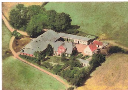
Kalkær 6 efter nyopførelsen i 1935
