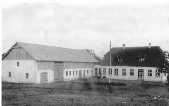
Den nyopførte ejendom på Sønderborgvej 150
