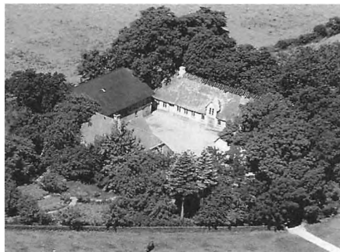
Varnæsvej 595 Foto 1920 Nederst i billedet t.v. ses et nyere stuehus Bygningen med kvisten er det gl. stuehus
