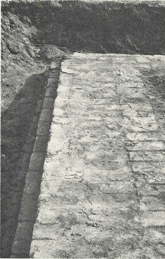
Hjørne af den næsten kvadratiske bygning, der har ligget op ad østmuren lige syd for porten — måske et vagthus. Muren har været 3 sten tyk, d.v.s. ca. 85-90 cm.
