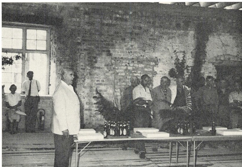
Arkitekt Peter Koch taler ved en sammenkomst i slottets sydøsthjørne, da første afsnit af restaureringen var afsluttet med nyt tag på østfløjen.
