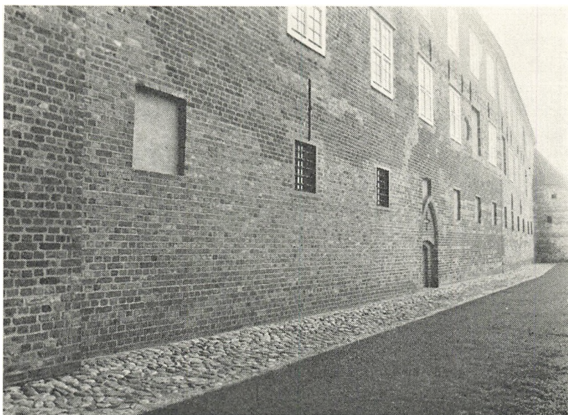
Slottets nordmur efter restaureringen, set mod vest med nordvest-tårnet i baggrunden. Den ældste hovedindgang, der nu er tilmuret, ses ligesom knækket midt i muren.
