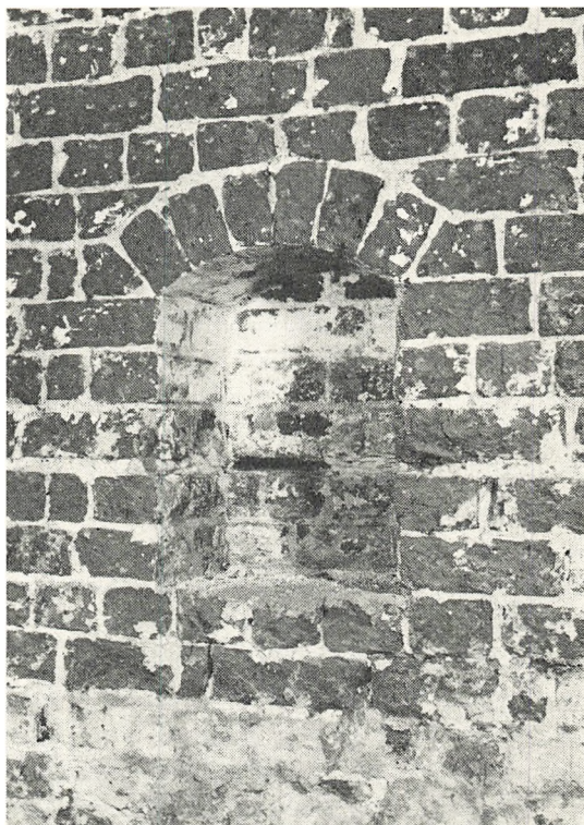
Vægniche (skab?) i Drabantsalen, fundet ved restaureringen. I den brede fuge midt i har måske siddet en hylde.
