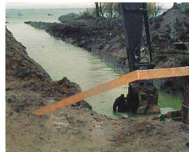
Fig. 19. Etablering af vandledning til Kalundborg i 1998. Vandet fra Tissø er i de seneste årtier blevet en betydelig ressource for industrierne i Kalundborg. Kommunen renser overfladevandet til drikkevandskvalitet og leder det videre til byens bioteknologiske og farmaceutiske virksomheder. Foto Torben Jørgensen, Kalundborg Kommune.
