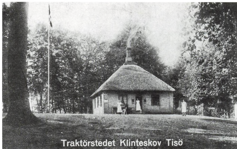
Fig. 7. Traktørstedet i Klinteskov ved østbredden af Tissø. Den lille skovrestaurant var oprindelig en skovfogedbolig, hvor man skaffede sig biindtægter ved at servere kaffe m.m. for skovgæsterne. Det var et yndet besøgsmaal ved pinsefesterne på egnen. I dag er der indrettet skovbørnehave i huset. Postkort fra 1912, Høng Lokalhistoriske Arkiv.
