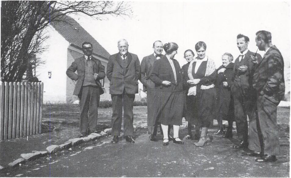
Forår 1931. Mundtlig eksamen i ældste klasse. Skolekommission og lærerne efter middagen hos førstelæreren. Yderst til højre med pibe, den uundværlige endnu, i munden andenlærer H.N.
