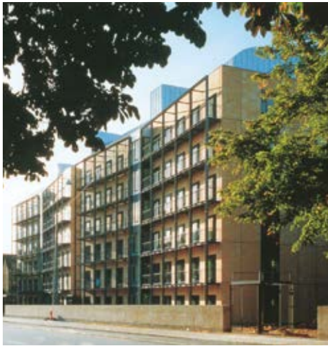
Den nordre tilbygning til det brutalistiske højhus var (lige som den søndre) tegnet af Dissing+Weitlings Tegnestue, en videreførelse af den verdenskendte danske arkitekt Arne Jacobsens firma. ©Københavns Universitetsbibliotek Frederiksberg
