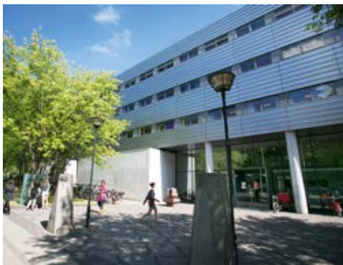
Den søndre tilbygning til højhuset, som foruden institutarealer rummede store auditorier og bygningskompleksets indgangsparti. ©SCIENCE Kommunikation
