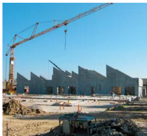
Opførelsen af det nye, tidssvarende stordyrshospital i Tåstrup. ©SCIENCE Kommunikation
