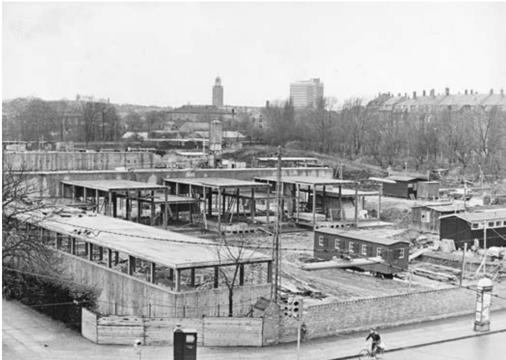
Byggepladsen på den tidligere forsøgsmark, hvor højhuset var under opførelse. I baggrunden ses Frederiksbergs Rådhusstårn og det i 1954-59 opførte Falkoner Center. ©Det Kongelige Bibliotek
