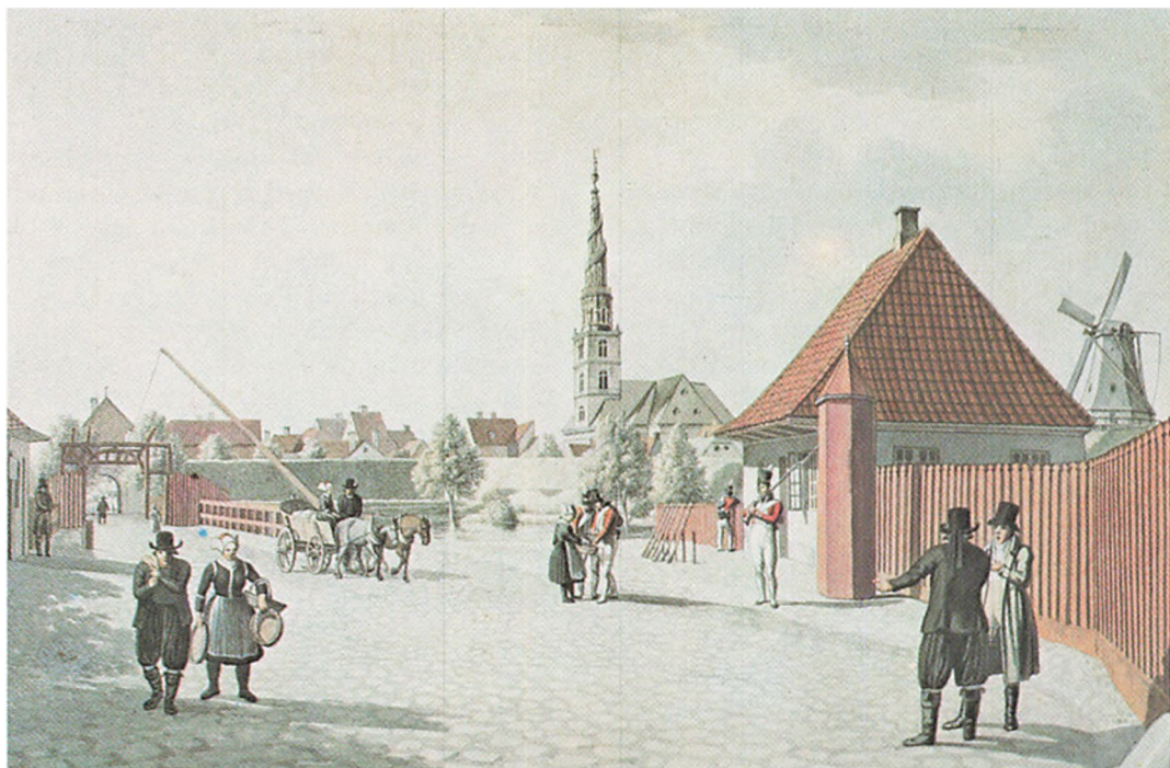
Amagerport og vagtuset i Ravelinen.
