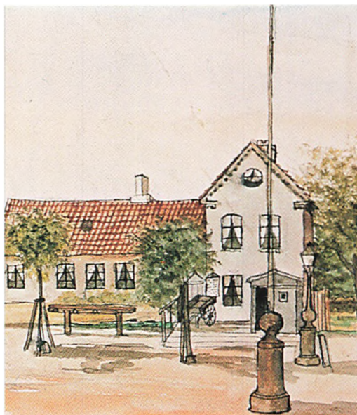
Bomhuset på Amagerbrogade.
