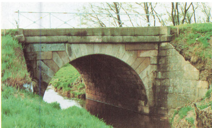
Nybro ved Åsted Å mellem Hjørring og Frederikshavn, opført 1847. Først så sent som i 1981 blev det nødvendigt at udarbejde projekt til vej- og broudvidelse. G. Kunwald fot., 1981.
