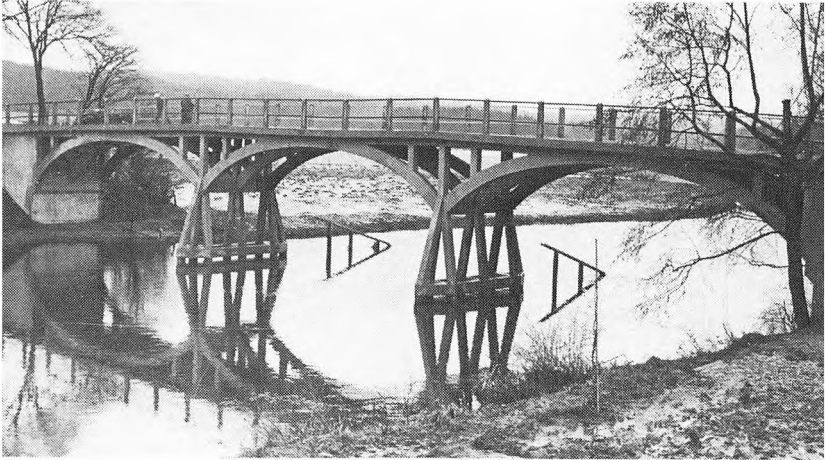
Amtmand Hoppes Bro, opført 1905. Danmarks ældste jernbetonbro. Siden 1965 har den fungeret som gangbro i et smukt anlæg, der strækker sig over åens bredder. Christiani & Nielsen fot., 1965.
