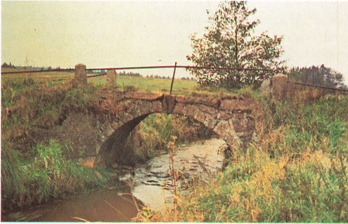
Kobro ved Bredevad på den nu nedlagte landevej mellem Åbenrå og Tønder. Broen, som blev opført i 1820, er fotograferet af artiklens forfatter, 1983.
