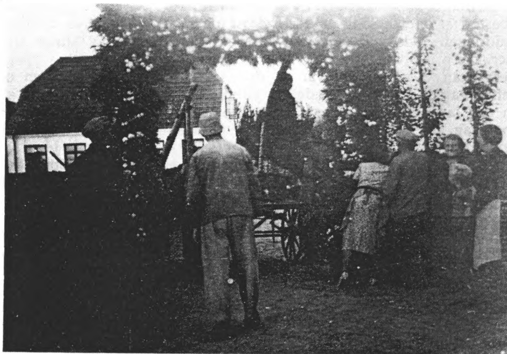
Der bygges æresport hos Brøndgraveren.
