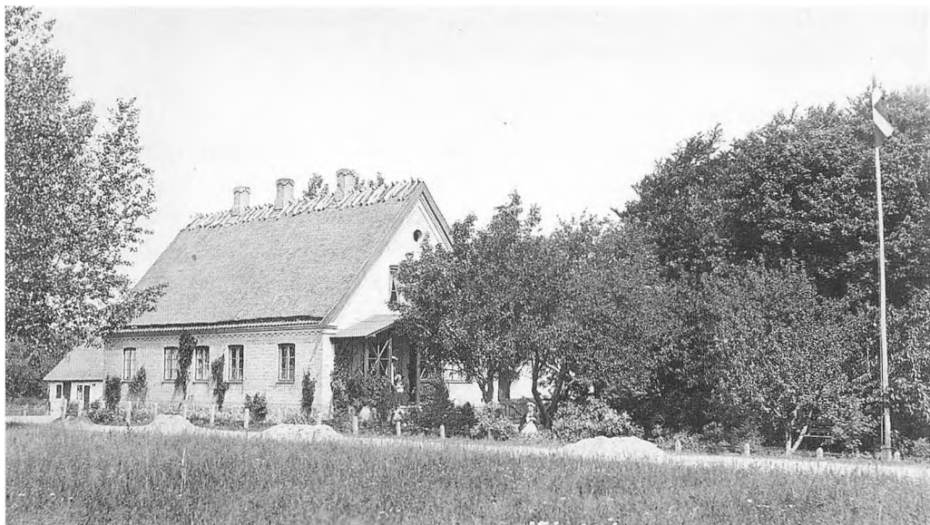
Lægeboligen ved Tersløse Bøgeskov. 1880.
