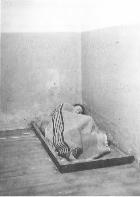
En såkaldt betonseng.
