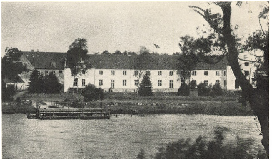
Søgaards nye Hovedbygning.
