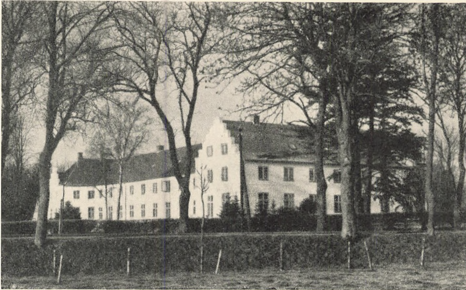
Søgaards nye Hovedbygning.
