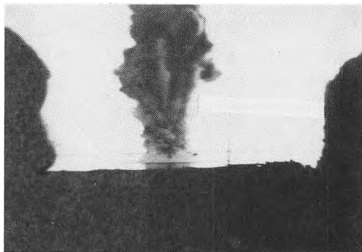
Vandsøjlen ved sprængningen af flyvraget af Lancaster nr. ND 365 ved Vornæs, udført af et tysk sprængningshold kort tid efter nedstyrtningen. (Foto: Anders Poulsen).
