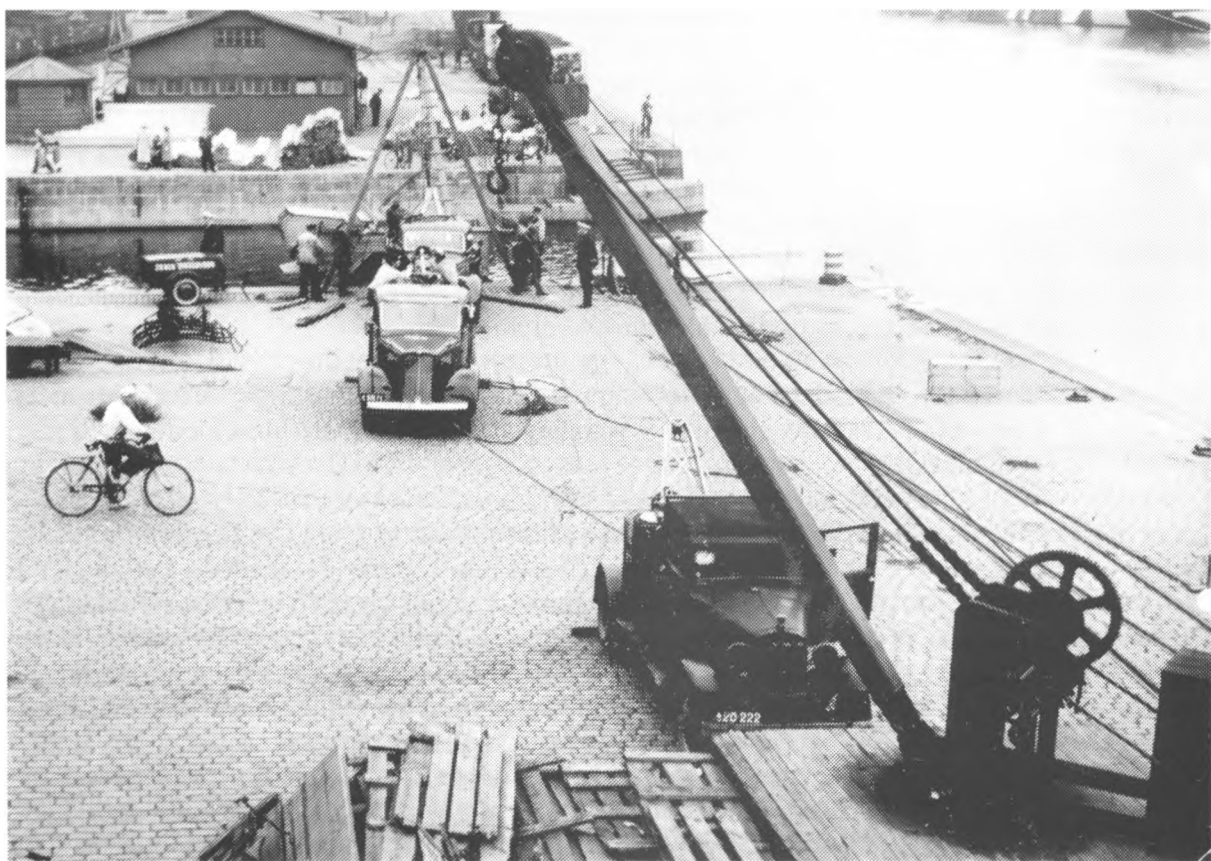
Tærskværk optages af havnen ved Langebro. Øverst forsøges med en kranvogn, - og det var ved at gå galt. Nederst nyt forsøg med tre kranvogne - og det lykkedes
