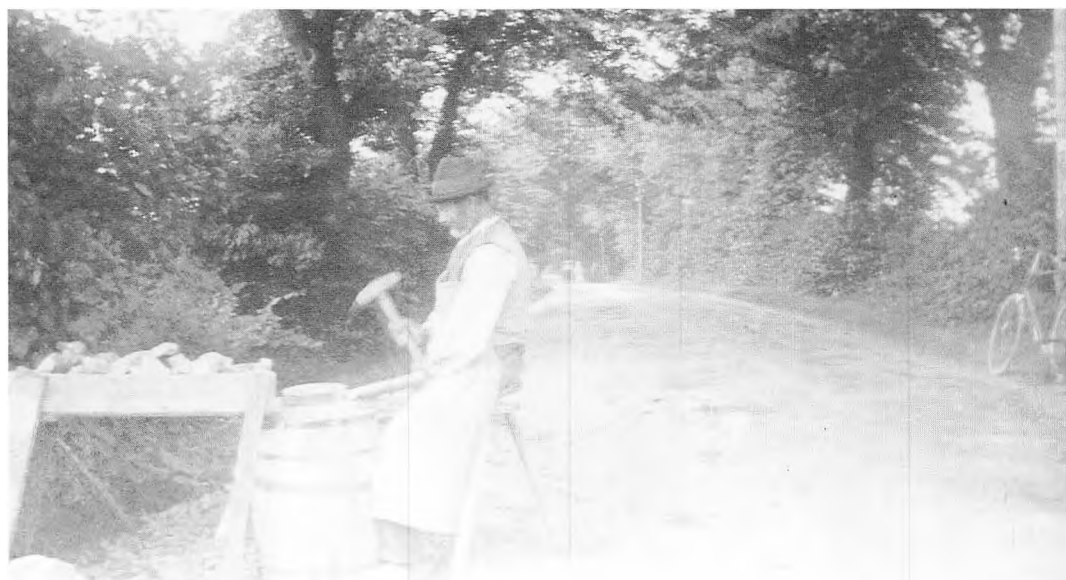
Stenslagning i Eskær-alléen, nuv. Troensevej. (Foto: H. Palludan Rasmussen).
