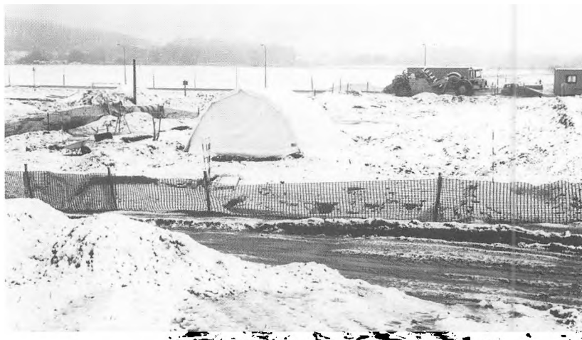
5. Udsigt over gravpladsen. Bemærk elevatorskraberen foran skurvognene.
