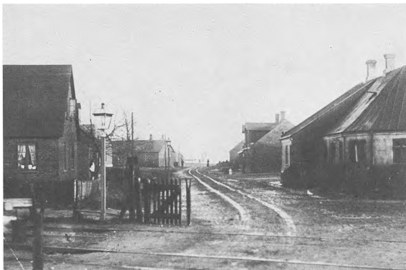
Tim. Baneoverskæringen ved hovedgaden ca. 1911. (Ringkøbing Lokalhistoriske Arkiv).
