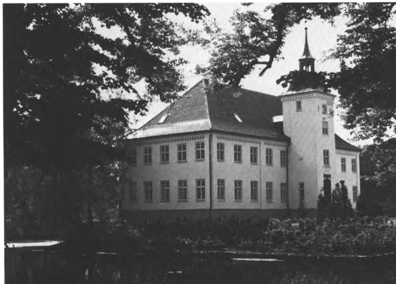
Sådan kom Kjerstrup til at se ud efter den store ombygning 1974.
