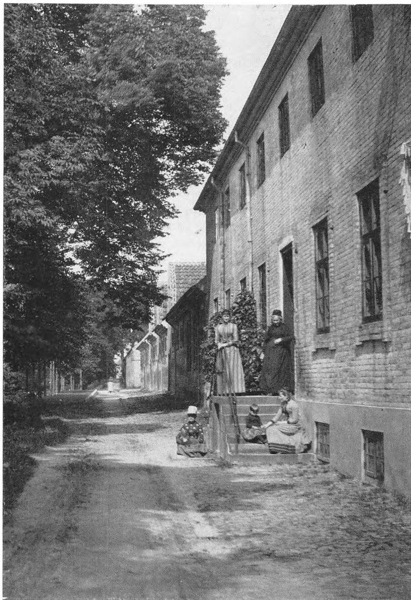
Kavalerbygningen fra 1740'erne, Folchavevej 17-23, i baggrunden Kavalerstalden fra 1730'erne. Fot. ca. 1900.
