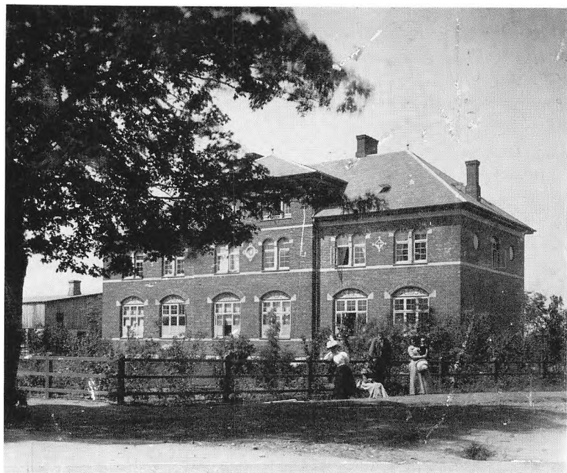
Hørsholm kommuneskole bygget 1897. Denne bygning nedrevet ved udvidelse af skolen 1976. På første sal th. havde F. V. Tryde lejlighed. Fot. ca. 1910.
